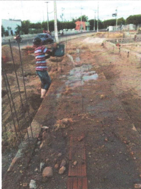
ATERRO PARA EXECUÇÃO DA ARQUIBANCADA.
