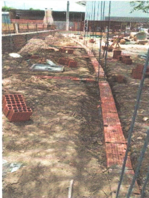
EXECUÇÃO DE ALVENARIAS E ESTRUTURAS DE AÇO PARA ARQUIBANCADAS.
