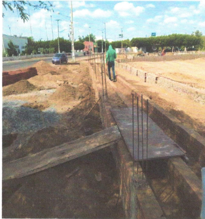
EXECUÇÃO DE ATERRO COM COMPACTAÇÃO MANUAL PARA ARQUIBANCADA.
