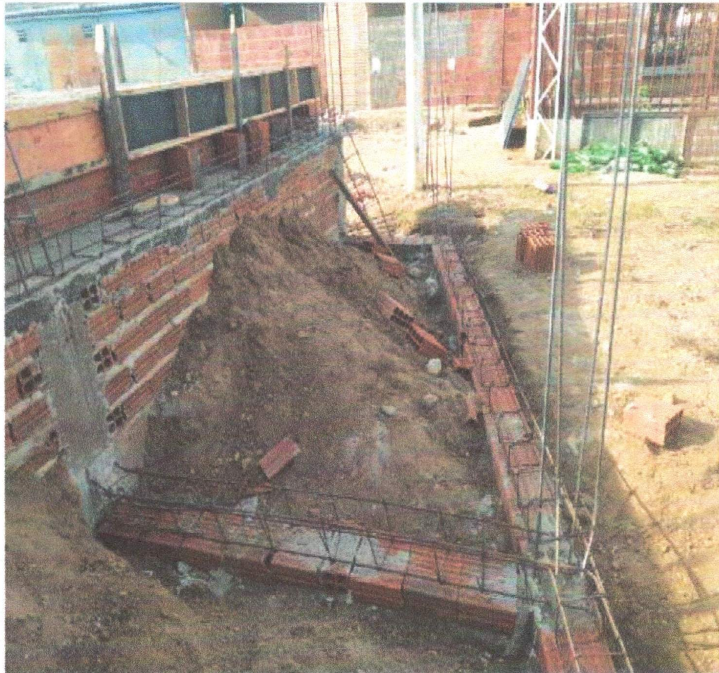
EXECUÇÃO DE ALVENARIAS E ESTRUTURAS DE AÇO PARA ARQUIBANCADAS.
