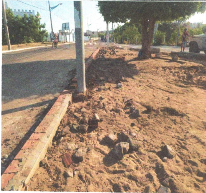
EXECUÇÃO DE BANQUETA (MEIO FIO) PARA IMPLEMENTAÇÃO DO PISO INTERTRAVADO.
