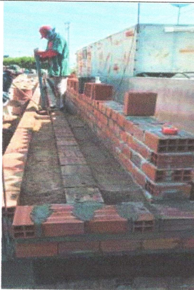
SERVIÇO DE COMPACTAÇÃO MANUAL PARA ATERRO DE ARQUIBANCADAS.
