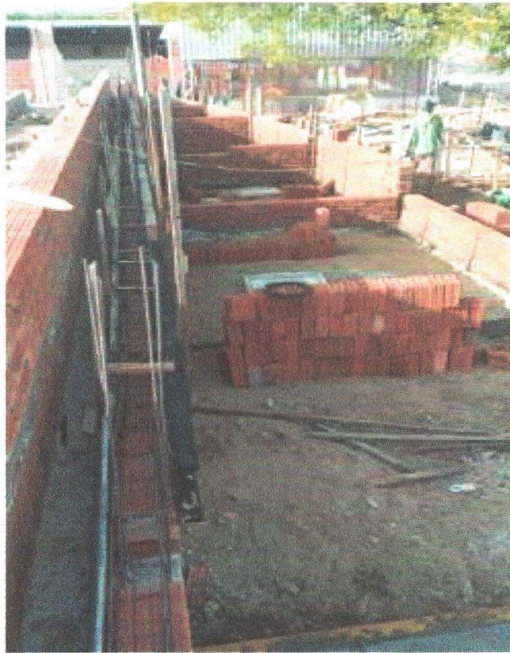
EXECUÇÃO DE ALVENARIAS E ESTRUTURAS DE AÇO PARA ARQUIBANCADAS.
