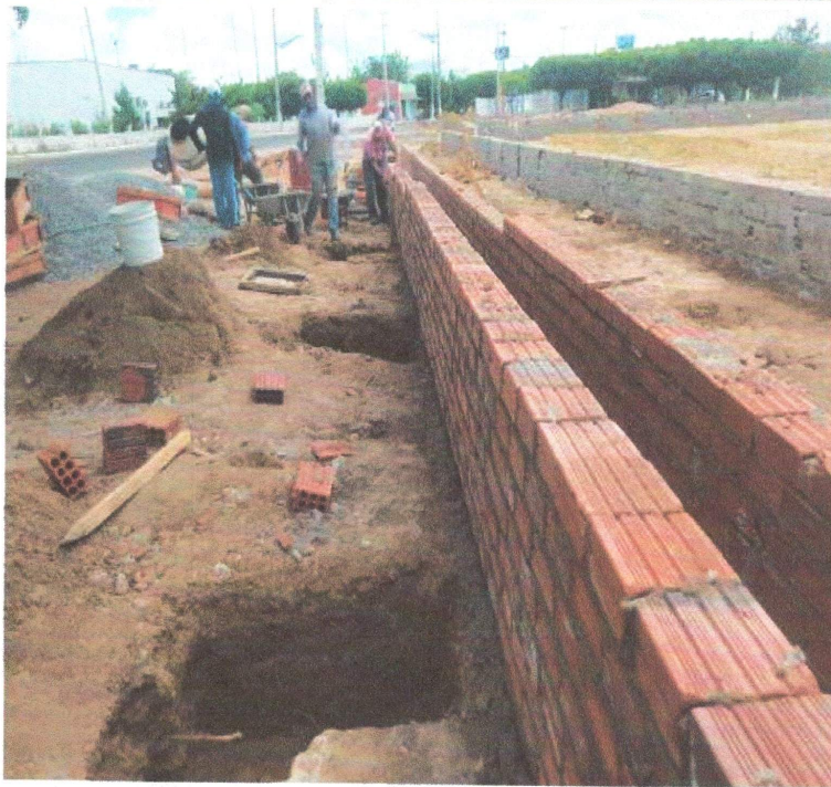
SERVIÇO DE ESCAVAÇÃO E EXECUÇÃO DE BLOCOS DE FUNDAÇÃO PARA ARQUIBANCADA.
