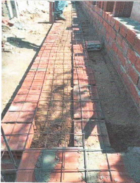
ARMAÇÃO PARA EXECUÇÃO DE LAJE DAS ARQUIBANCADAS.
