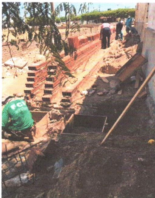
SERVIÇO DE ESCAVAÇÃO E EXECUÇÃO DE BLOCOS DE FUNDAÇÃO PARA ARQUIBANCADA
