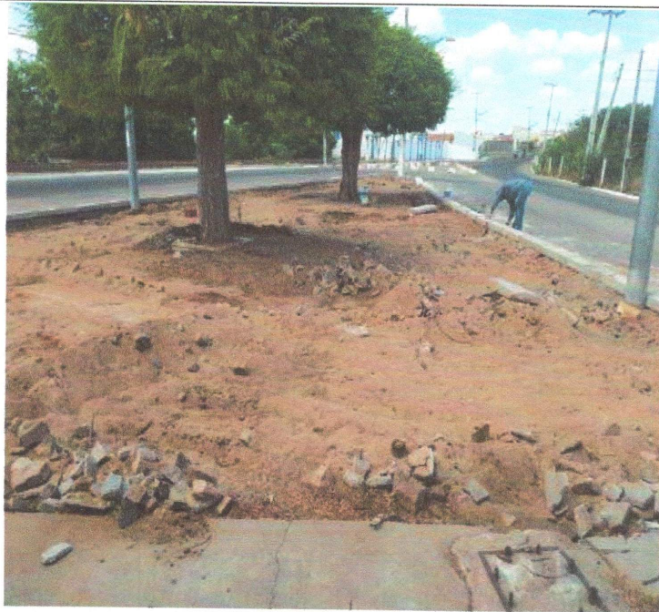
EXECUÇÃO DE BANQUETA (MEIO FICHA) DE RELEVAMENTO DO PISO INTERTRAVADO.
