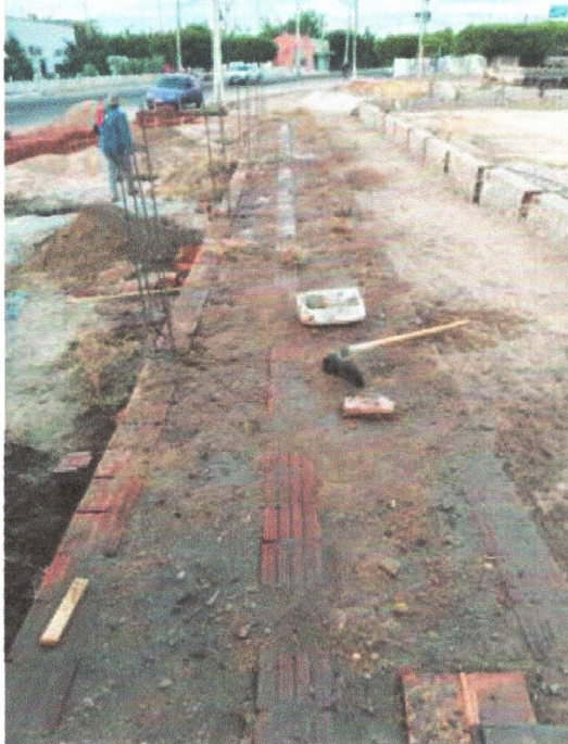
ATERRO PARA EXECUÇÃO DA ARQUIBANCADA.
