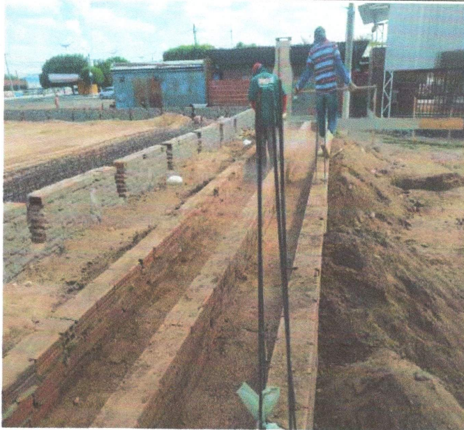
EXECUÇÃO DE ATERRO COM COMPACTAÇÃO MANUAL PARA ARQUIBANCADA.
