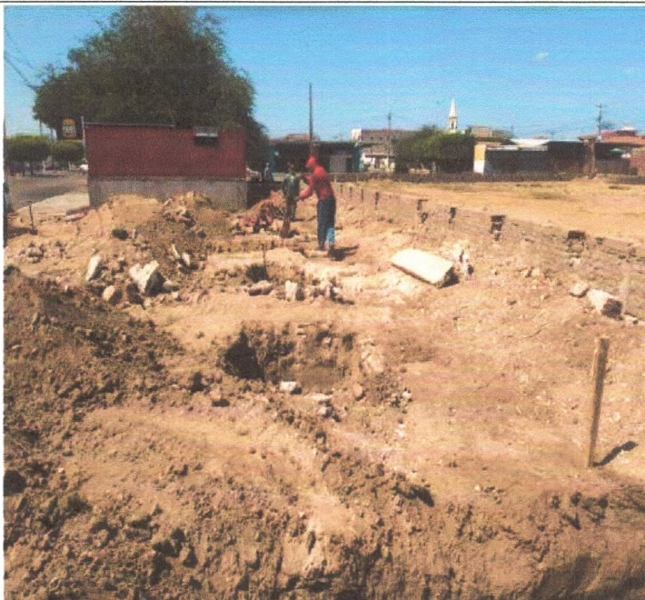
SERVIÇO DE ESCAVAÇÃO E EXECUÇÃO DE BLOCOS DE FUNDAÇÃO
