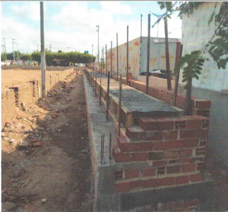
EXECUÇÃO DE ARQUIBANCADAS.
