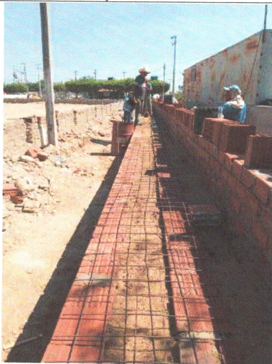
ARMAÇÃO PARA EXECUÇÃO DE LAJE DAS ARQUIBANCADAS.
