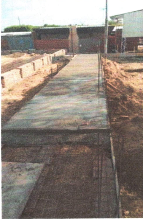
EXECUÇÃO DE ALVENARIAS E ESTRUTURAS DE AÇO PARA ARQUIBANCADAS.
