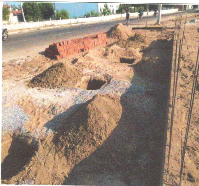
ESCAVAÇÃO PARA IMPLEMENTAÇÃO DA FUNDAÇÃO DO ARCO DA ARQUIBANCADA.
