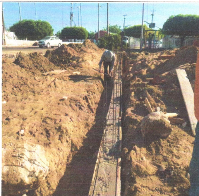
SERVIÇO DE CINTA E ALVENARIAS PARA MURETAS
