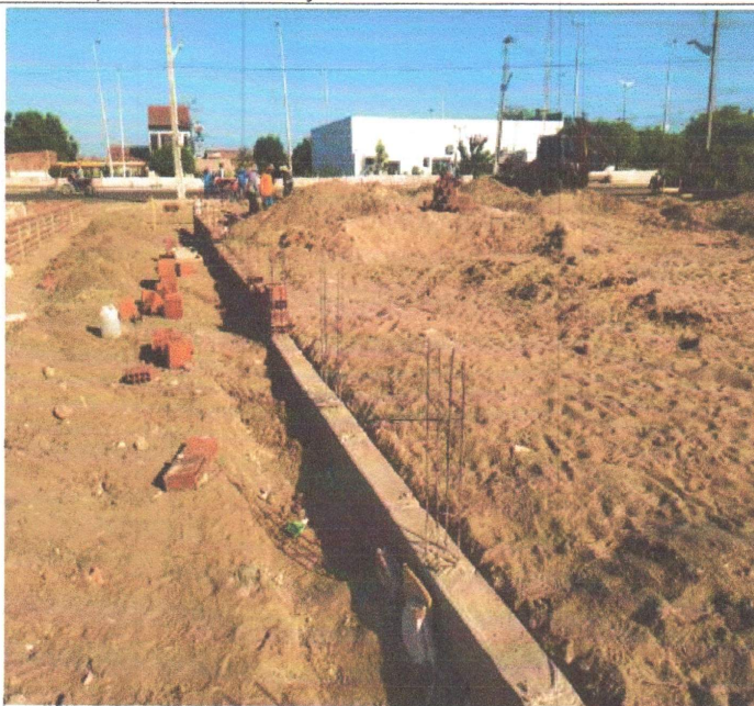
SERVIÇO DE CINTA E ALVENARIAS PARA MURETAS
