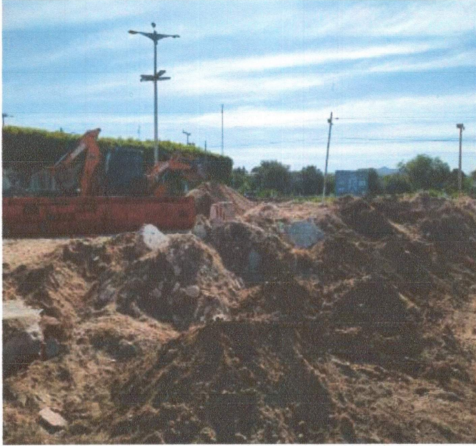
SERVIÇO DE ESCAVAÇÕES E DEMOLIÇÕES
