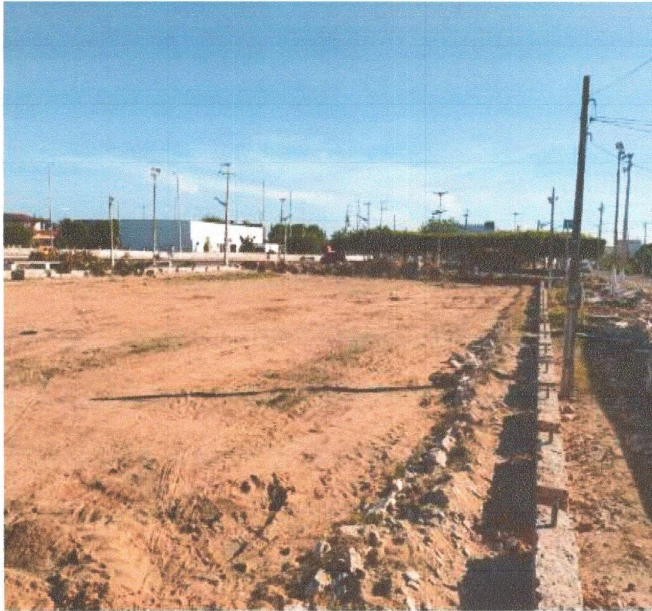
SERVIÇO DE LIMPEZA E RETIRADA DE ENTULHO.
