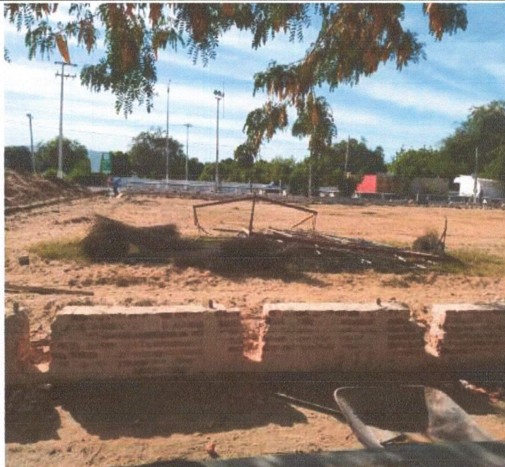
SERVIÇO DE RETIRADA DE ALAMBRADO E REMOÇÃO DE ARGAMASSA.
