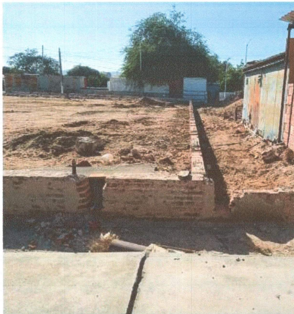
SERVIÇO DE ALVENARIA DAS MURETAS.
