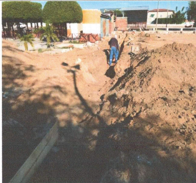
SERVIÇO DE ESCAVAÇÃO DE MURETAS.
