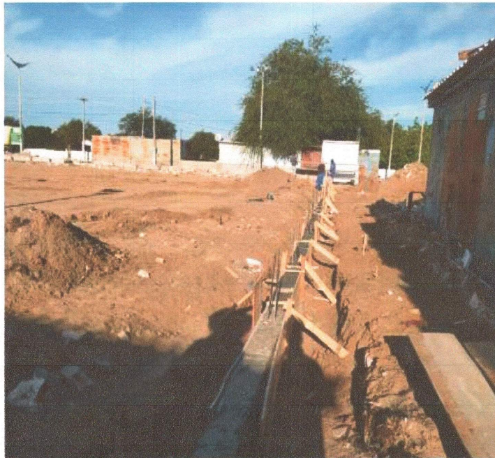
SERVIÇO DE ALVENARIA DE EMBASAMENTO DAS MURETAS.
