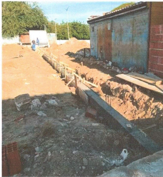
SERVIÇO DE ALVENARIA DAS MURETAS.
