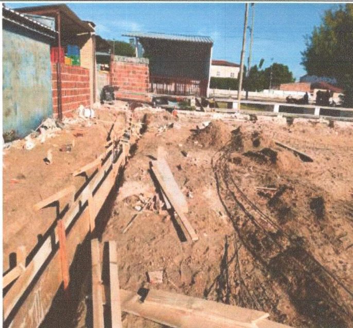
SERVIÇO DE PREPARAÇÃO DE CINTA DAS MURETAS.
