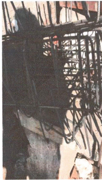
ARMAÇÃO DAS BASES DAS SAPATAS
