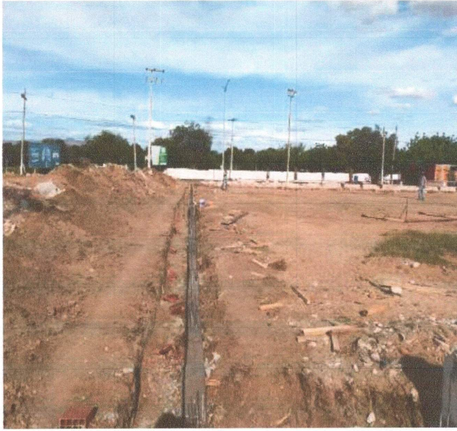
SERVIÇO DE PREPARAÇÃO DE CINTA DAS MURETAS.
