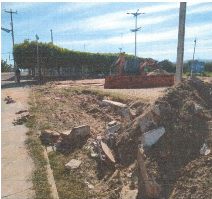
SERVIÇO DE ESCAVAÇÕES E DEMOLIÇÕES
