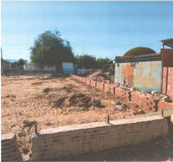
SERVIÇO DE ALVENARIA DE EMBASAMENTO DAS MURETAS.
