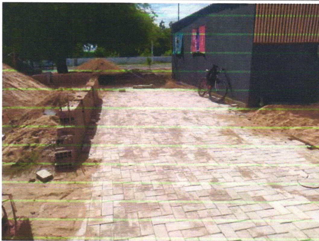
EXECUÇÃO DE PISO INTERTRAVADO.
