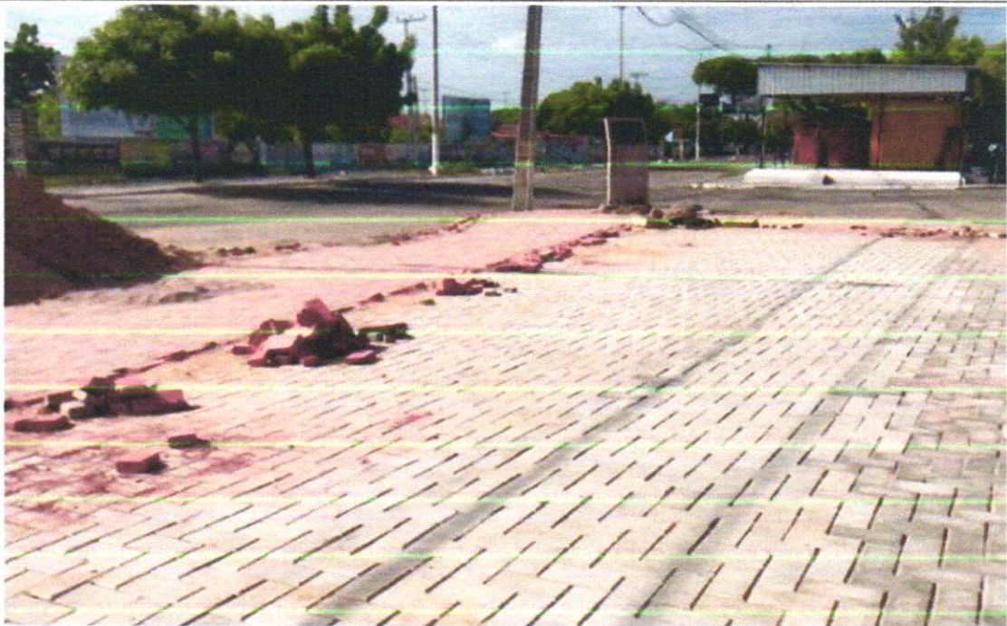
EXECUÇÃO DE PISO INTERTRAVADO.
