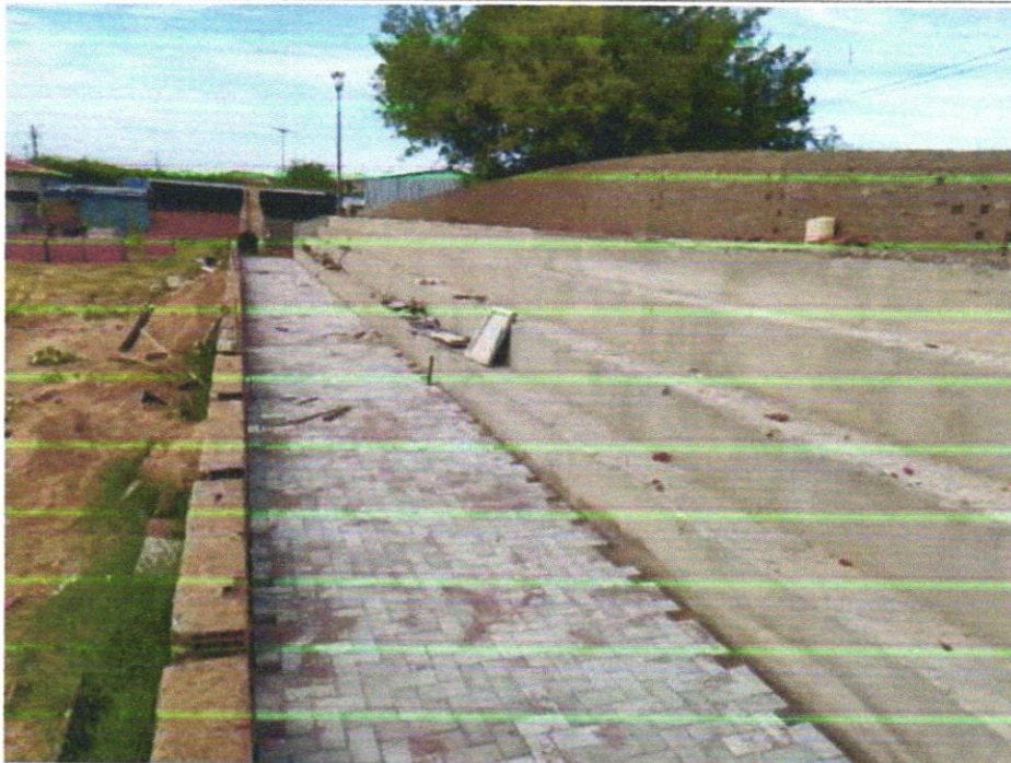
EXECUÇÃO DE PISO INTERTRAVADO.
