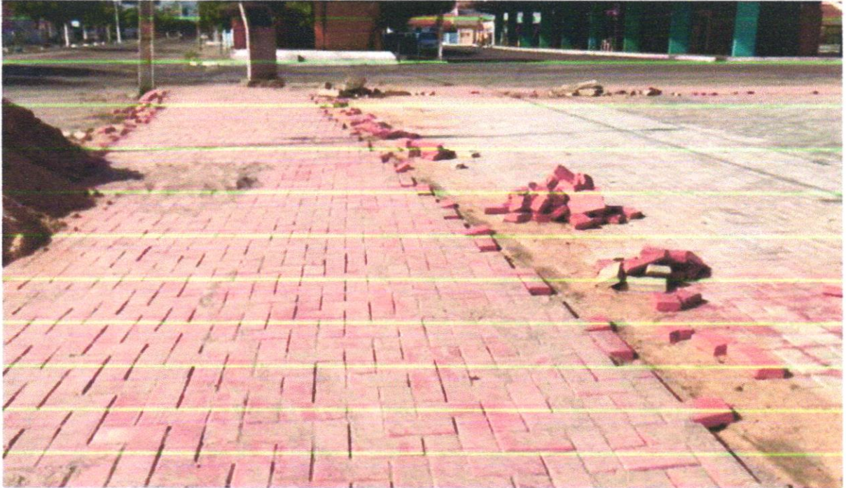
EXECUÇÃO DE PISO INTERTRAVADO.
