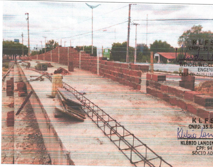
SERVIÇO DE EXECUÇÃO ALVENARIAS E ESTRUTURAS PARA ARQUIBANCADAS.
