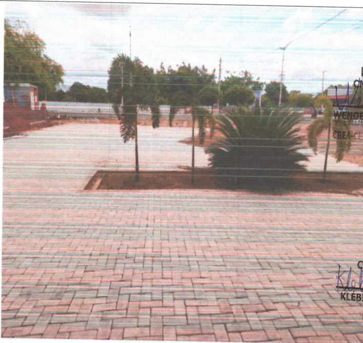
EXECUÇÃO DE PISO INTERTRAVADO.
