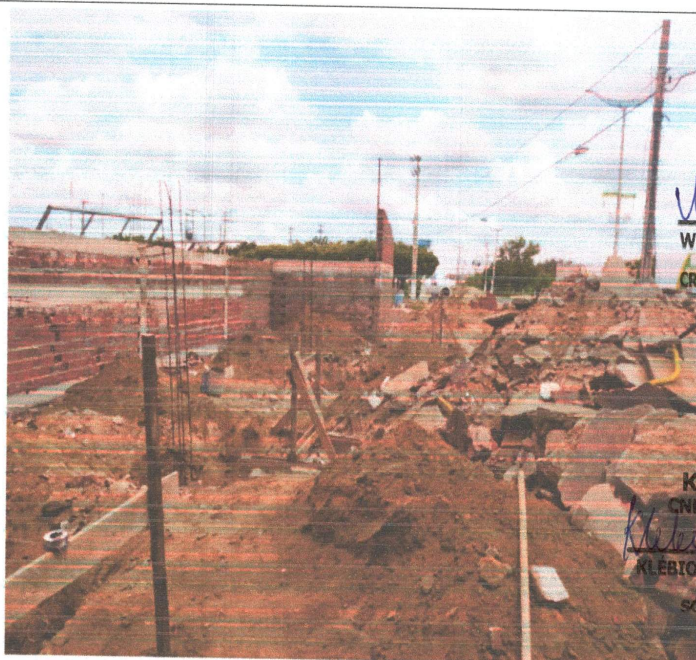
SERVIÇO DE EXECUÇÃO DE DEMOLIÇÃO DE PISO E ESCAVAÇÃO PARA ARQUIBANCADAS.
