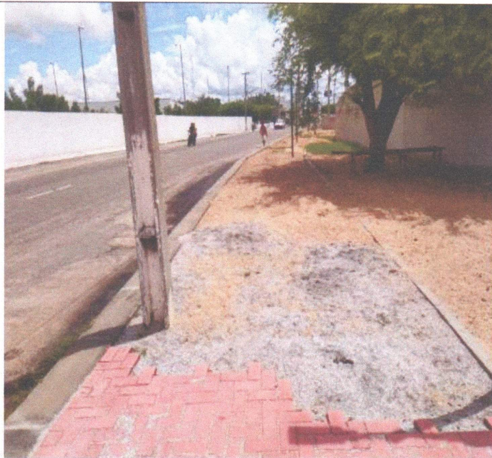
EXECUÇÃO DE PAVIMENTAÇÃO
