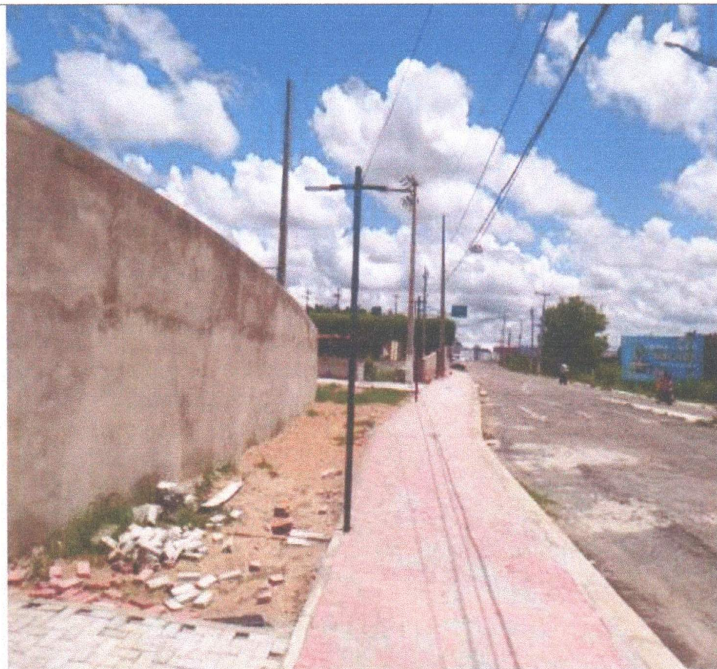
EXECUÇÃO DE PAVIMENTAÇÃO
