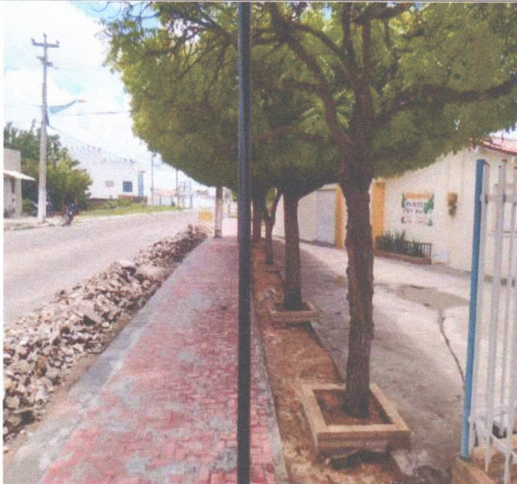
EXECUÇÃO DE PAVIMENTAÇÃO
