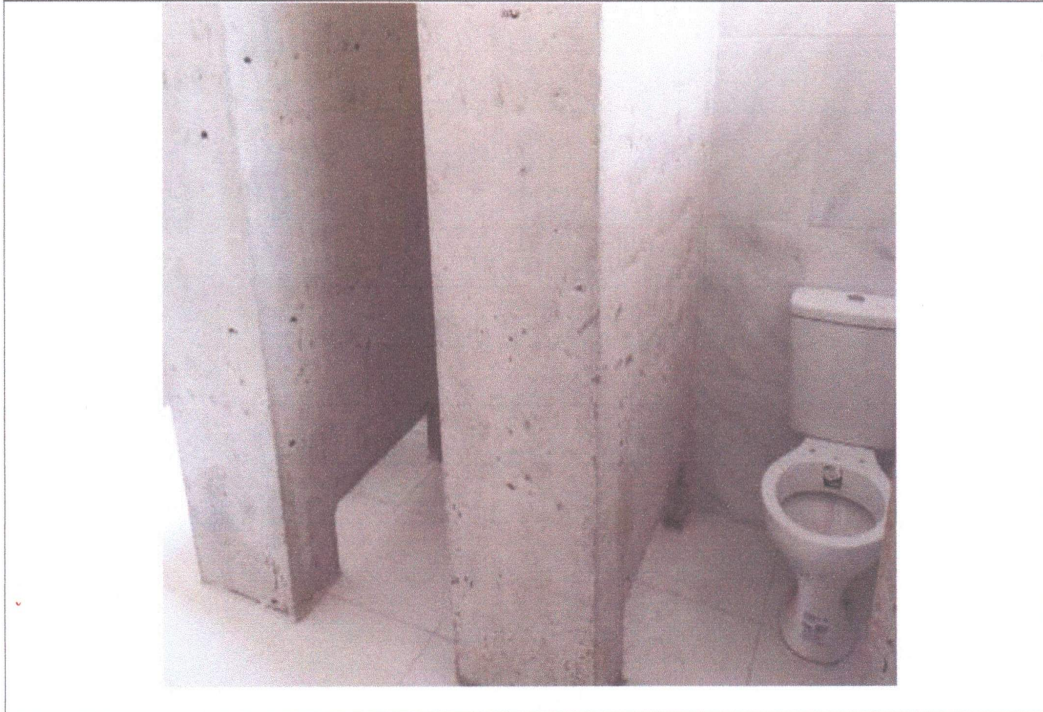
INSTALAÇÃO DE LOUÇAS- VASOS COM CAIXA ACOPLADA
