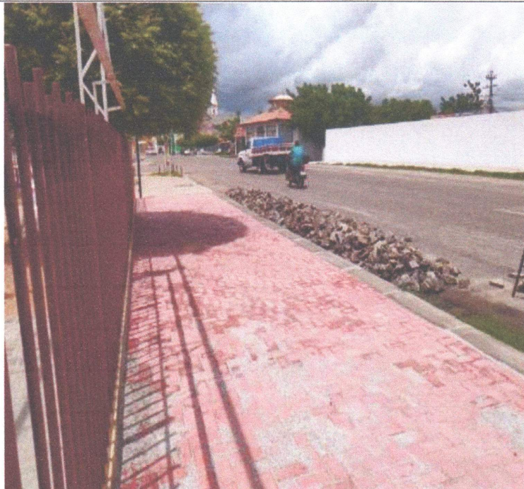
EXECUÇÃO DE PAVIMENTAÇÃO
