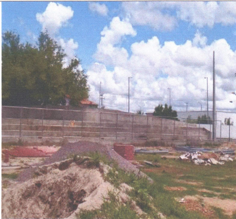
EXECUÇÃO DE ALAMBRADO
