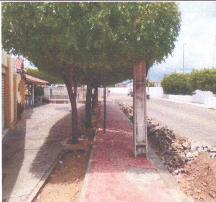
EXECUÇÃO DE PAVIMENTAÇÃO
