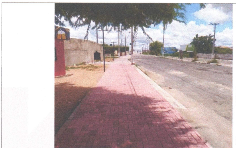
EXECUÇÃO DE PAVIMENTAÇÃO
