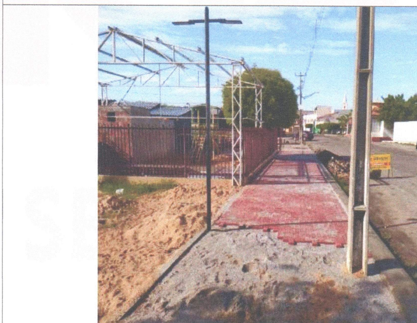
EXECUÇÃO DE PAVIMENTAÇÃO
