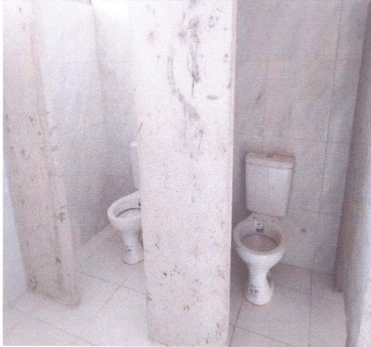
INSTALAÇÃO DE LOUÇAS- VASOS COM CAIXA ACOPLADA
