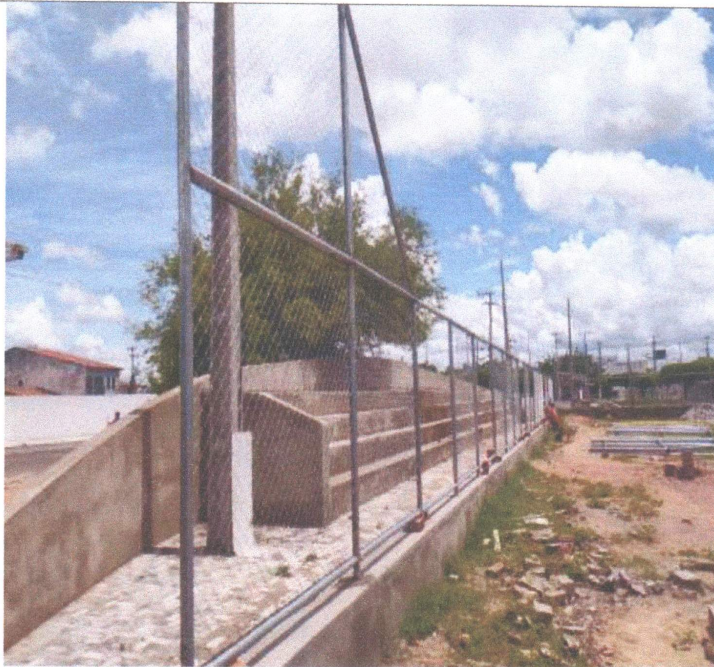
EXECUÇÃO DE ALAMBRADO
