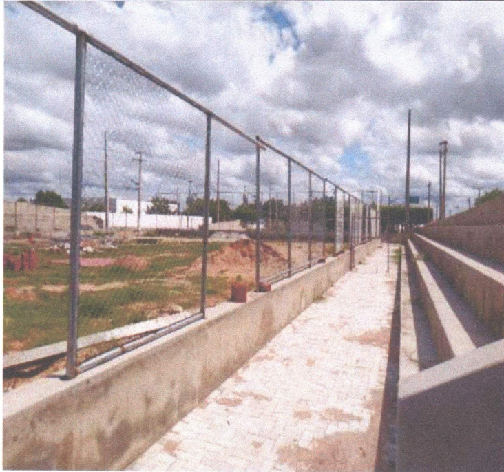
EXECUÇÃO DE ALAMBRADO
