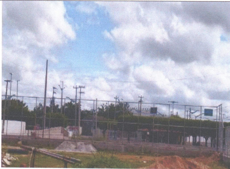
EXECUÇÃO DE ALAMBRADO
