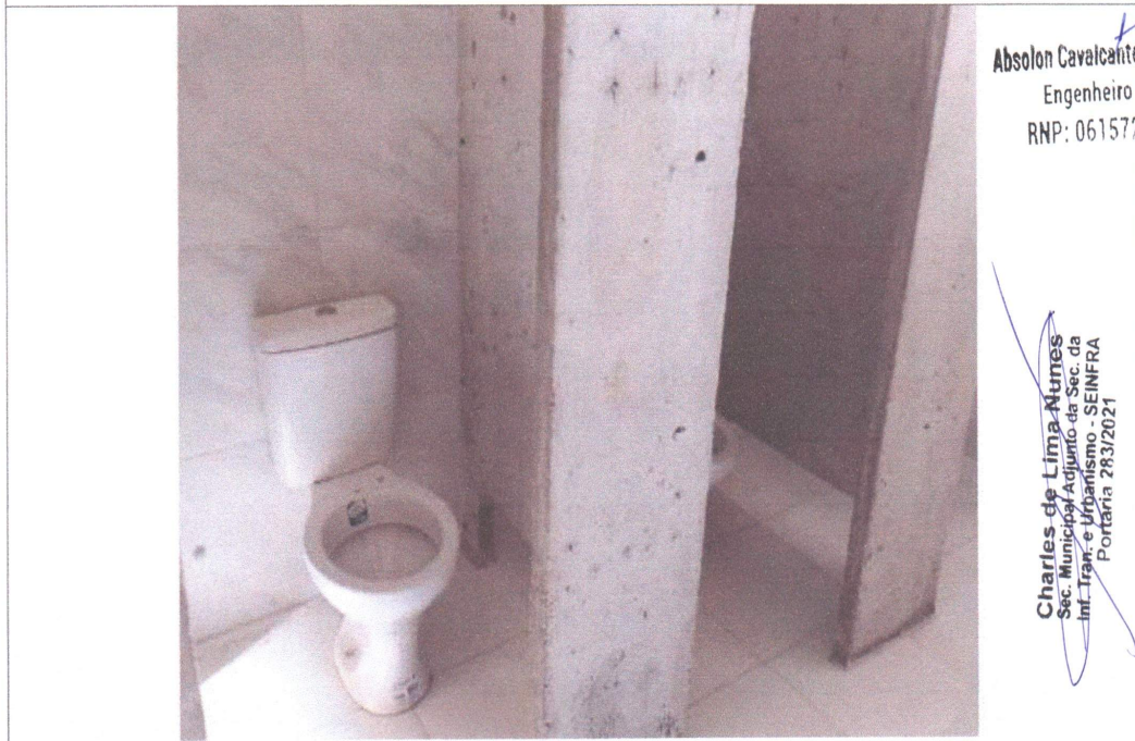
INSTALAÇÃO DE LOUÇAS- VASOS COM CAIXA ACOPLADA
