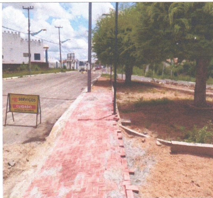
EXECUÇÃO DE PAVIMENTAÇÃO
