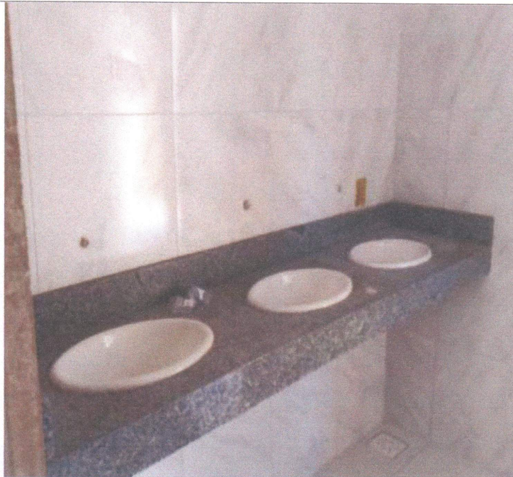
BANCADA DE GRANITO COM CUBAS
