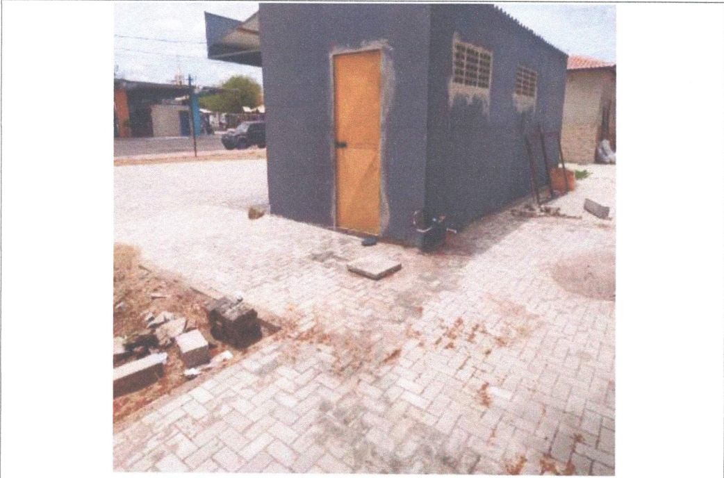
EXECUÇÃO DE PAVIMENTAÇÃO
