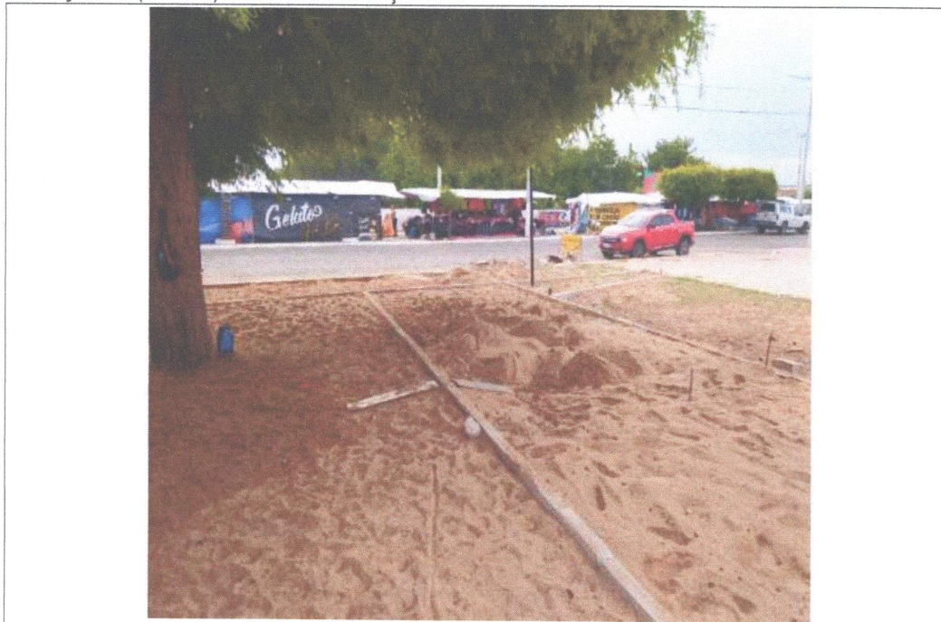
PREPARAÇÃO PARA PAVIMENTAÇÃO
