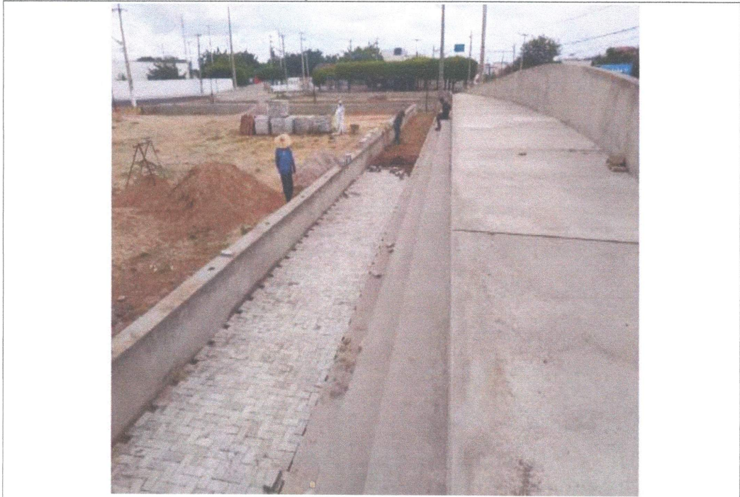
EXECUÇÃO DE PAVIMENTAÇÃO
