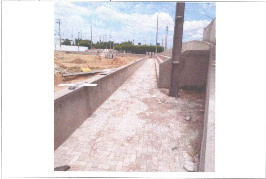
EXECUÇÃO DE PAVIMENTAÇÃO
