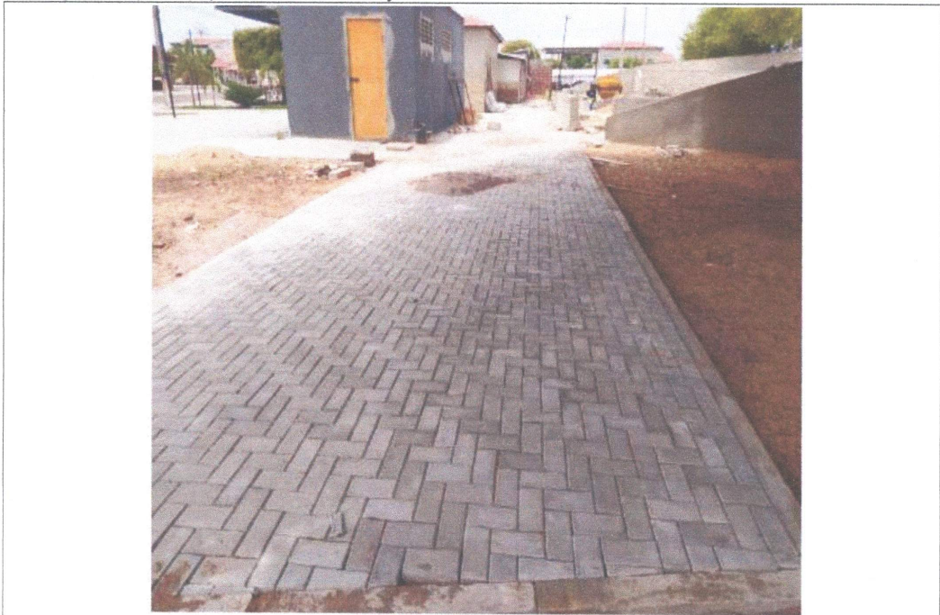
EXECUÇÃO DE PAVIMENTAÇÃO
