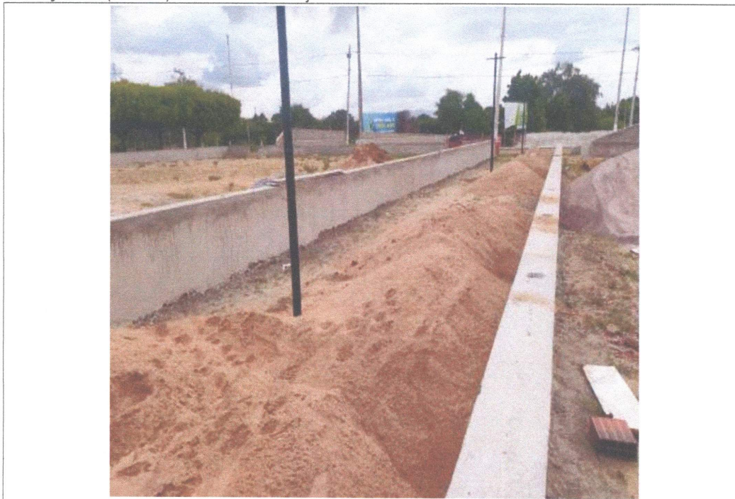
PREPARAÇÃO PARA PAVIMENTAÇÃO
