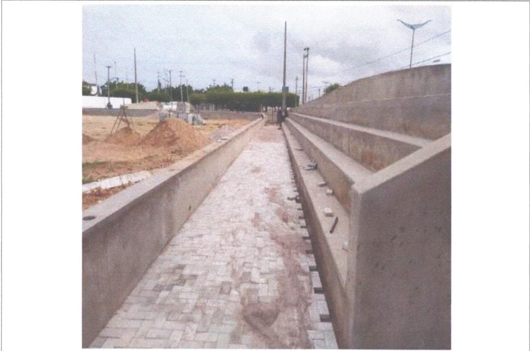
EXECUÇÃO DE PAVIMENTAÇÃO
