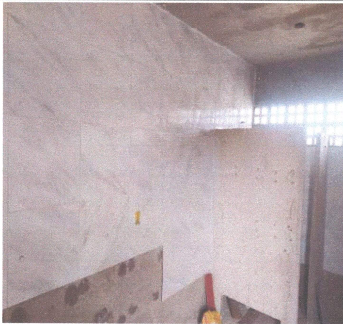
EXECUÇÃO DE REVESTIMENTO CERÂMICO NOS VESTIÁRIOS
