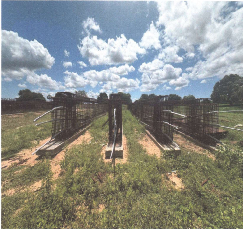
VIGAS COM BAINHAS E CORDOALHAS ARMADAS
