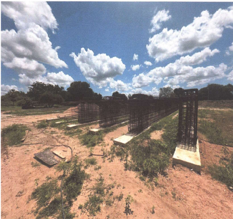
VIGAS COM ARMAÇÃO CONCLUÍDA
