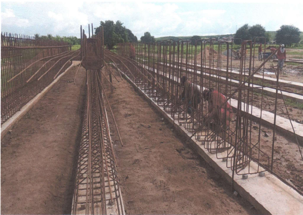
ARMAÇÃO DAS VIGAS
