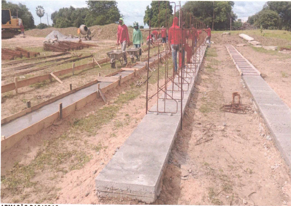
ARMAÇÃO DAS VIGAS
