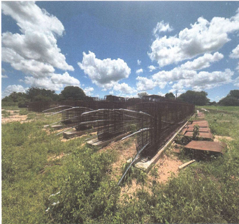
VIGAS COM BAINHAS E CORDOALHAS ARMADAS
