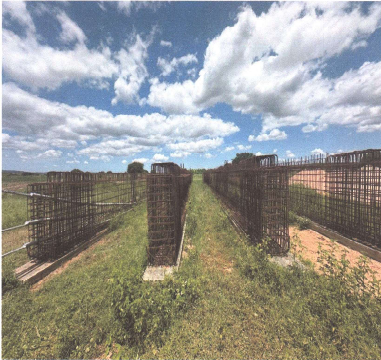
VIGAS COM ARMAÇÃO CONCLUÍDA
