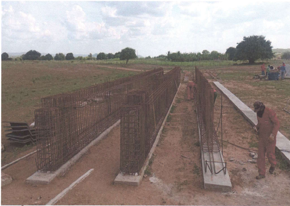
ARMAÇÃO DAS VIGAS
