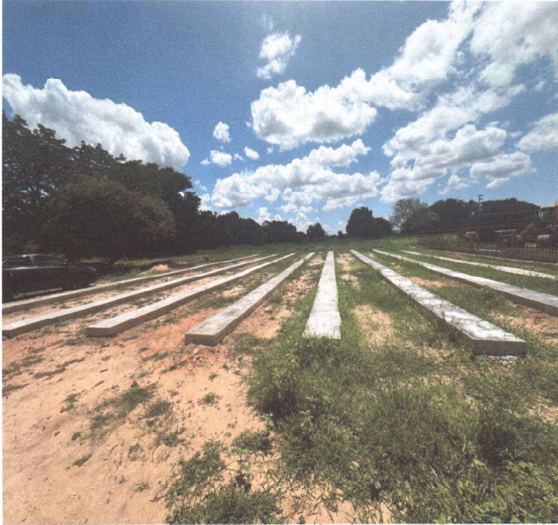
CONSTRUÇÃO DOS BERÇOS DE CONCRETO DO PÁTIO DE FABRICAÇÃO DAS VIGAS
