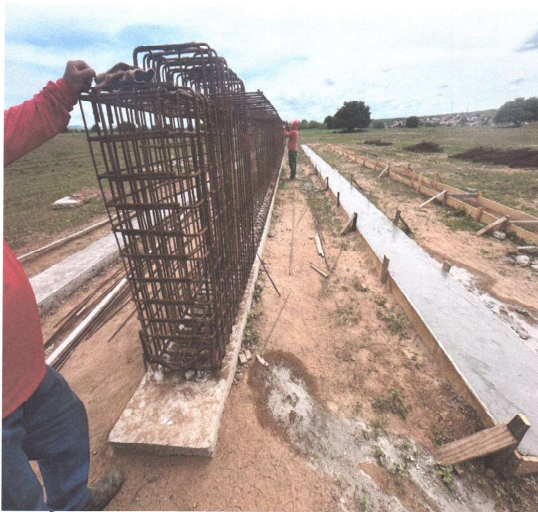
ARMAÇÃO DAS VIGAS
