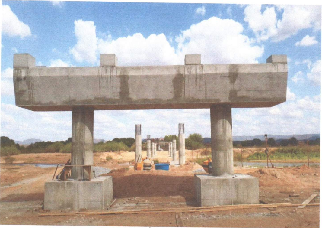
CONSTRUÇÃO DE TRAVESSAS
