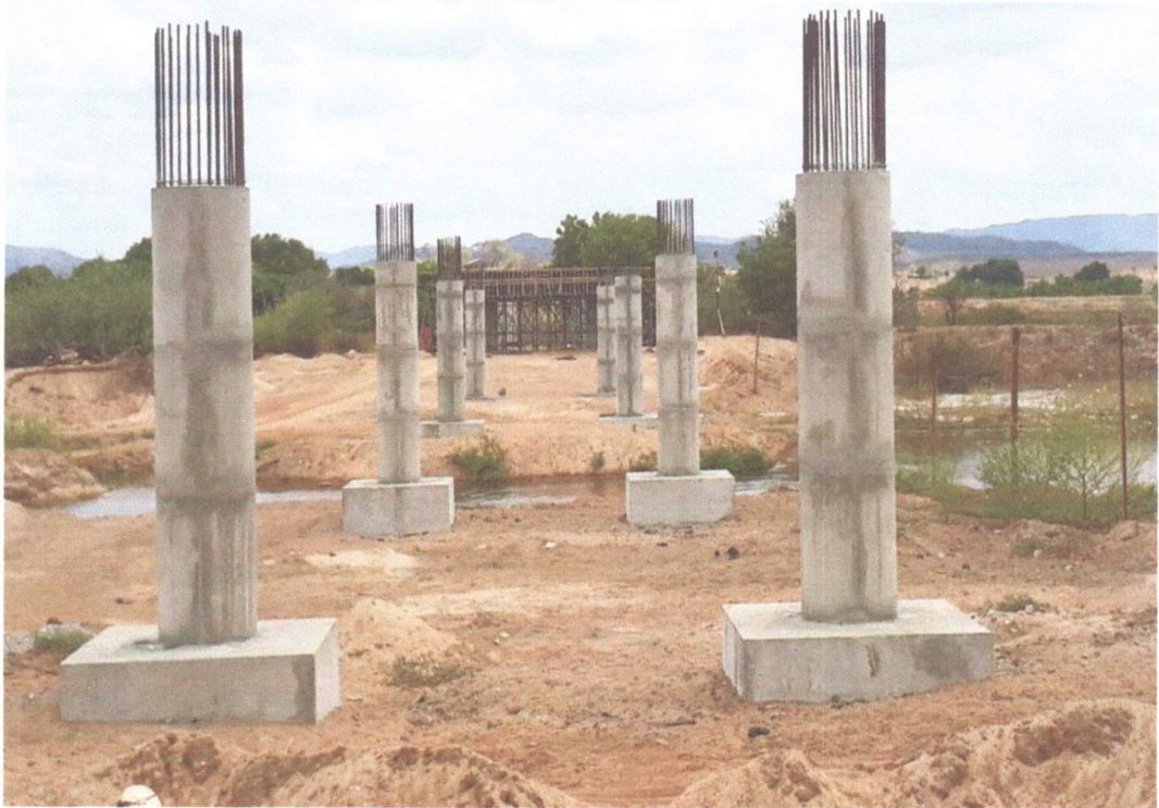
CONSTRUÇÃO DE PILARES
