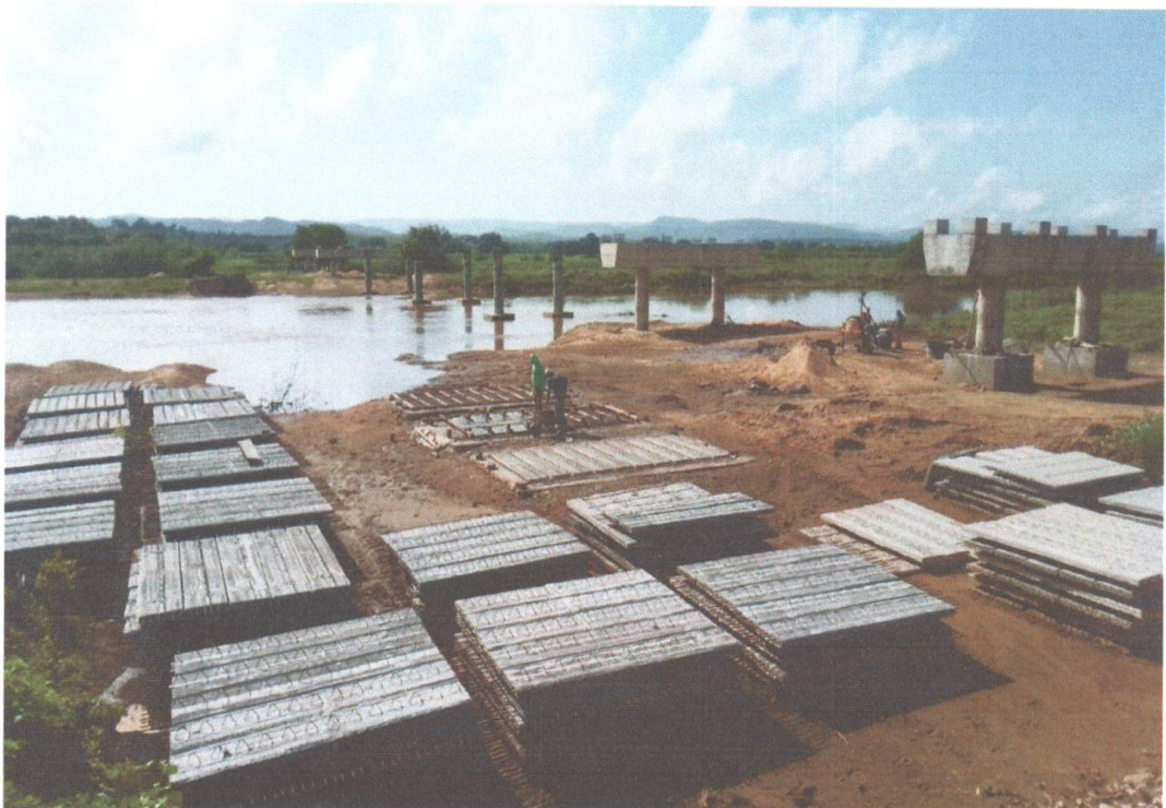
CONSTRUÇÃO DE PRE LAJES
