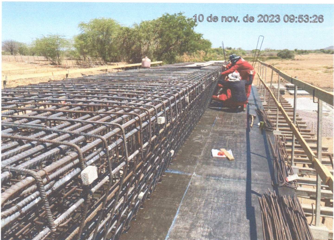
CONSTRUÇÃO DE TRAVESSAS
