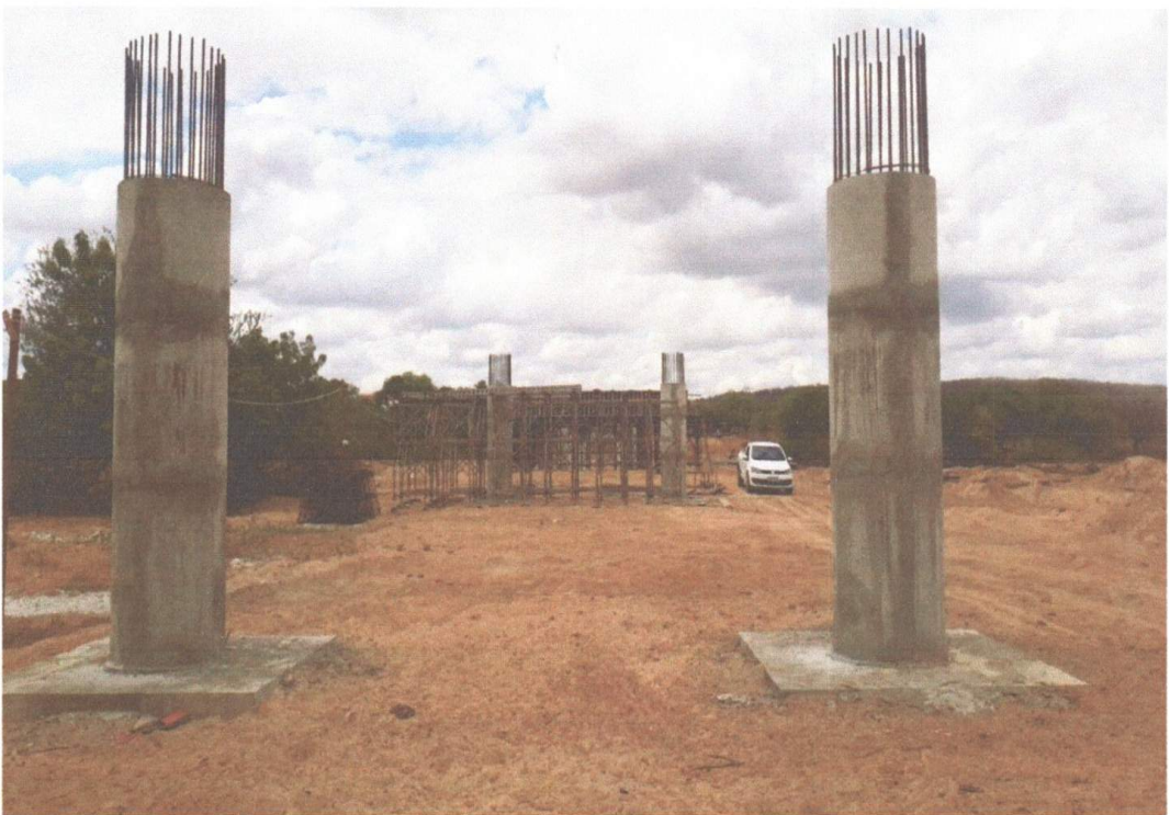
CONSTRUÇÃO DE PILARES
