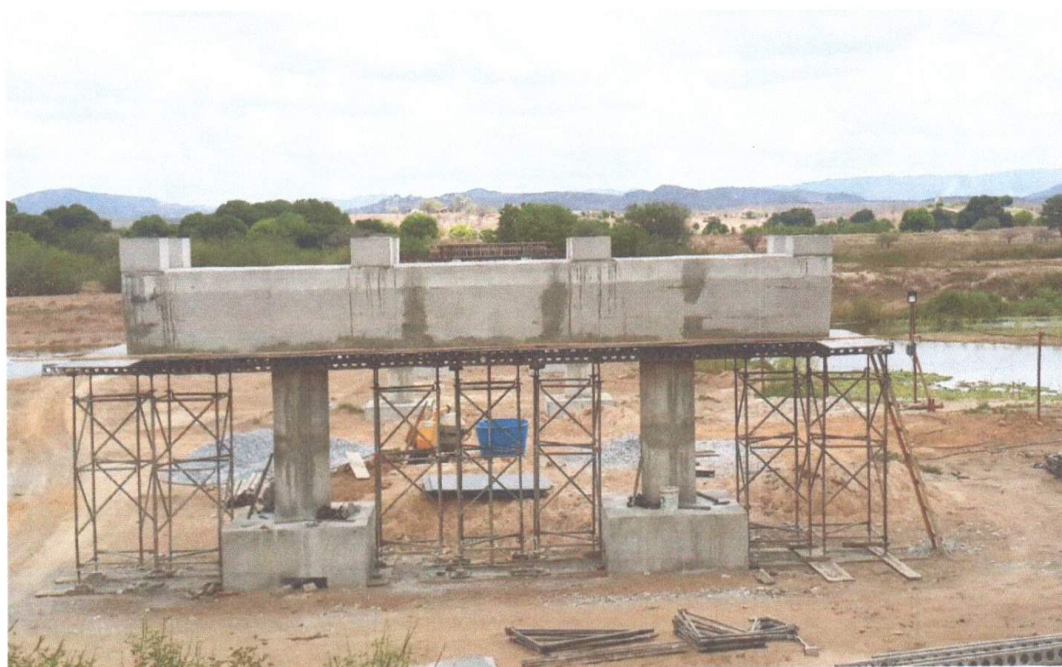
CONSTRUÇÃO DE TRAVESSAS
