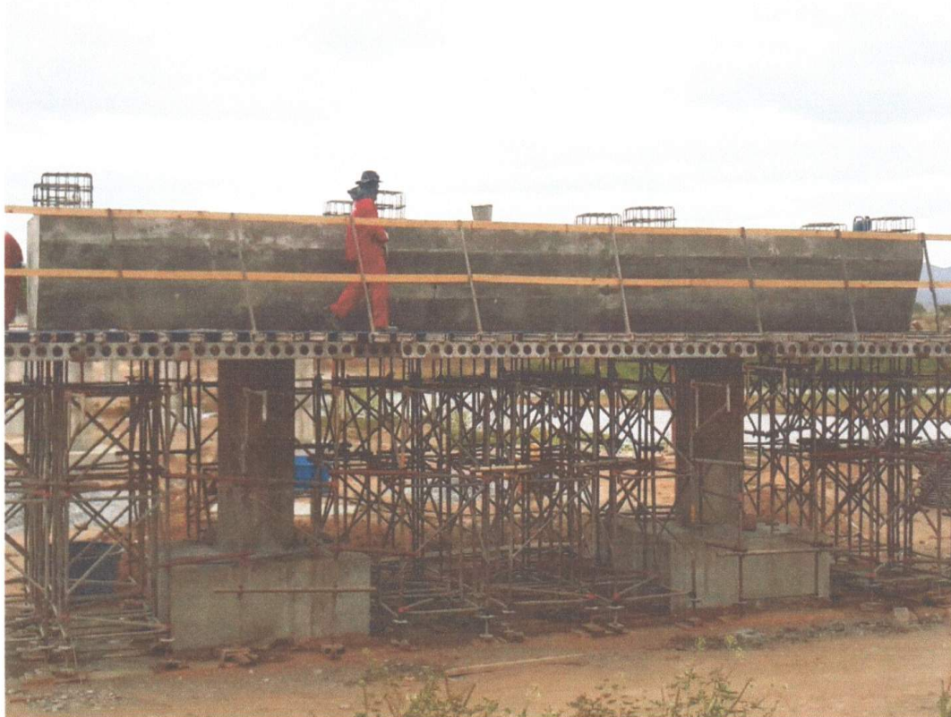
CONSTRUÇÃO DE TRAVESSAS
