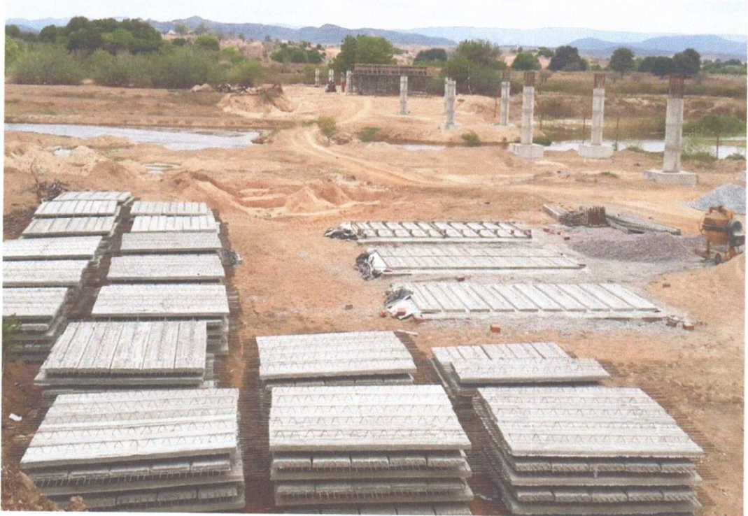
CONSTRUÇÃO DE PRE LAJES
