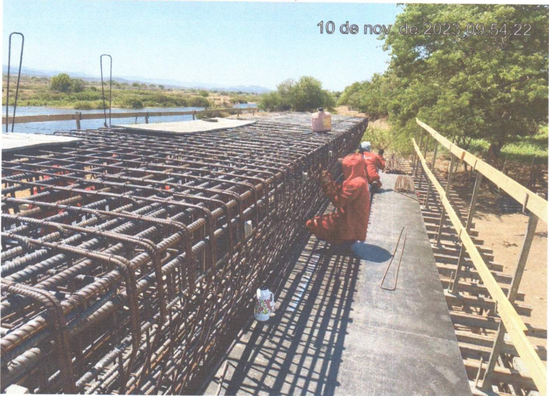
CONSTRUÇÃO DE TRAVESSAS
