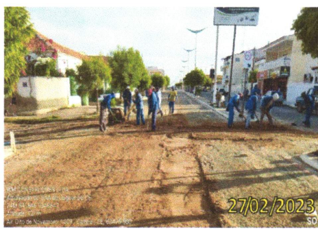
FOTO 3.31 – EXECUÇÃO DE ATERRO E LIMPEZA DA RUA.
