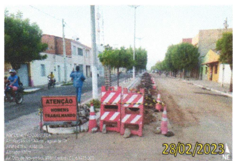
FOTO 3.36 – DETALHAMENTO DA SINALIZAÇÃO APLICADA.
