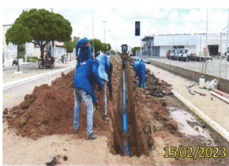
FOTO 3.15 – EXECUÇÃO DAS ESCAVAÇÕES DA VALA.
