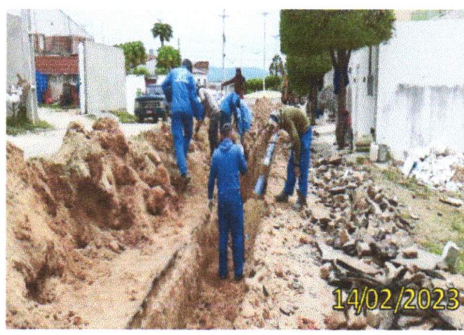
FOTO 3.13 – PANORÂMICA DE CONEXÃO ASSENTADA.
