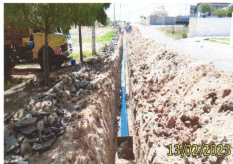
FOTO 3.12 – DETALHES DA EXECUÇÃO DE REATERRO.
