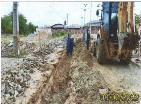
FOTO 3.5 – PANORÂMICA DA EXECUÇÃO DE REATERRO.
