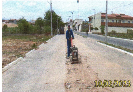
FOTO 3.8 – EXECUÇÃO DE REATERRO.
