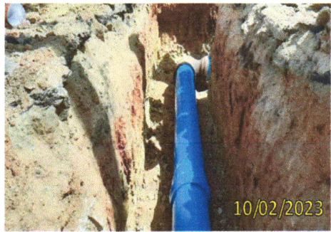
FOTO 3.10 – DETALHAMENTO DAS ESCAVAÇÕES.
