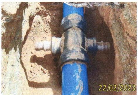
FOTO 3.24 – DETALHE DE CONEXÃO
