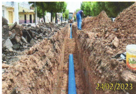
FOTO 3.30 – PANORÂMICA DA EXECUÇÃO DE ATERRO E REATERRO.
