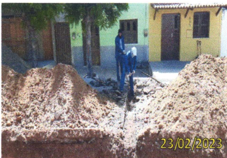
FOTO 4.5 – PANORÂMICA DA ESCAVAÇÕES.
