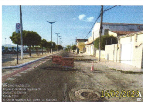
FOTO 3.16 – DETALHES DA SINALIZAÇÃO
