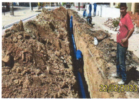
FOTO 3.25 – ASSENTAMENTO DA TUBULAÇÃO.
