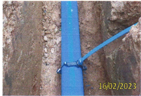
FOTO 4.2 – DETALHAMENTO DA LIGAÇÃO NO TUBO.
