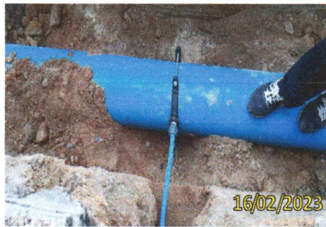
FOTO 4.1 – EXECUÇÃO DE LIGAÇÃO PREDIAL.
