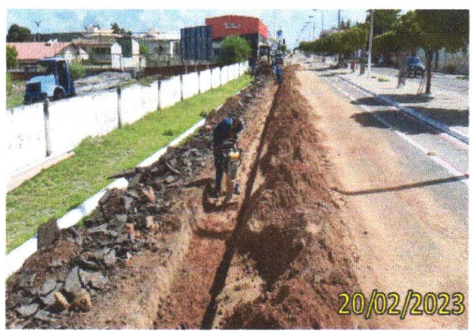
FOTO 3.22 – EXECUÇÃO DA COMPACTAÇÃO DE ATERRO E REATERRO.
