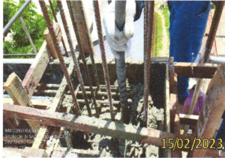
FOTO 2.1 – DETALAMENTO DA CONCRETAGEM DE PILARES.
