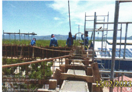
FOTO 2.2 – DETALHES DE VIGA CONCRETADA.
