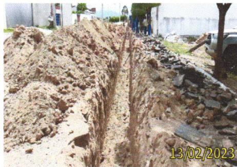
FOTO 3.11 – PANORÂMICA DA TUBULAÇÃO ASSENTADA.
