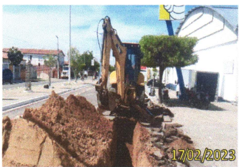
FOTO 3.18 – DETALHES DAS ESCAVAÇÕES DE VALAS.
