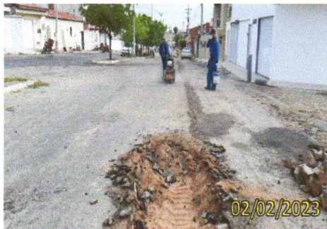
FOTO 3.2 – RETIRADA DE CAPA ASFÁLTICA COM BASE DE PEDRA.
