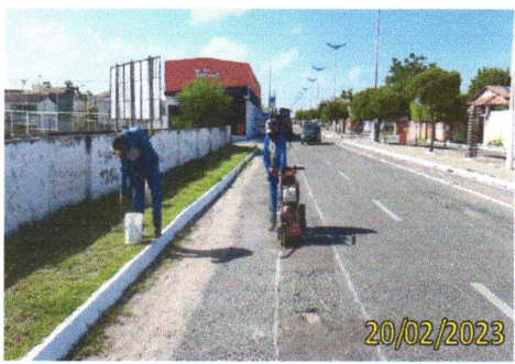
FOTO 3.21 – RETIRADA DE CAPA ASFÁLTICA.
