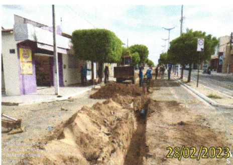
FOTO 3.35 – EXECUÇÃO DE ATERRO E REATERRO.
