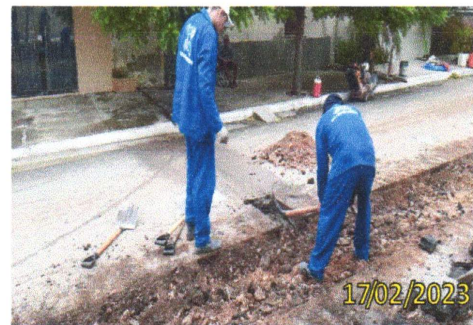
FOTO 4.4 – ESCAVAÇÃO DE LIGAÇÃO PREDIAL.
