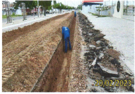
FOTO 3.20 – EXECUÇÃO DE RATERRO.
