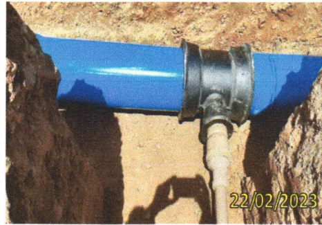
FOTO 3.26 – ASSENTAMENTO DE CONEXÕES.
