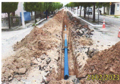
FOTO 3.29 – DETALHAMENTO DA TUBULAÇÃO ASSENTADA.
