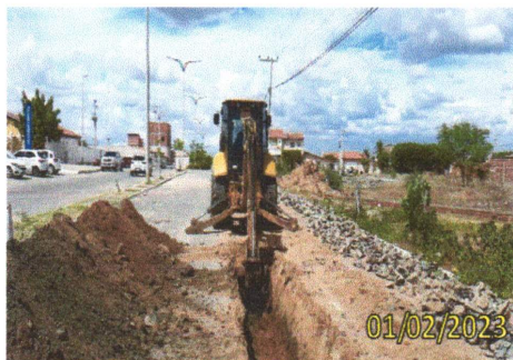
FOTO 3.1 – ESCAVAÇÃO DE VALAS.
