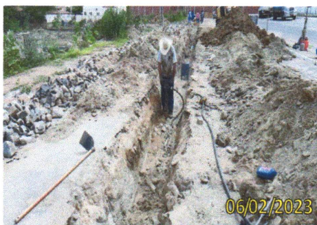
FOTO 3.3 – ESCAVAÇÃO DE ROCHA BRANDA A FRIO COM AUXÍLIO DE ROMPEDOR PNEUMÁTICO.
