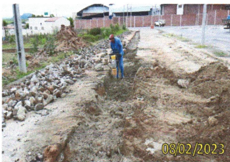
FOTO 3.4 – EXECUÇÃO DE REATERRO COM COMPACTAÇÃO DA VALA.
