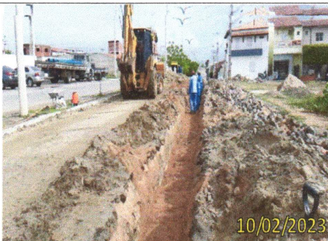
FOTO 3.6 – EXECUÇÃO DE ATERRO COM MATERIAL DE AQUISIÇÃO.
