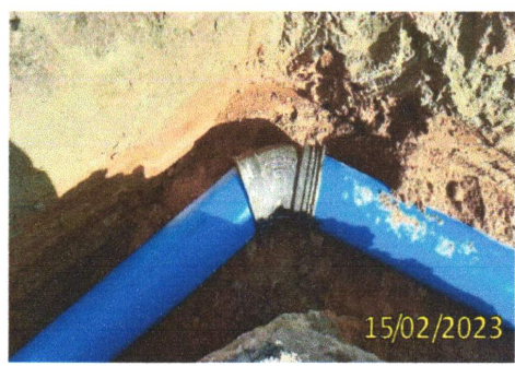
FOTO 3.14 – DETALHE DE CONEXÃO ASSENTADA.
