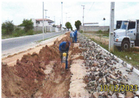
FOTO 3.9 – PANORÂMICA DA RECOMPOSIÇÃO DA PAVIMENTAÇÃO.
