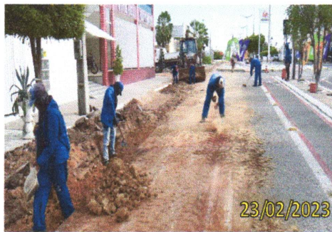
FOTO 3.28 – EXECUÇÃO DE REATERRO.
