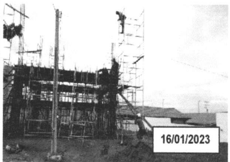
FOTO 4.24 – MONTAGEM DAS FERRAGENS DO SEGUNDO NÍVEL DOS PILARES INTERMEDIÁRIOS.
