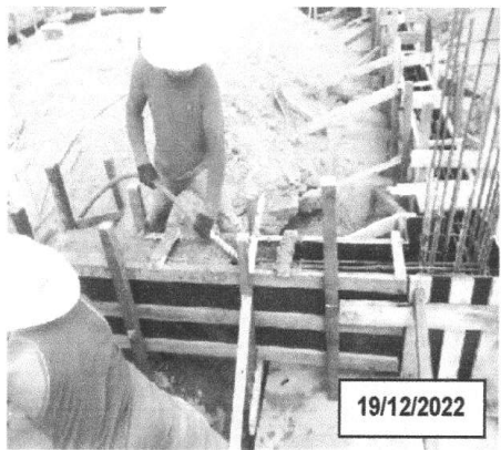
FOTO 4.10 – CONCRETAGEM DAS VIGAS BALDRAMES.
