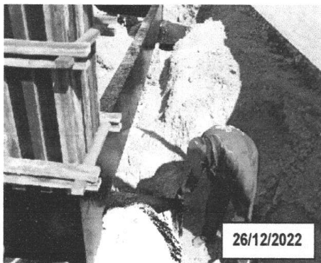
FOTO 4.12 – APLICAÇÃO DA IMPERMEABILIZAÇÃO NAS VIGAS E SAPATAS
