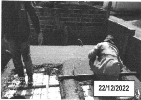
FOTO 3.5 – CONCRETAGEM DA LAJE DE EPS.
