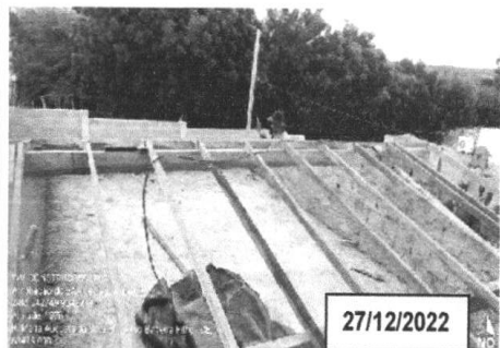
FOTO 3.6 – EXECUÇÃO DO MADEIRAMENTO DA COMBERTA DA CASA DE BOMBAS DO RAP.
