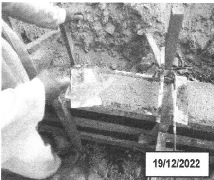
FOTO 4.11 – ACABAMENTO DA CONCRETAGEM DAS VIGAS BALDRAMES
