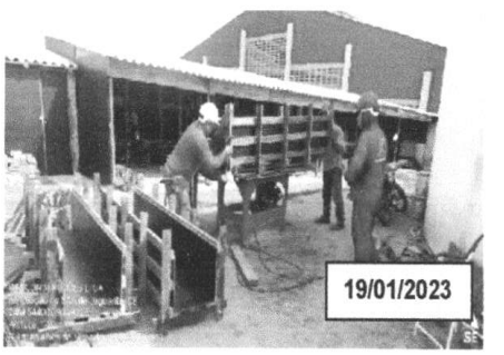
FOTO 4.26 – MONTAGEM DAS FORMAS DOS PILARES INTERMEDIÁRIOS DO SEGUNDO NÍVEL.
