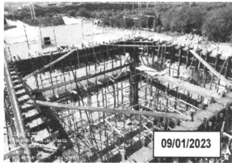
FOTO 4.22 – VIGAS INTERMEDIÁRIAS CONCRETADAS.
