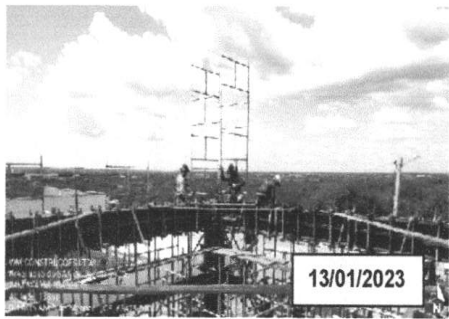
FOTO 4.23 – MONTAGEM DOS ANDAIMES PARA EXCUÇÃO DAS FORMAS E FERRAGENS DO SEGUNDO NÍVEL DAS VIGAS INTERMEDIÁRIAS.
