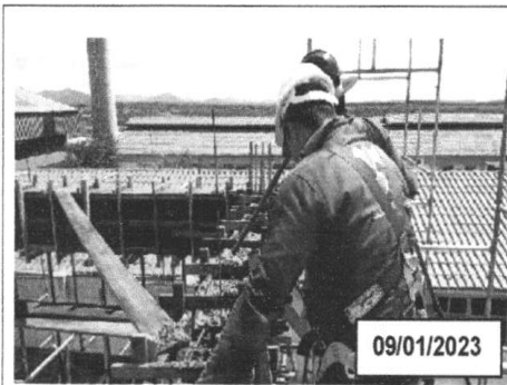
FOTO 4.21 – CONCRETAGEM DAS FORMAS DAS VIGAS INTERMEDIÁRIAS.
