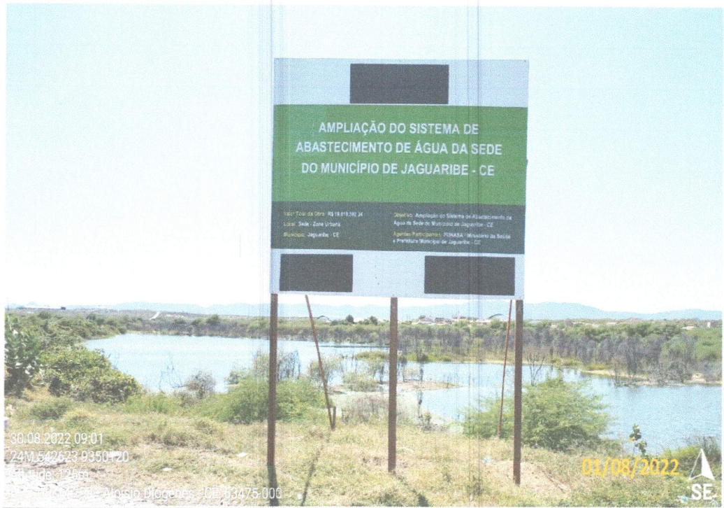
FOTO 1.1- PLACA DA OBRA
