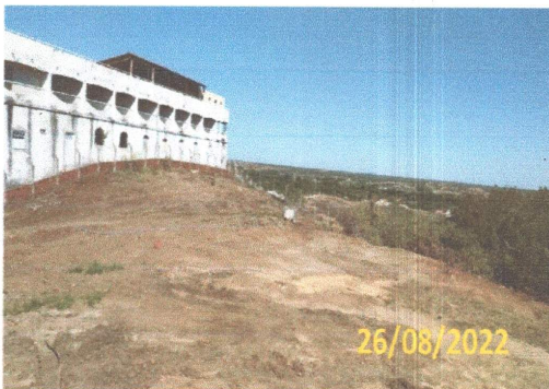
FOTO 3.7- LIMPEZA, ESCAVAÇÃO E REGULARIZAÇÃO DO TERRENO.
