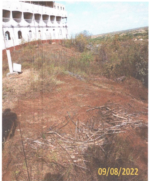
FOTO 3.2- LIMPEZA DO TERRENO.
