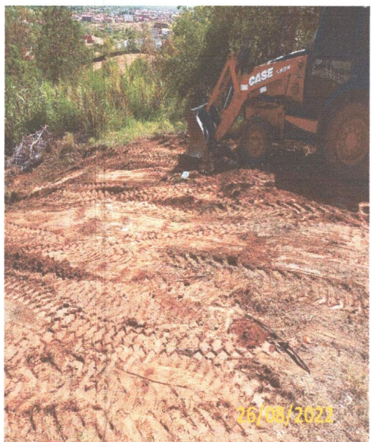
FOTO 3.4- ESCAVAÇÃO E REGULARIZAÇÃO DO TERRENO.
