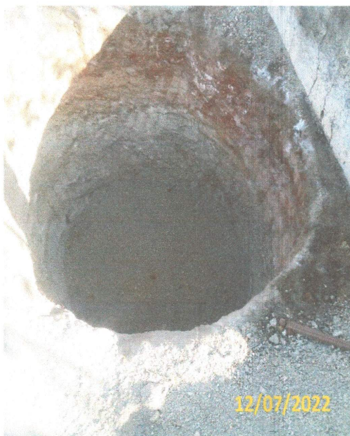
FOTO 2.3- ESCAVAÇÃO DA FOSSA DOS BANHEIROS DO BARRACÃO.
