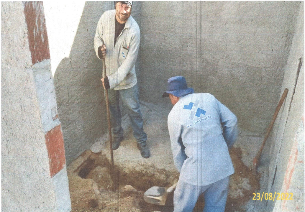
FOTO 2.7- EXECUÇÃO DE INSTALAÇÃO SANITÁRIA
