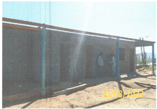
FOTO 2.6- EXECUÇÃO DA COBERTA.
