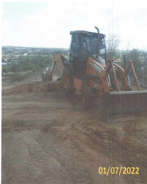
FOTO 2.1- LIMPEZA DO TERRENO.
