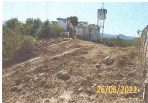
FOTO 3.6- LIMPEZA, ESCAVAÇÃO E REGULARIZAÇÃO DO TERRENO.
