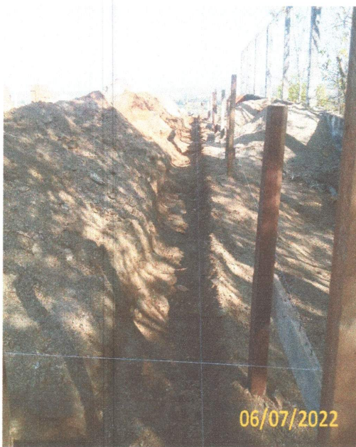
FOTO 2.2- ESCAVAÇÃO PARA A CONSTRUÇÃO DO CANTEIRO DE OBRAS.
