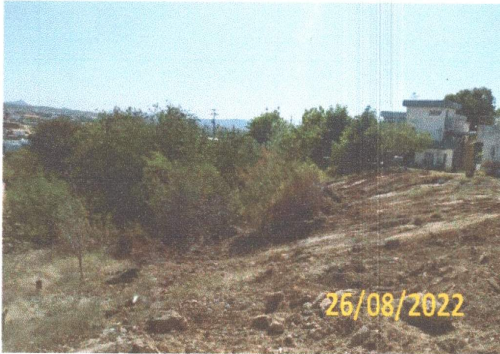
FOTO 3.5- LIMPEZA, ESCAVAÇÃO E REGULARIZAÇÃO DO TERRENO.
