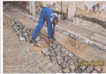
FOTO 2.4 – DETALHAMENTO DA RECOMPOSIÇÃO DE PAVIMENTAÇÃO EM PARALELO.
