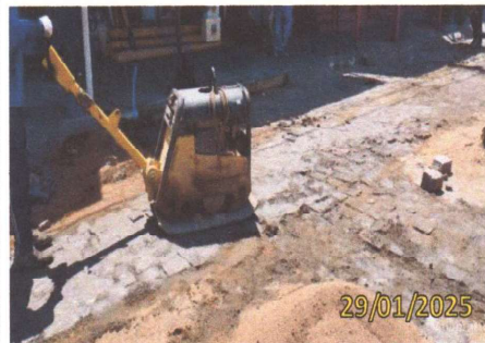
FOTO 2.5 – EXECUÇÃO DA COMPACTAÇÃO DA PAVIMENTAÇÃO.
