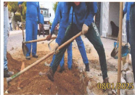
FOTO 2.2 – DETALHAMENTO DA EXECUÇÃO.
