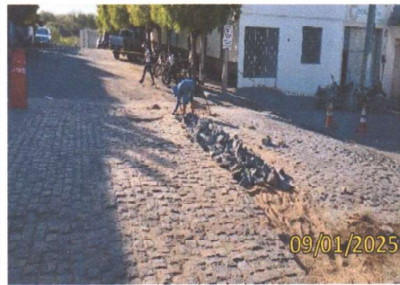
FOTO 2.3 – EXECUÇÃO DE RECOMPOSIÇÃO DE PAVIMENTAÇÃO EM PARALELO.
