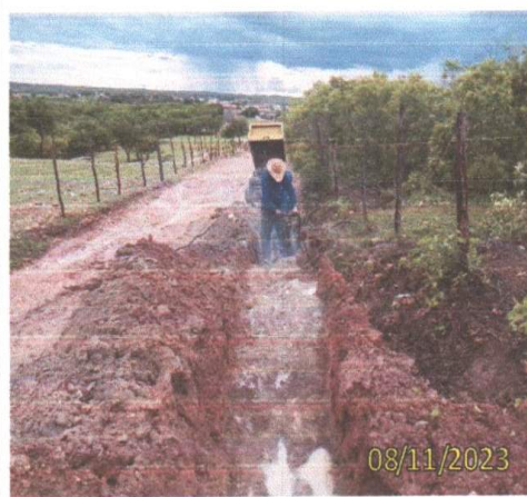
FOTO 3.12 – VISTA FRONTAL DA ESCAVAÇÃO COM O COMPRESSOR PNEUMÁTICO.
