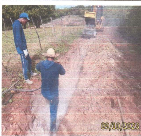
FOTO 3.1 – RETIRADA DE ROCHA COM AUXÍLIO DO ROMPEDOR PNEUMÁTICO MANUAL.
