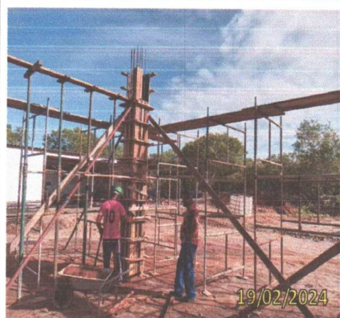
FOTO 1.22 – VISTA EM PERSPECTIVA DAS FORMAS DAS VIGAS.
