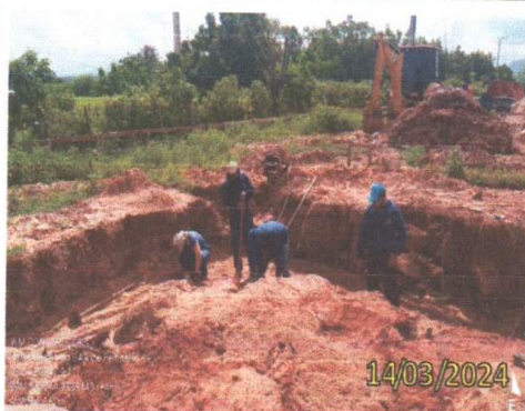
FOTO 4.17 – ESCAVAÇÃO DO POÇO DE SUÇÃO.
