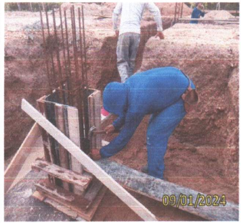
FOTO 1.16 – MONTAGEM DAS FORMAS.
