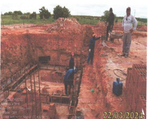
FOTO 4.22 – VISTA FRONTAL DA CONCRETAGEM DAS VIGAS BALDRAMES.
