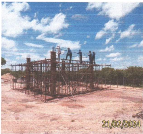
FOTO 1.23 – VISTA EM PERSPECTIVA DAS FERRAGENS DAS VIGAS.
