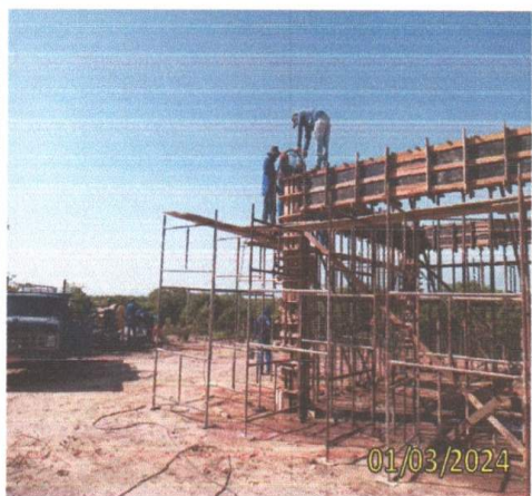
FOTO 1.24 – CONCRETAGEM DA VIGA.
