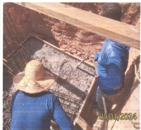
FOTO 1.14 – ADENSAMENTO DO CONCRETO DA SAPATA COM AUXÍLIO DO VIBRADOR.
