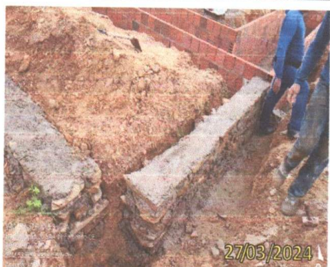
FOTO 4.24 – VISTA EM PERSPECTIVA DO ASSENTAMENTO DE PEDRA ARGAMASSADA.
