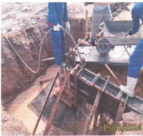
FOTO 1.17 – VIBRAÇÃO DO CONCRETO DA VIGA PARA ADENSAMENTO.
