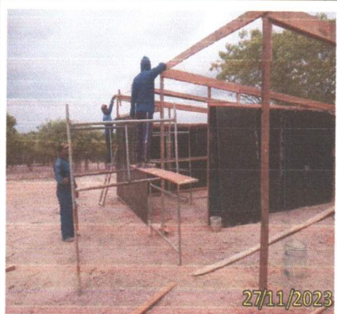
FOTO 1.9 – VISTA EM PERSPECTIVA DA CONSTRUÇÃO DO BARRACÃO.
