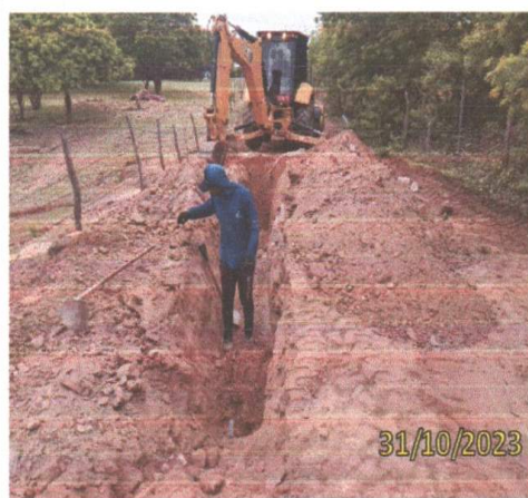
FOTO 3.10 – ESCAVAÇÃO DA VALA.
