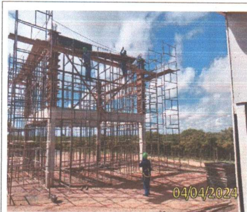
FOTO 1.31 – MONTAGEM DAS FORMAS NAS VIGAS.
