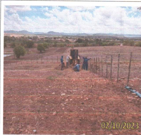
FOTO 2.1 – VISTA FRONTAL DO LOCAL DA ADUTORA.
