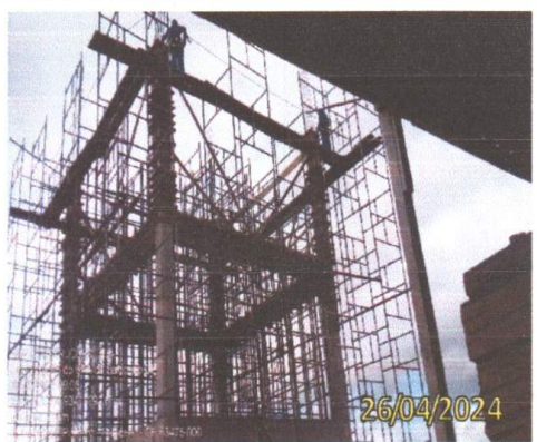
FOTO 1.36 – VISTA EM PERSPECTIVA DA CONCRETAGEM DOS PILARES.
