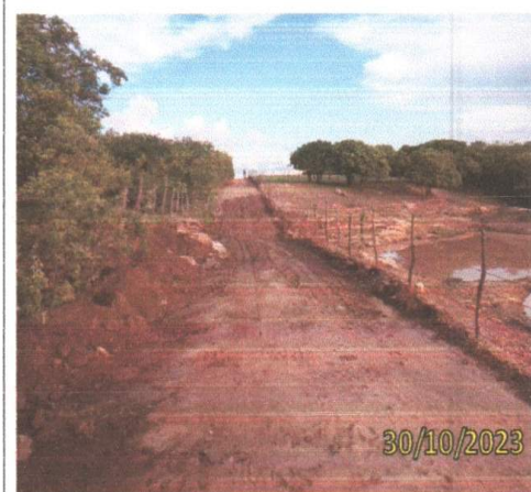
FOTO 3.9 – ESCAVAÇÃO E ATERRO FINALIZADO.
