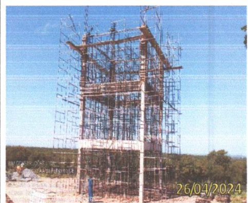
FOTO 1.35 – VISTA FRONTAL DA CONCRETAGEM DOS PILARES.
