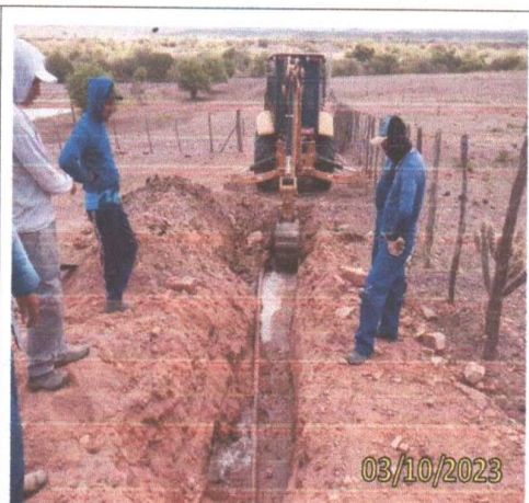
FOTO 2.2 – VISTA FRONTAL DA ESCAVAÇÃO DA VALA.
