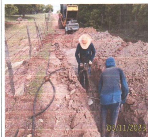
FOTO 3.11 – VISTA FRONTAL DA ESCAVAÇÃO.
