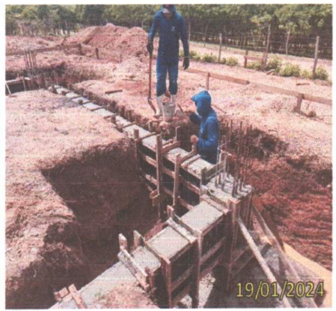
FOTO 1.18 – CONCRETAGEM DAS VIGAS.
