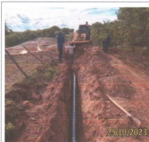
FOTO 3.7 – ATERRO DA VALA.
