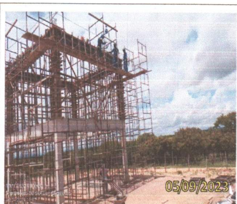
FOTO 1.32 – VISTA EM PERSPECTIVA DAS FORMAS DA VIGA.
