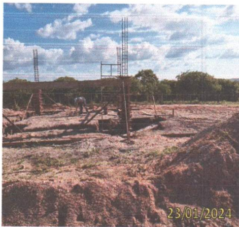
FOTO 1.19 – VISTA EM PERSPECTIVA DA MONTAGEM DAS FORMAS E FERRAGENS.
