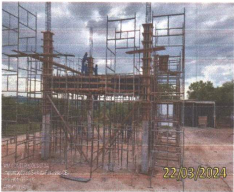
FOTO 1.27 – VISTA FRONTAL DA CONCRETAGEM DOS PILARES.
