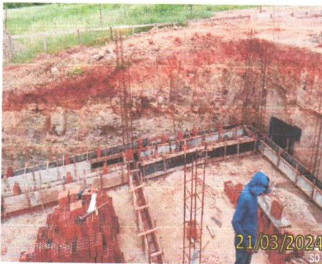
FOTO 4.21 – MONTAGEM DAS FORMAS DAS VIGAS BALDRAMES DO LEITO DRENANTE.
