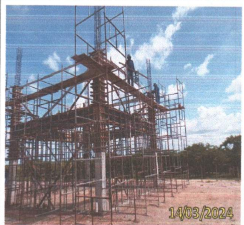
FOTO 1.26 – VISTA EM PERSPECTIVA DA MONTAGEM DAS FORMAS DOS PILARES.
