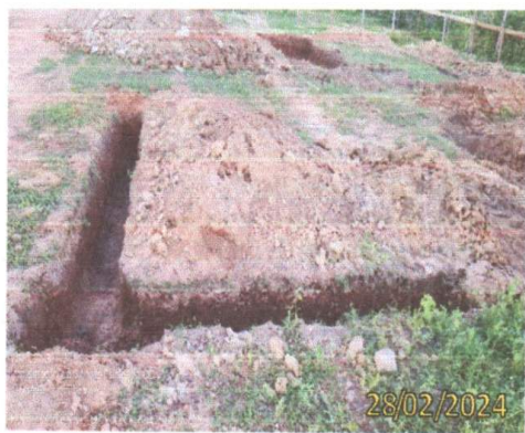
FOTO 4.13 – ESCAVAÇÃO DA FUNDAÇÃO DA CASA DE BOMBAS
