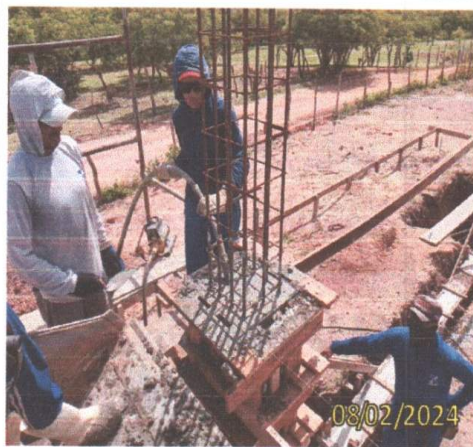
FOTO 1.21 – DETALHE DA EXECUÇÃO DA CONCRETAGEM DOS PILARES.
