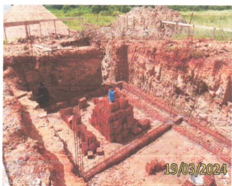
FOTO 4.20 – VISTA EM PERSPECTIVA DAS FERAGENS E ALVENARIA DE EMBASAMENTO DO LEITO DRENANTE.
