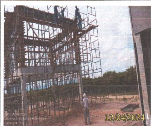
FOTO 1.33 – VISTA EM PERSPECTIVA DA CONCRETAGEM DAS VIGAS.
