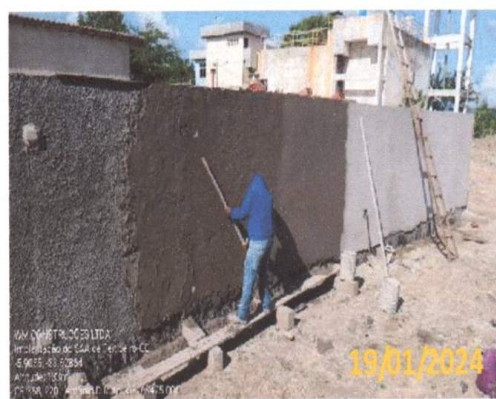
FOTO 3.3 – VISTA EM PERSPECTIVA DO SARRAFEAMENTO DO REBOCO.
