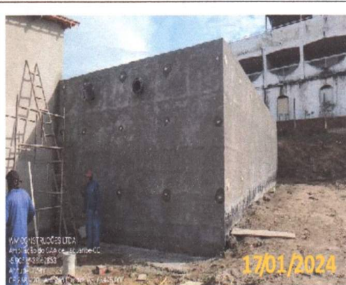
FOTO 3.1 – APLICAÇÃO DO CHAPISCO E TALISCAS PARA O REBOCO.
