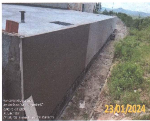
FOTO 3.4 – PANORÂMICA DA CONCRETAGEM DAS PAREDES.
