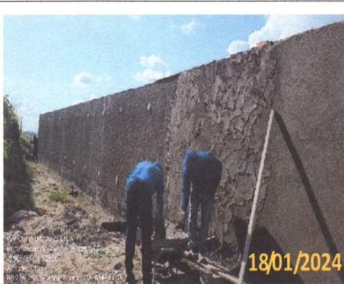
FOTO 3.2 – VISTA EM PERSPECTIVA DA APLICAÇÃO DO REBOCO.
