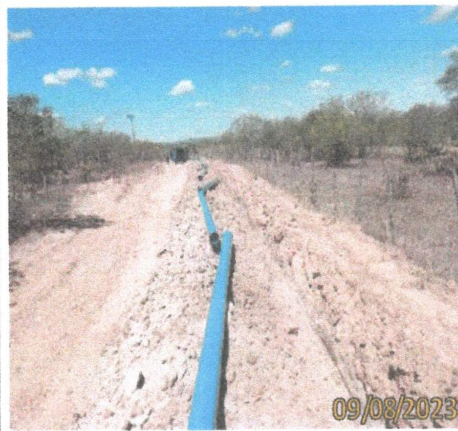
FOTO 1.10 – VISTA DA TUBULAÇÃO NO SENTIDO DO ASSENTAMENTO NA VALA.
