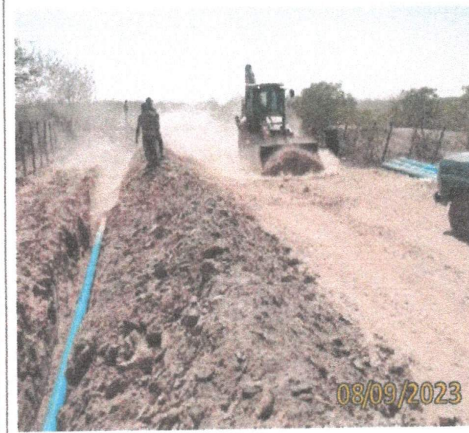
FOTO 1.36 – APLICAÇÃO DO COLCHÃO DE AREIA E REATERRO DA VALA.
