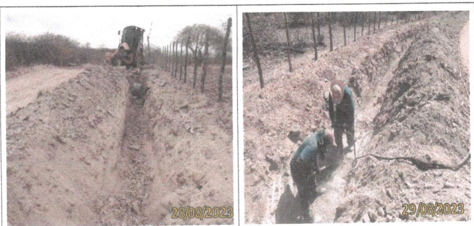
FOTO 1.26 – ESCAVAÇÃO DA VALA COM O ROMPEDOR PNEUMÁTICO MANUAL.
