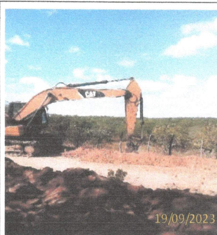
FOTO 1.44 – VISTA LATERAL DA ESCAVAÇÃO EM ROCHA BRANDA A FRIO COM AUXÍLIO DA ESCAVADEIRA HIDRÁULICA E ROMPEDOR ACOPLADO.
