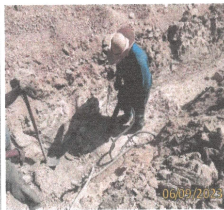
FOTO 1.33 – VISTA EM PERSPECTIVA DA ESCAVAÇÃO EM MATERIAL DE 3ª CATEGORIA COM O ROMPEDOR PNEUMÁTICO MANUAL.
