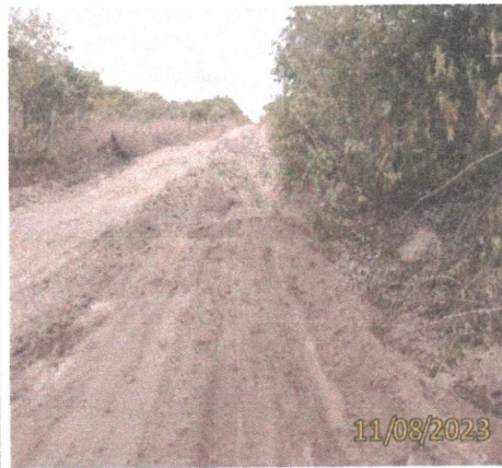
FOTO 1.12 – DETALHE DO REATERRO DA VALA.
