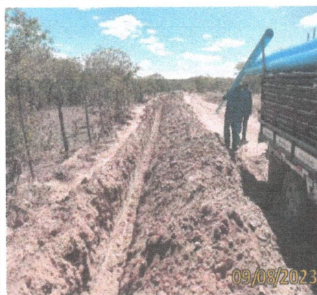
FOTO 1.9 – RETIRADA DOS TUBOS DO CARRO DE TRANSPORTE.
