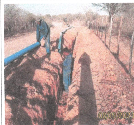
FOTO 1.35 – LOCAÇÃO DO TUBOS DE FORMA MANUAL NA VALA.
