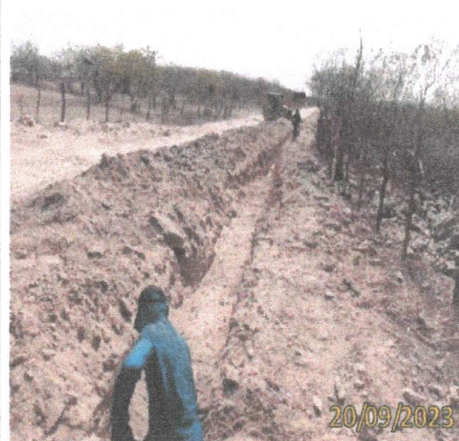
FOTO 1.46 – VISTA FRONTAL DA ESCAVAÇÃO EM MATERIAL DE 3ª CATEGORIA.
