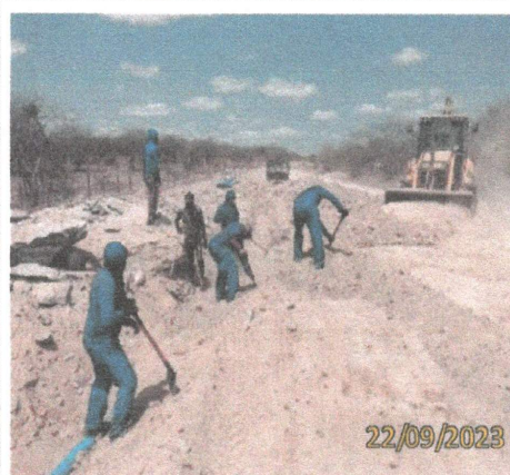
FOTO 1.48 – VISTA FRONTAL DA ESCAVAÇÃO EM MATERIAL DE 3ª CATEGORIA.
