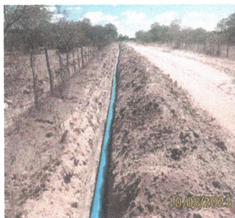
FOTO 1.11 – VISTA PANORÂMICA DA TUBULAÇÃO DA VALA.
