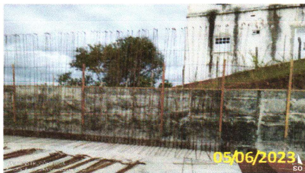
FOTO 3.3 – MONTAGEM DAS FERRAGENS DAS PAREDES.
