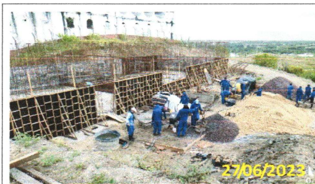
FOTO 3.15 – VISTA PANORÂMICA DAS EQUIPES DE CONCRETAGEM.
