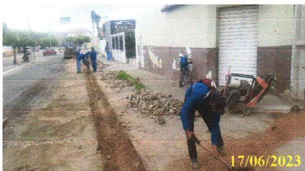
FOTO 2.13 – ATERRO DE VALA/RAMAL.
