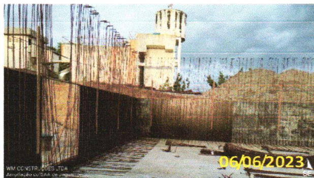
FOTO 3.4 – VISTA FRONTAL DA MONTAGEM DAS FERRAGENS.
