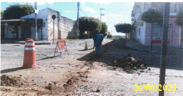
FOTO 1.27 – COMPACTAÇÃO DA VALA.
