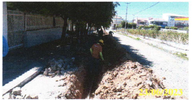
FOTO 1.26 – REATERRO DA VALA.
