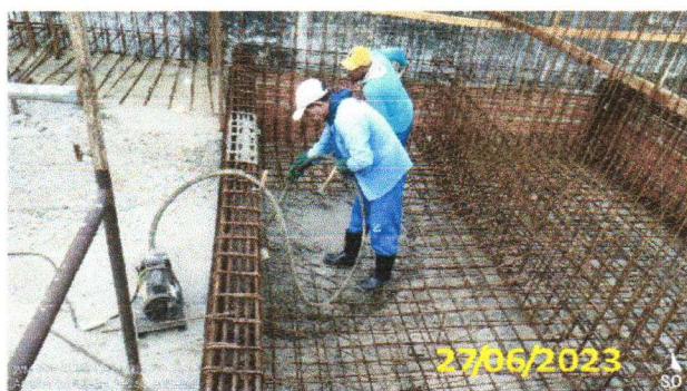
FOTO 3.13 – ADENSAMENTO DO CONCRETO COM AUXÍLIO DO VIBRADOR.
