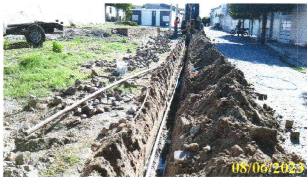
FOTO 2.11 – CONTINUIDADE DAS TUBULAÇÕES E COLOCAÇÃO DOS RAMAIS.
