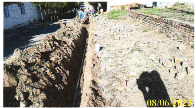
FOTO 2.10 – TUBULAÇÕES ANTES DE REALIZAR AS LIGAÇÕES DOS RAMAIS.
