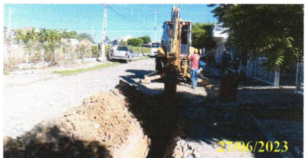
FOTO 1.28 – ABERTURA DE VALA COM AUXÍLIO DE RETROESCAVADEIRA.
