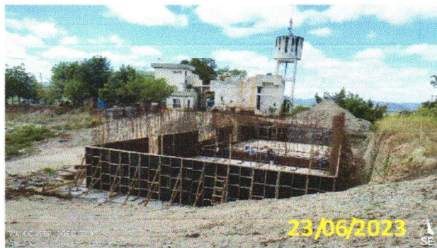
FOTO 3.11 – VISTA PANORÂMICA DO RESERVATÓRIO.
