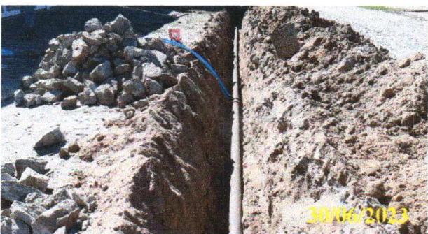
FOTO 1.29 – ASSENTAMENTO DE TUBULAÇÃO.
