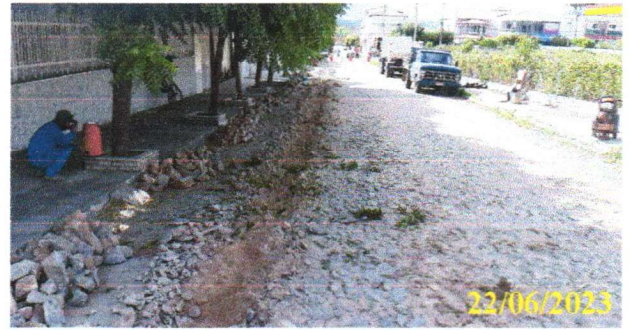
FOTO 1.24 – ESCAVAÇÃO DE VALA.
