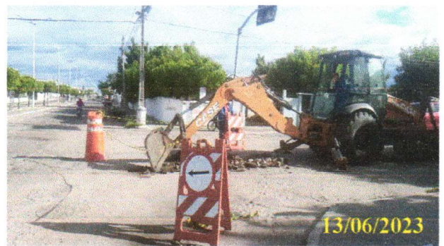
FOTO 1.14 – ESCAVAÇÃO DE VALA COM AUXÍLIO DE RETROESCAVADEIRA
