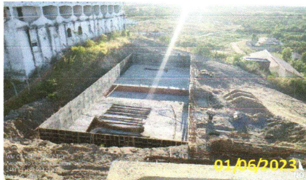
FOTO 3.1 – VISTA PANORÂMICA DA MONTAGEM DAS FORMAS.
