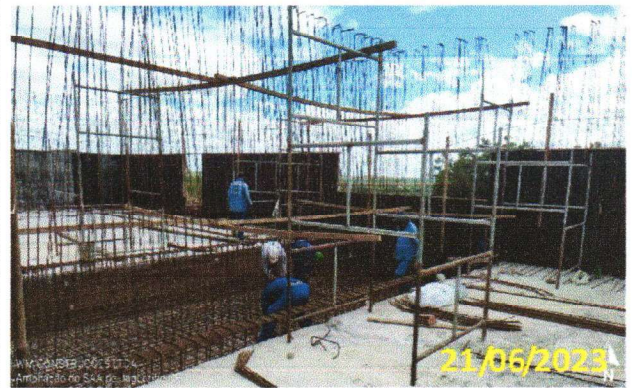
FOTO 3.10 – MONTAGEM DAS FERRAGENS DA LAJE DE FUNDO DO POÇO DE SUÇÃO.
