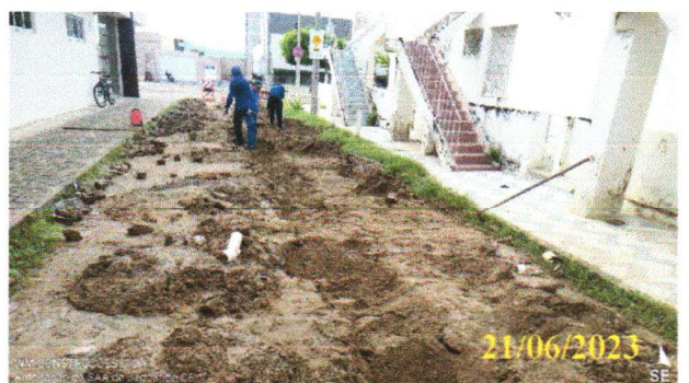
FOTO 1.22 – REATERRO DE VALA.
