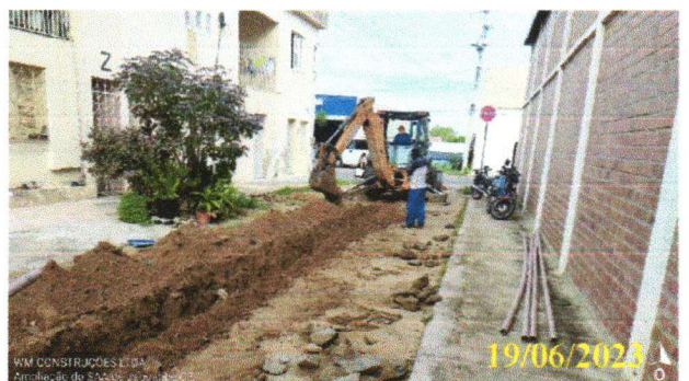
FOTO 1.20 – ESCAVAÇÃO DA VALA COM AUXÍLIO DE RETROESCAVADEIRA.
