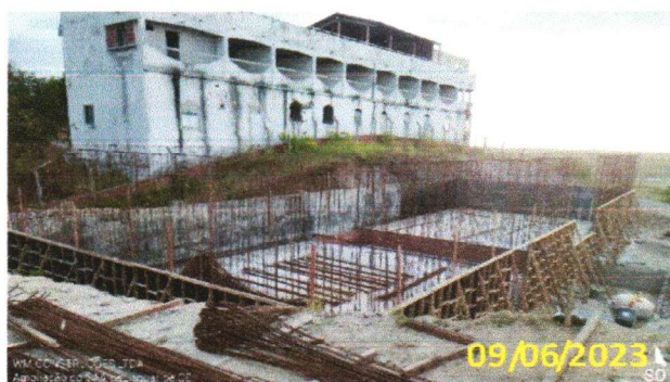
FOTO 3.6 – VISTA PANORÂMICA DA ARMAÇÃO DAS FERRAGENS.
