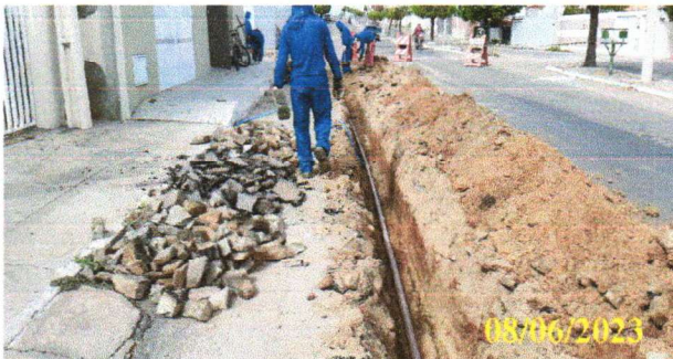
FOTO 1.9 – ASSENTAMENTO DA TUBULAÇÃO.
