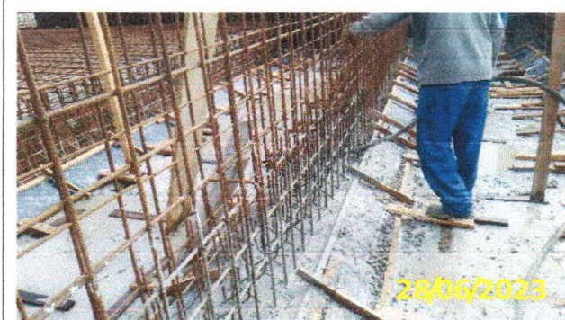
FOTO 3.17 – CONCRETAGEM DO CHANFRO DO POÇO DE SUÇÃO.
