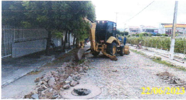
FOTO 1.23 – RETIRADA DE PAVIMENTAÇÃO EM PEDRA TOSCA COM AUXÍLIO DE RETROESCAVADEIRA.
