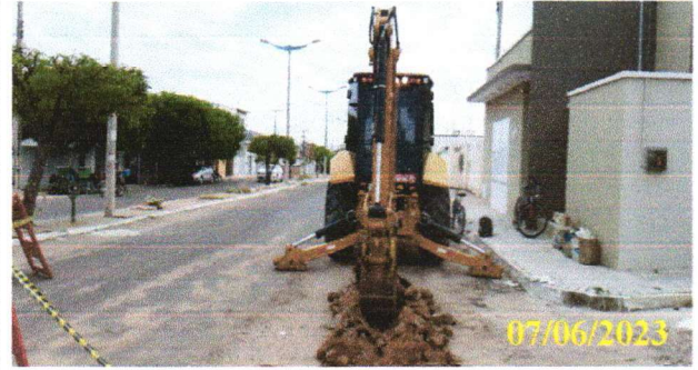
FOTO 1.8 – ESCAVAÇÃO DA VALA COM AUXÍLIO DA RETROESCAVADEIRA.
