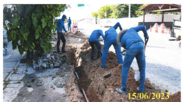
FOTO 1.16 – ATERRO DA VALA.
