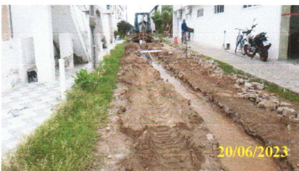
FOTO 1.21 – REPARO DE TUBULAÇÃO EM VALA.
