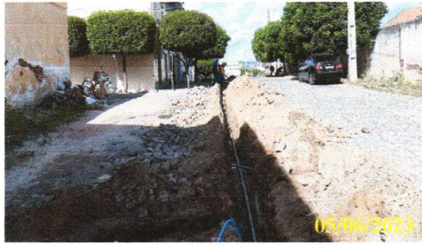
FOTO 2.7 – ASSENTAMENTO DAS TUBULAÇÕES.
