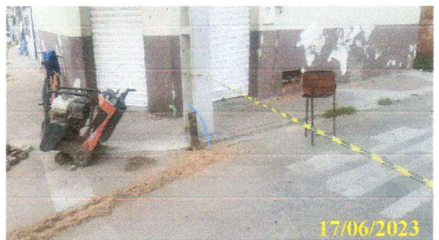
FOTO 2.14 – DETALHE DE MANGUEIRA DO RAMAL.
