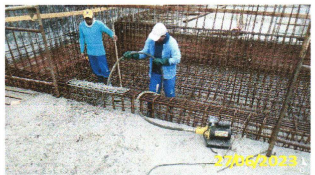
FOTO 3.14 – VISTA FRONTAL DO ADENSAMENTO DO CONCRETO.
