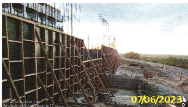
FOTO 3.5 – VISTA LATERAL DA MONTAGEM DAS FORMAS E DAS FERRAGENS.
