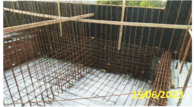
FOTO 3.8 – VISTA FRONTAL DA MONTAGEM DAS FERRAGENS.
