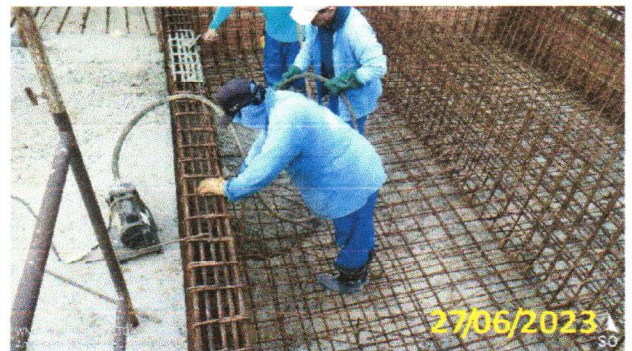
FOTO 3.12 – CONCRETAGEM DA LAJE DE FUNDO DO POÇO DE SUÇÃO.
