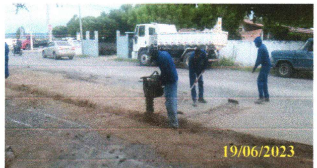
FOTO 1.18 – COMPACTAÇÃO DA VALA.
