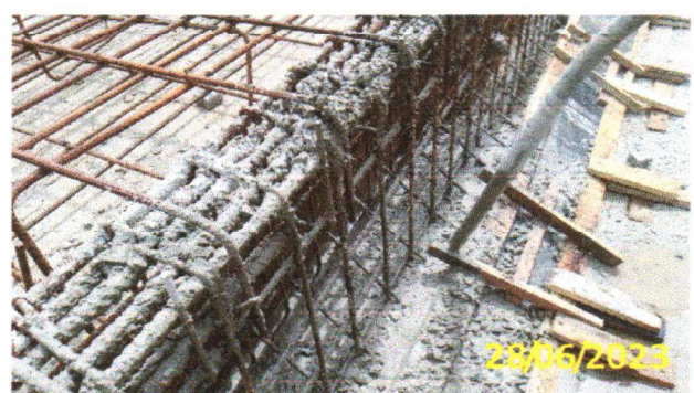
FOTO 3.18 – ADENSAMENTO DO CONCRETO DO CHANFRO COM AUXÍLIO DO VIBRADOR.
