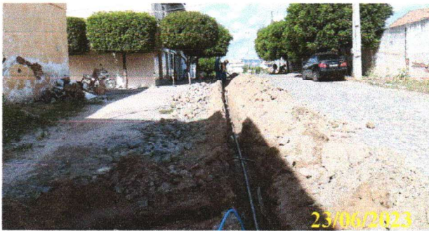
FOTO 1.25 – ASSENTAMENTO DE TUBULAÇÃO.
