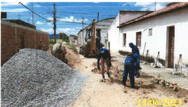
FOTO 1.11 – ESCAVAÇÃO DA VALA, COM RETIRADA MANUAL DE PEDRA TOSCA.
