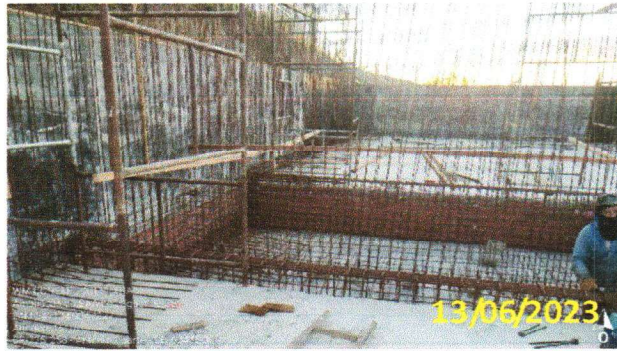
FOTO 3.7 – MONTAGEM DAS FERRAGENS DO POÇO DE SUÇÃO.
