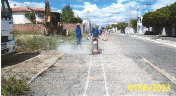
FOTO 1.7 – CORTE DE VALA COM AUXÍLIO DE MÁQUINA DE CORTAR ASFALTO.
