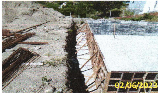
FOTO 3.2 – VISTA LATERAL DA MONTAGEM DAS FORMAS.
