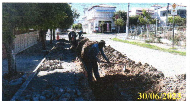
FOTO 1.30 – REATERRO DE VALA.
