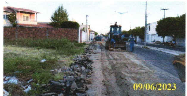
FOTO 1.10 – REATERRO DA VALA.
