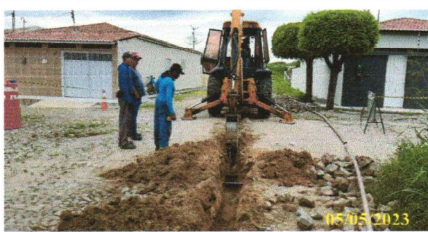
FOTO 2.7 – ESCAVAÇÃO DA VALA COM AUXÍLIO DA RETROESCAVADEIRA
