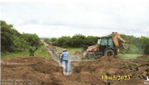
FOTO 6.11 – ESCAVAÇÃO EM MATERIAL DE TERCEIRA CATEGORIA COM AUXÍLIO DO ROMPEDOR PNEUMÁTICO MANUAL.
