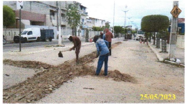
FOTO 4.16 – CONCRETO ASFÁLTICO COMPACTADO
