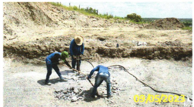
FOTO 5.6 – ESCAVAÇÃO DO POÇO DE SUCCÃO COM AUXÍLIO DO ROMPEDOR PNEUMÁTICO MANUAL.
