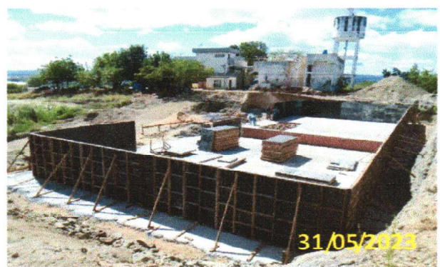
FOTO 5.30 – VISTA PANORÂMICA DA MONTAGEM DAS FORMAS.
