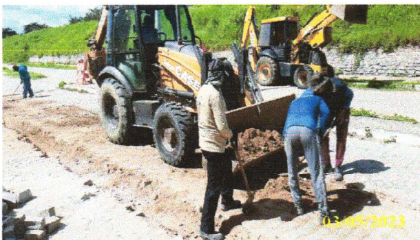
FOTO 2.3 – RETIRADA DO PAVIMENTO DE PEDRA TOSCA COM RETROESCAVADEIRA
