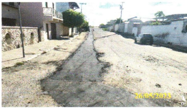
FOTO 4.27 – RECOMPOSIÇÃO ASFÁLTICA DA RUA MARCOS CÉSAR PINHEIRO DIÓGENES
