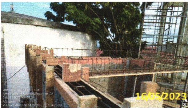
FOTO 1.11 – ARMAÇÃO DAS FERRAGENS E FORMAS DAS VIGAS DO PAVIMENTO TÉRREO.
