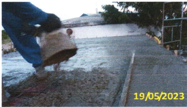
FOTO 1.17 – CONCRETAGEM DA LAJE.
