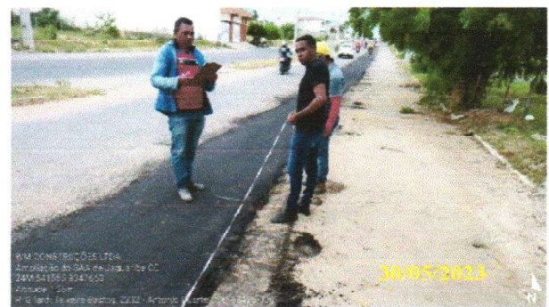
FOTO 4.29 – MEDIÇÃO DO ASFALTO.
