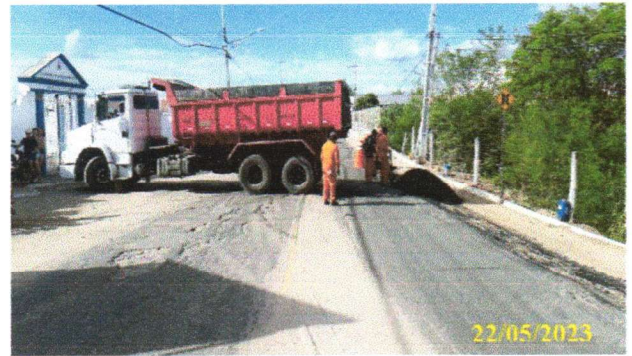
FOTO 4.2 – INICIAÇÃO DA RECOMPOSIÇÃO ASFÁLTICA NA AV. 08 DE NOVEMBRO
