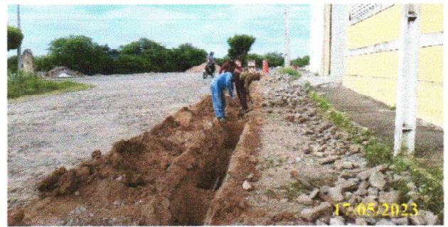
FOTO 2.18 – REATERRO DA VALA
