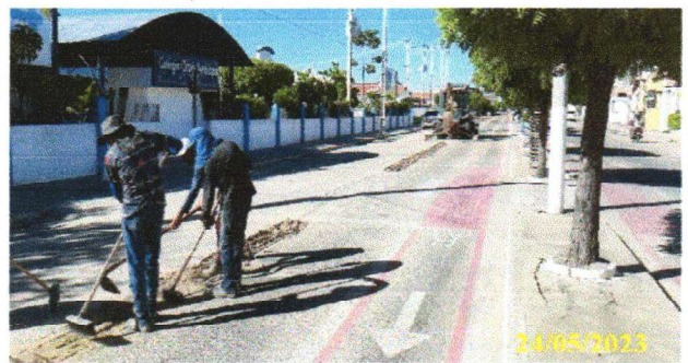
FOTO 4.12 – RETROESCAVADEIRA FAZENDO A RASPAGEM DA VALA PARA SUA LIMPEZA
