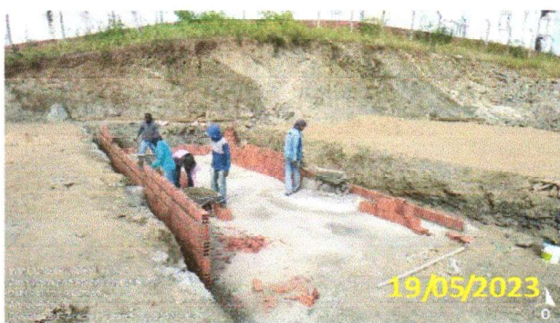
FOTO 5.19 – ASSENTAMENTO DA ALVENARIA DAS PAREDES DO POÇO DE SUÇÃO.
