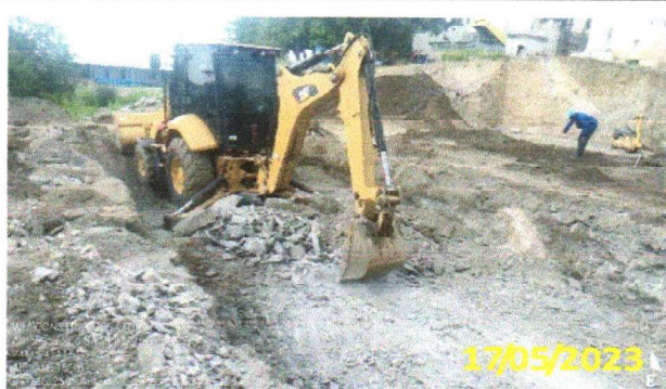
FOTO 5.15 – ESCAVAÇÃO DO POÇO DE SUÇÃO E COMPACTAÇÃO DO SOLO.
