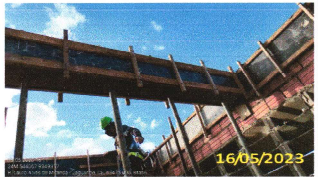
FOTO 1.12 – AMARRAÇÃO DAS FORMAS DAS VIGAS DO PAVIMENTO TÉRREO.
