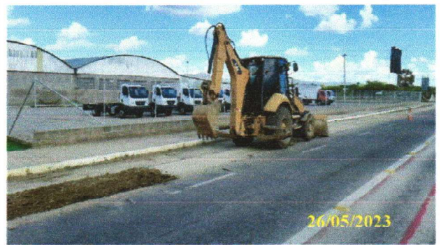
FOTO 4.22 – RETIRADA DA CAPA DE ATERRO NA VALA COM AUXÍLIO DA RETROESCAVADEIRA.
