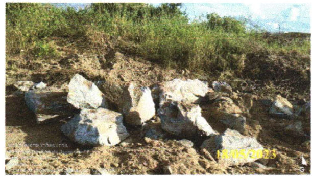
FOTO 6.10 – MATERIAL DE TERCEIRA CATEGORIA RETIRADOS DA VALA.
