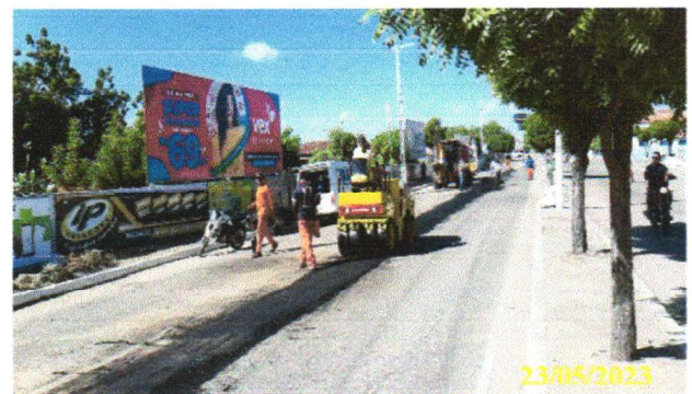
FOTO 4.6 – COMPACTAÇÃO ASFÁLTICA
