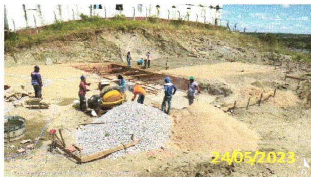
FOTO 5.22 – CONCRETAGEM DO PISO MAGRO.
