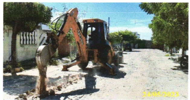
FOTO 2.24 – ABERTURA DA VALA COM AUXÍLIA DA RETROESCAVADEIRA
