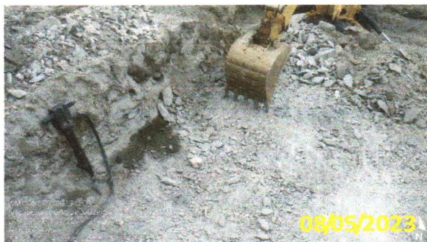
FOTO 5.5 – ESCAVAÇÃO DO POÇO DE SUCCÃO COM AUXÍLIO DA RETROESVACADEIRA
