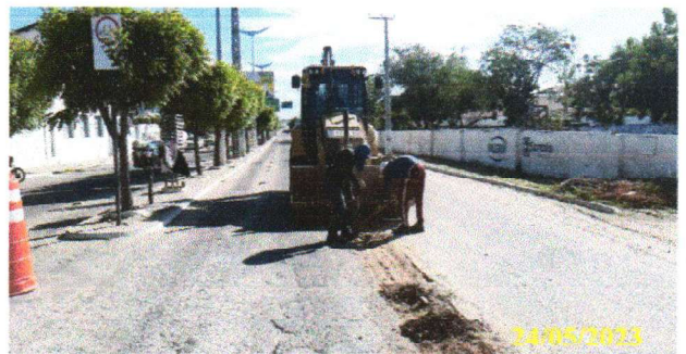
FOTO 4.14 – LIMPEZA MANUAL DO ENTULHO DA VALA PARA APLICAÇÃO DO ASFALTO.
