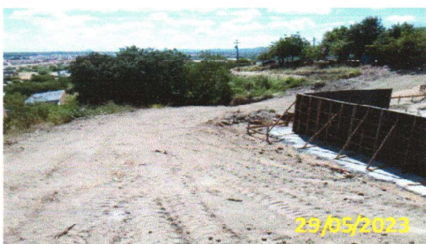
FOTO 5.27 – MONTAGEM DAS FORMAS E ESCORAS DAS PAREDES.
