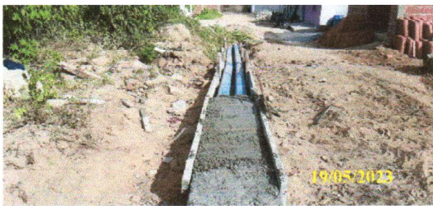
FOTO 6.19 – DETALHAMENTO DA CONCRETAGEM DOS TUBOS.
