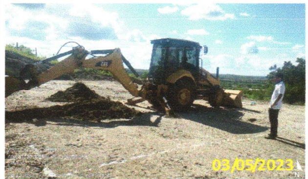
FOTO 5.2 – MARCAÇÃO E INÍCIO DA ESCAVAÇÃO DO POÇO DE SUCCÃO.
