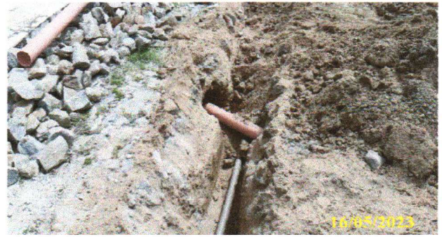
FOTO 2.16 – REATERRO DA VALA
