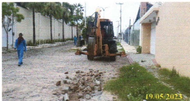
FOTO 2.21 – INÍCIO ESCAVAÇÃO DA VALA
