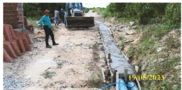
FOTO 6.18 – ENVEPOMENTO DOS TUBOS.
