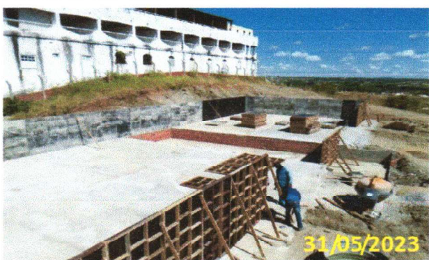
FOTO 5.29 – VISTA PANORÂMICA DA MONTAGEM DAS FORMAS.
