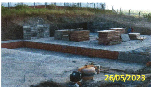
FOTO 5.25 – FINALIZAÇÃO DO CONCRETO MAGRO E INÍCIO DA MONTAGEM DAS FORMAS
