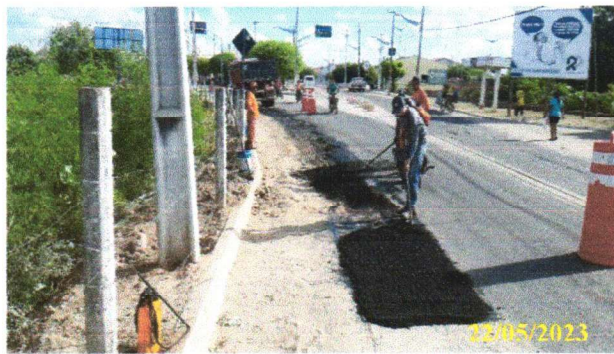
FOTO 4.3 – RECOMPOSIÇÃO ASFÁLTICA NA AV. 08 DE NOVEMBRO.
