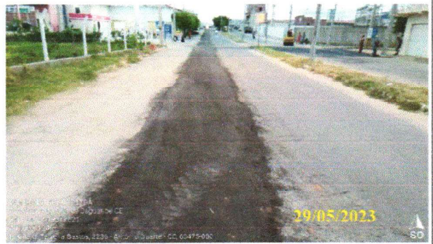
FOTO 4.28 – RECOMPOSIÇÃO ASFÁLTICA DA AV. GIL TEIXEIRA BASTOS.
