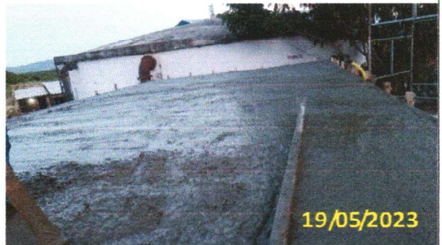
FOTO 1.18 – FINALIZAÇÃO DA CONCRETAGEM DA LAJE.
