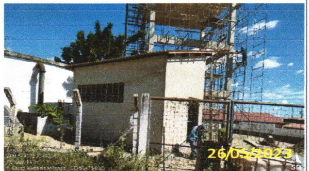
FOTO 1.20 – AMARRAÇÃO DAS FORMAS DAS VIGAS DO PAVIMENTO TÉRREO.
