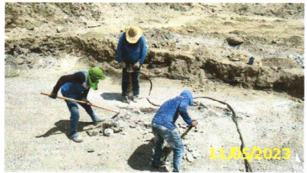
FOTO 5.8 – ESCAVAÇÃO DO POÇO DE SUÇÃO COM AUXÍLIO DO ROMPEDOR PNEUMÁTICO
