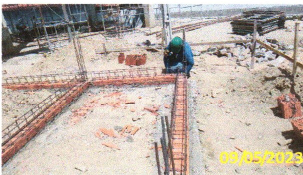
FOTO 1.5 – AMARRAÇÃO DAS FERRAGENS DAS VIGAS BALDRAMES.
