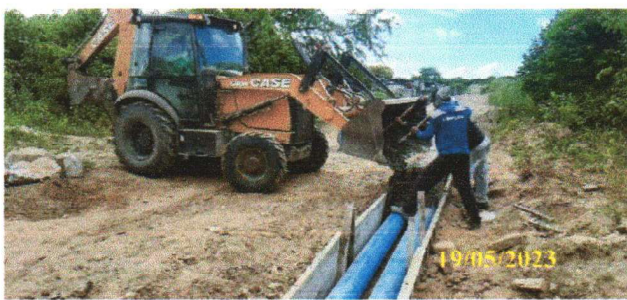
FOTO 6.17 – CONCRETAGEM PARA O ENVELOPAMENTO DOS TUBOS.
