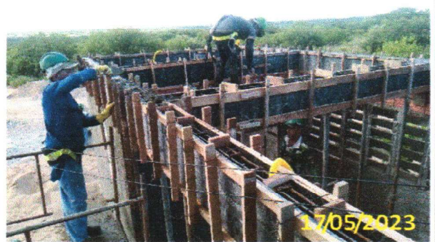
FOTO 1.14 – VISTA EM PERSPECTIVA DA CONCRETAGEM DAS VIGAS DO PAVIMENTO TÉRREO.
