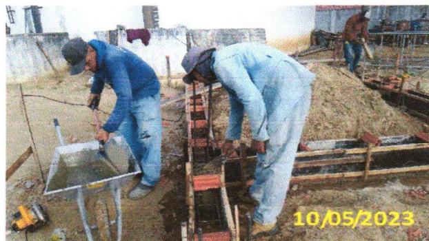
FOTO 1.6 – CONCRETAGEM DAS VIGAS BALDRAME.
