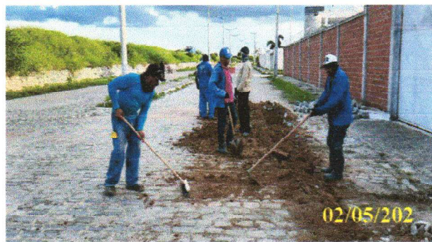
FOTO 2.1 – ESCAVAÇÃO DA VALA DE PRIMEIRA E SEGUNDA CATEGORIA
