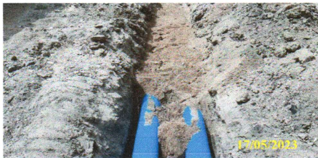
FOTO 6.5 – ATERRO DA TUBULAÇÃO COM AREIA LAVADA DO RIO.
