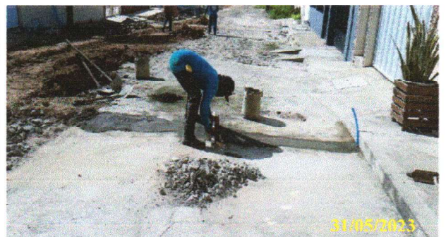
FOTO 3.14 – CONSERTO DO ALONGAMENTO DA CALÇADA DA RESIDÊNCIA UNIFAMILIAR.
