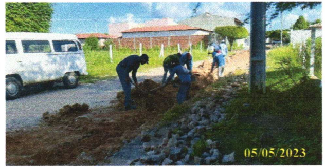
FOTO 2.8 – REATERRO DA VALA
