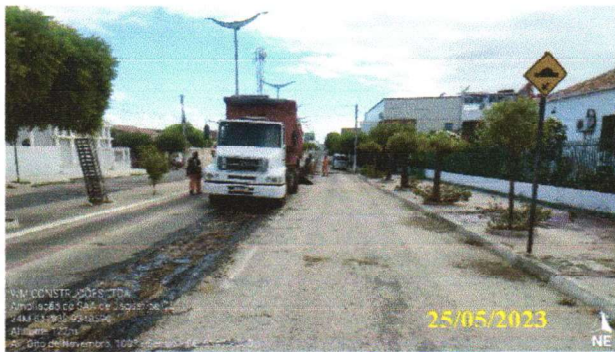
FOTO 4.17 – DESCARREGO DA MASSA ASFÁLTICA DA CAÇAMBA
