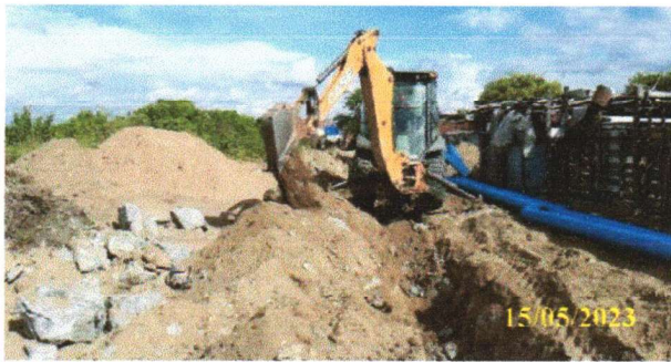
FOTO 6.1 - ESCAVAÇÃO EM TERCEIRA CATEGORIA COM AUXÍLIO DA RETROESCAVADEIRA
