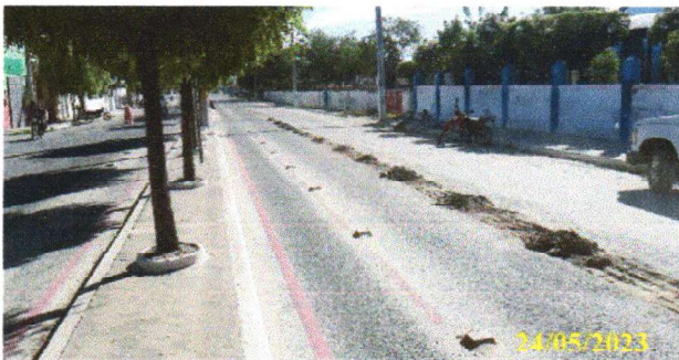
FOTO 4.13 – MONTES DE ENTULHO PARA SEREM RETIRADOS.
