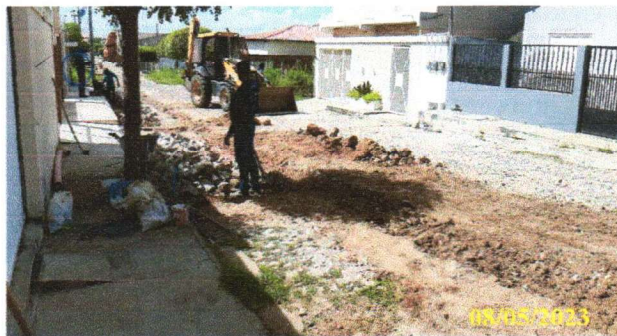
FOTO 2.9 – REATERRO DA VALA
