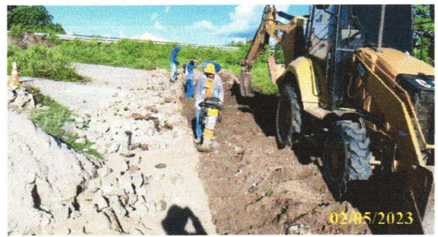
FOTO 2.2 – COMPACTAÇÃO DA VALA
