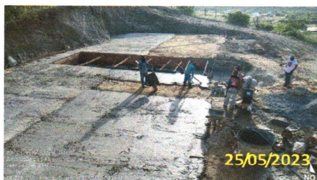
FOTO 5.24 – FILIZAÇÃO DO CONCRETO MAGRO DE UM LADO DO RESERVATÓRIO.
