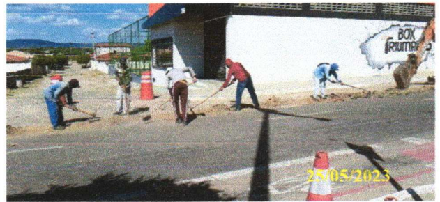
FOTO 4.20 – LIMPEZA DA VALA.
