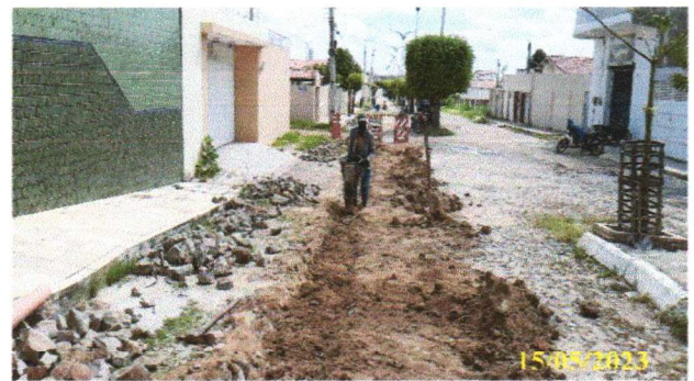
FOTO 2.14 – COMPACTAÇÃO DA VALA
