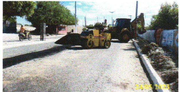
FOTO 4.10 – VISTA PANORÂMICA PARA O ROLO COMPACTADOR VIBRATÓRIOS DO ASFALTO.
