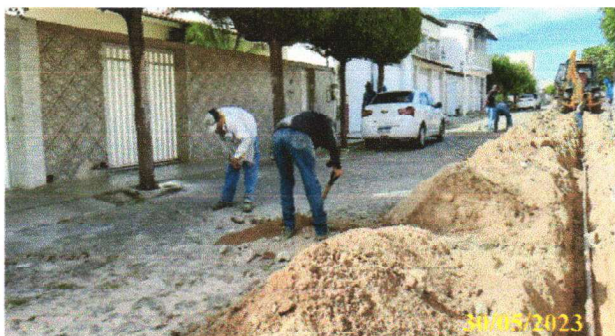
FOTO 3.13 – ESCAVAÇÃO MANUAL DO RAMAL.
