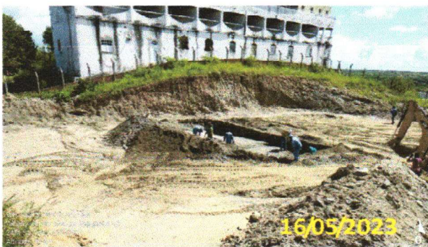
FOTO 5.11 – RETIRADA DE ATERRO DO POÇO DE SUÇÃO.
