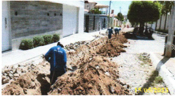
FOTO 2.15 – ESCAVAÇÃO DA VALA
