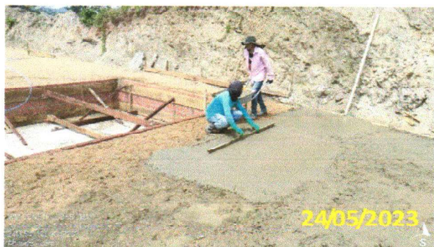
FOTO 5.23 – CONCRETAGEM E NIVELAMENTO DO PISO MAGRO.
