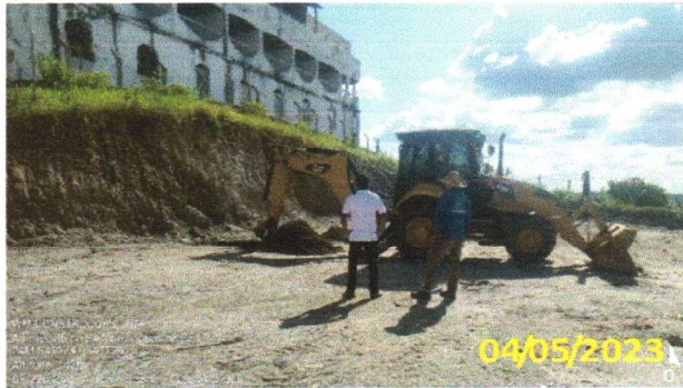
FOTO 5.3 – VISTA PANORÂMICA DA ESCAVAÇÃO DO POÇO DE SUCCÃO.
