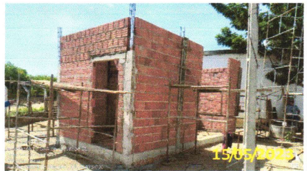
FOTO 1.10 – PANORÂMICA DA ALVENARIA DE VEDAÇÃO.
