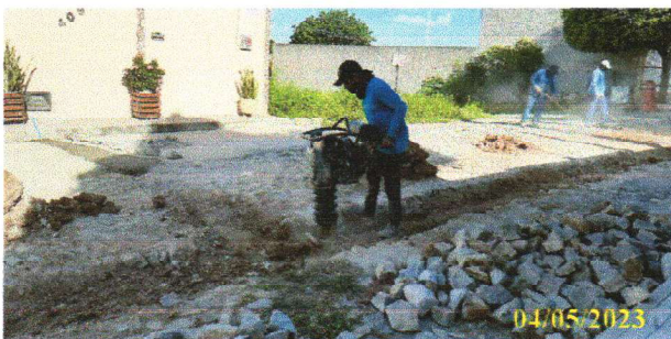
FOTO 2.5 – COMPACTAÇÃO DA RUA PARA A INSTALAÇÃO DA REDE DE DISTRIBUIÇÃO
