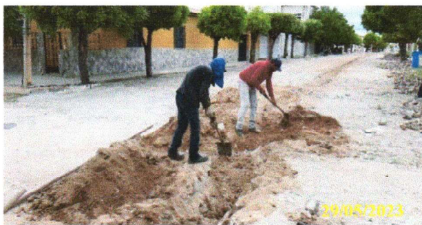
FOTO 2.27 – ATERRO DA VALA
