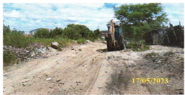
FOTO 6.6 – VISTA PANORÂMICA DO LOCAL DA ESCAVAÇÃO DAS VALAS.
