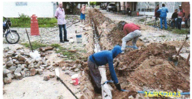
FOTO 2.26 – ABERTURA DA VALA DOS RAMAIS PREDIAIS
