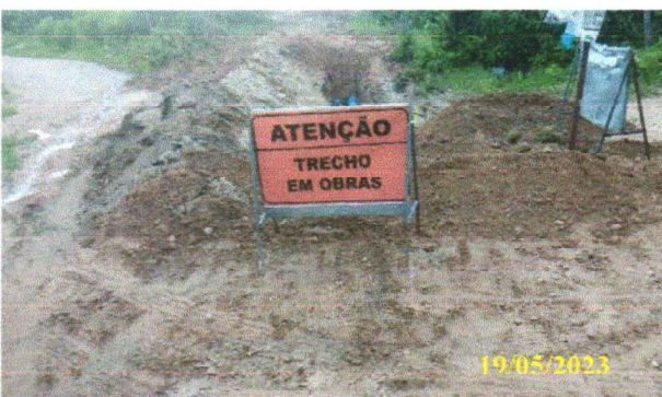
FOTO 6.13 – SINALIZAÇÃO DA VALA.
