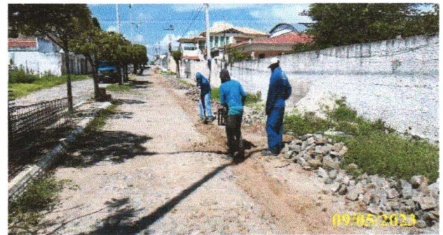
FOTO 2.10 – COMPACTAÇÃO DA VALA
