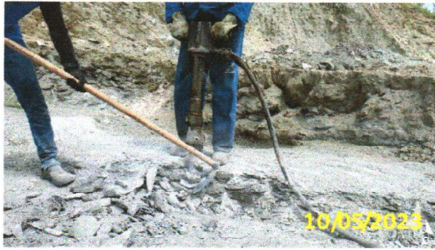
FOTO 5.7 – ESCAVAÇÃO DO POÇO DE SUÇÃO COM AUXÍLIO DO ROMPEDOR PNEUMÁTICO
