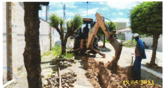
FOTO 2.20 – ESCAVAÇÃO DA VALA.
