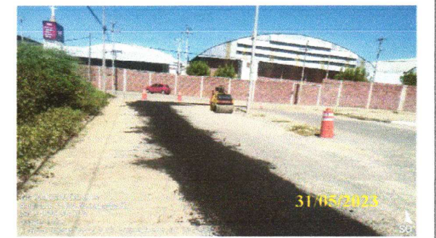
FOTO 4.30 – FINALIZANDO A RECOMPOSIÇÃO DO ASFALTO NA AV. GIL TEIXEIRA BASTOS.
