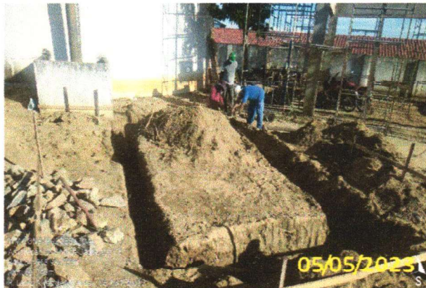
FOTO 1.3 – ESCAVAÇÃO DO BALDRAME DA CASA DE BOMBAS
