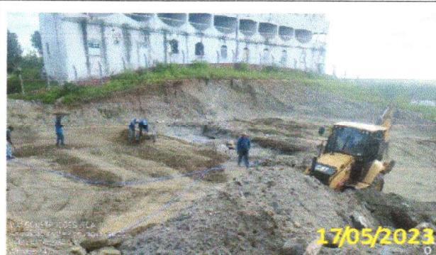
FOTO 5.16 – COMPACTAÇÃO E NIVELAMENTO COM AUXÍLIO DA RETROESCAVADEIRA.
