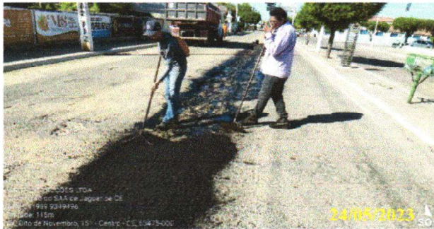
FOTO 4.9 – RECOMPOSIÇÃO ASFÁLTICA
