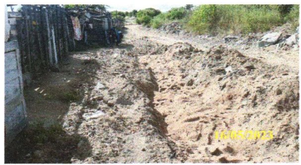
FOTO 6.4 – APLICAÇÃO DO COLCHÃO DE AREIA NA VALA.
