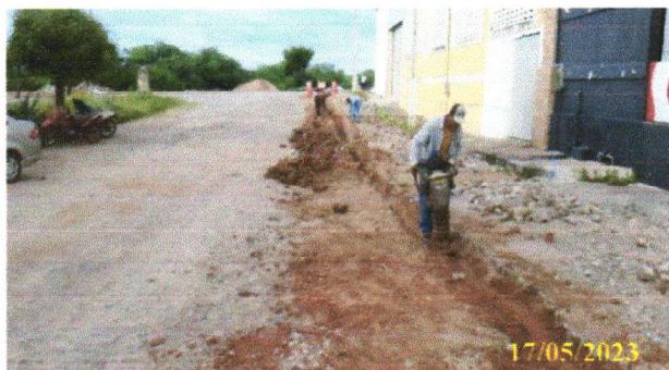
FOTO 2.19 – COMPACTAÇÃO DA VALA.
