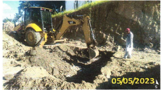
FOTO 5.4 – ESCAVAÇÃO DO POÇO DE SUCCÃO COM AUXÍLIO DA RETROESCAVADEIRA
