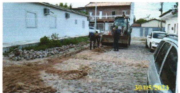
FOTO 2.28 – RETIRADA DO PAVIMENTO DE PEDRA TOSCA COM RETROESCAVADEIRA
