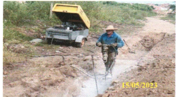
FOTO 6.2 – ESCAVAÇÃO EM TERCEIRA CATEGORIA COM AUXÍLIO DE ROMPEDOR PNEUMÁTICO MANUAL
