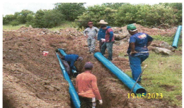
FOTO 6.14 – LOCAÇÃO DA TUBULAÇÃO NA VALA.
