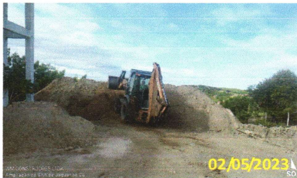
FOTO 5.1 – TERRAPLANAGEM DO PLATOR COM AUXÍLIO DA RETROESCAVADEIRA.
