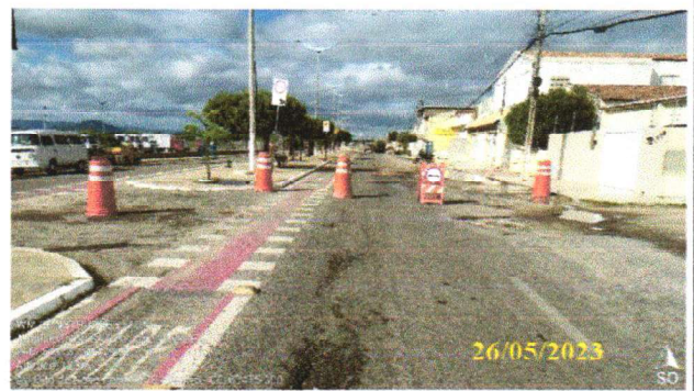
FOTO 4.24 – SINALIZAÇÃO DA VIA.
