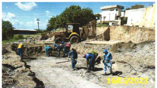
FOTO 5.12 – ESCAVAÇÃO DO POÇO DE SUÇÃO.
