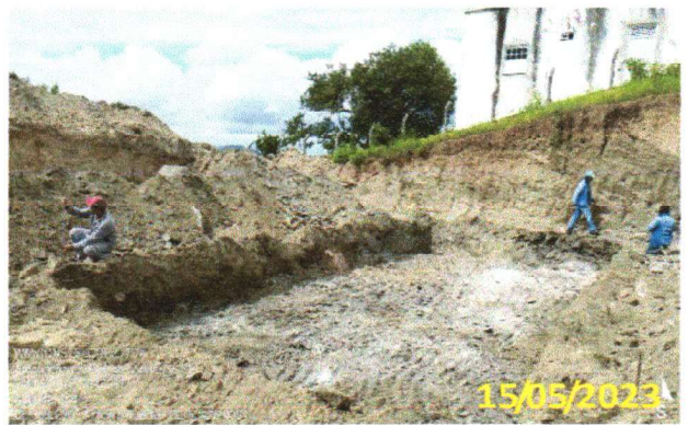
FOTO 5.10 – ESCAVAÇÃO DO POÇO DE SUÇÃO
