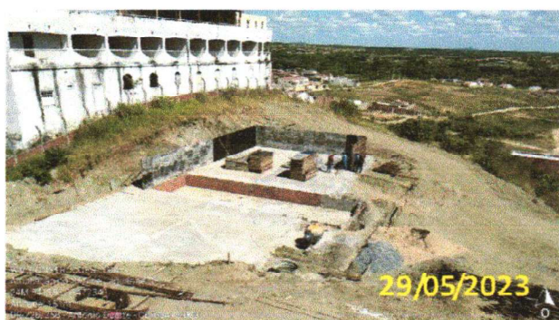
FOTO 5.26 – MONTAGEM DAS FORMAS
