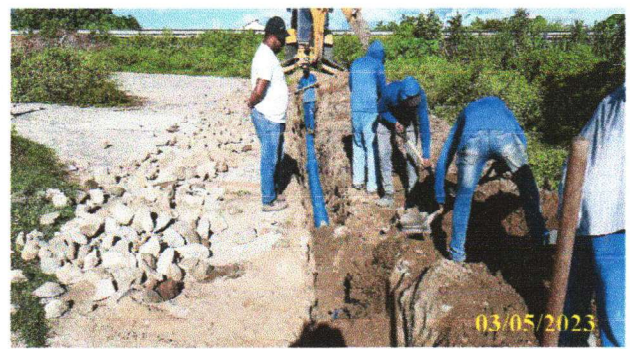
FOTO 2.4 – REATERRO DA VALA
