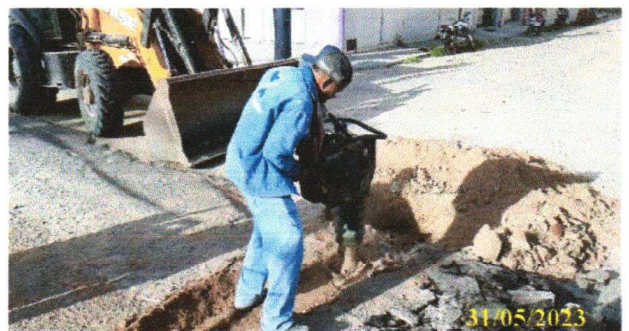
FOTO 2.30 – COMPACTAÇÃO DA VALA PARA A INSTALAÇÃO DA REDE DE DISTRIBUIÇÃO
