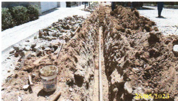
FOTO 3.11 – TUBULAÇÃO ANTES DE REALIZAR AS LIGAÇÕES DOS RAMAIS.
