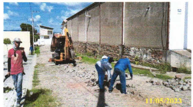
FOTO 2.12 – ESCAVAÇÃO DA VALA
