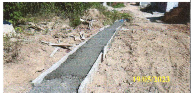
FOTO 6.20 – FINALIZAÇÃO DO ENVELOPAMENTO DOS TUBOS.
