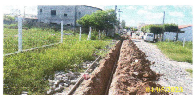
FOTO 2.6 – VISTA FRONTAL DO ASSENTAMENTO DA TUBULAÇÃO
