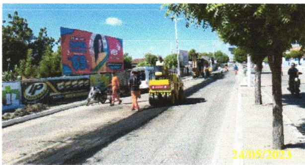
FOTO 4.11 – COMPACTAÇÃO DA VALA COM ROLO COMPRESSOR DE ASFALTO.
