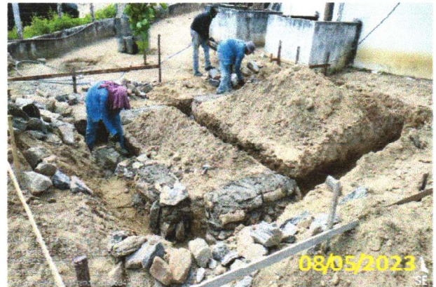
FOTO 1.4 – CONSTRUÇÃO DO BALDRAME EM PEDRA ARGAMASSADA.
