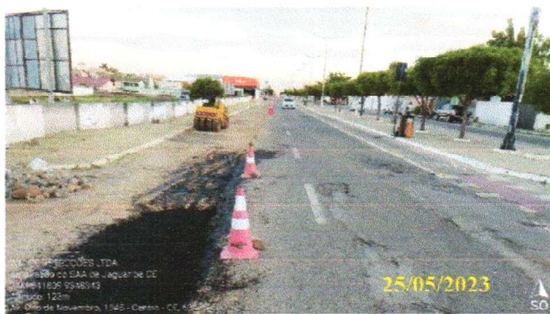
FOTO 4.21 – SINALIZAÇÃO DO TRÂNSITO PARA APLICAÇÃO DO CONCRETO ASFÁLTICO.
