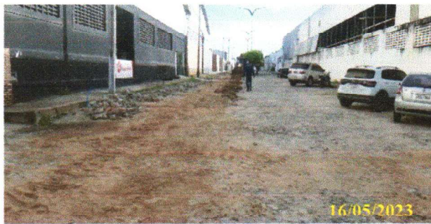
FOTO 2.17 – LIMPEZA DA VALA COM AUXÍLIO DA RETROESCAVADEIRA
