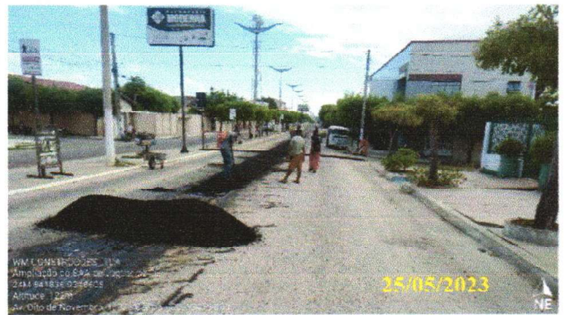
FOTO 4.18 – MONTE DE ASFALTO PARA SER ESPALHADO.
