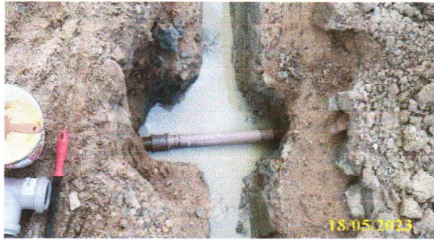
FOTO 3.7 – DETALHES DAS ESCAVAÇÕES.
