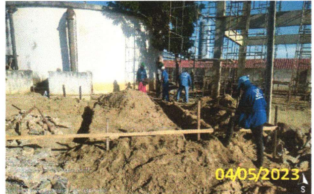
FOTO 1.2 – MONTAGEM DO GABARITO PARA A CASA DE BOMBAS
