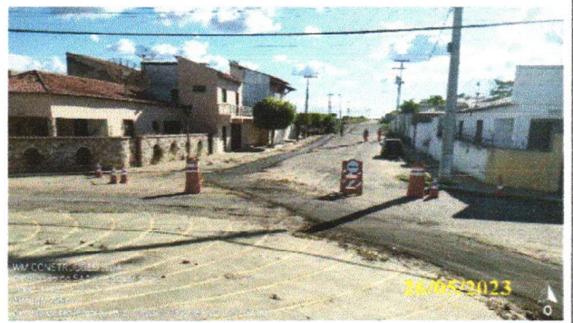
FOTO 4.26 – RECOMPOSIÇÃO ASFÁLTICA DA ROTATÓRIA.
