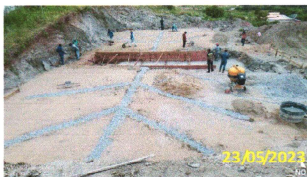
FOTO 5.20 – SISTEMA DE DRENAGEM ESPINHA DE PEIXE.
