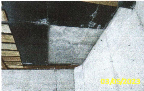
FOTO 1.1 – RETIRADAS DAS FORMAS DA PAREDE DA TAMPA.
