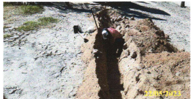
FOTO 2.22 – ESCAVAÇÃO DA VALA
