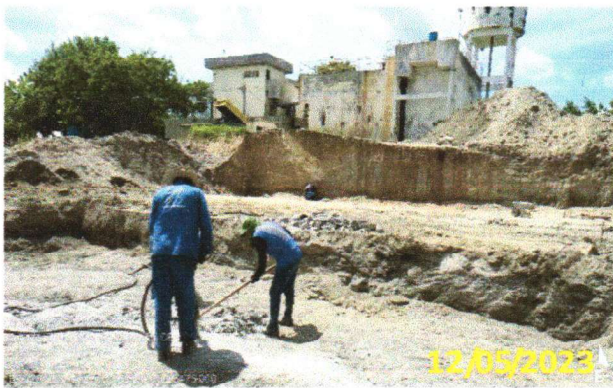
FOTO 5.9 – ESCAVAÇÃO DO POÇO DE SUÇÃO COM AUXÍLIO DO ROMPEDOR PNEUMÁTICO
