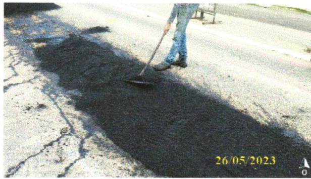
FOTO 4.23 – ESPALHAMENTO DA MASSA ASFÁLTICA NA VALA.
