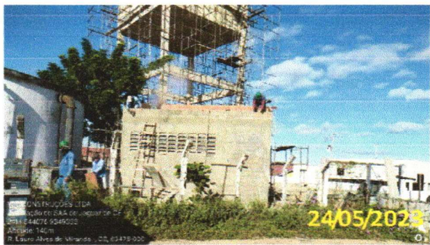
FOTO 1.19 – ARMAÇÃO DAS FERRAGENS E FORMAS DAS VIGAS DO PAVIMENTO TÉRREO.
