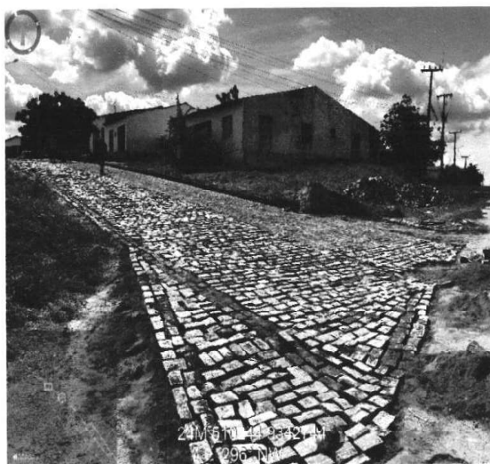
ASSENTAMENTO DE MEIO FIO (14/10/2022 A 13/01/2023)
