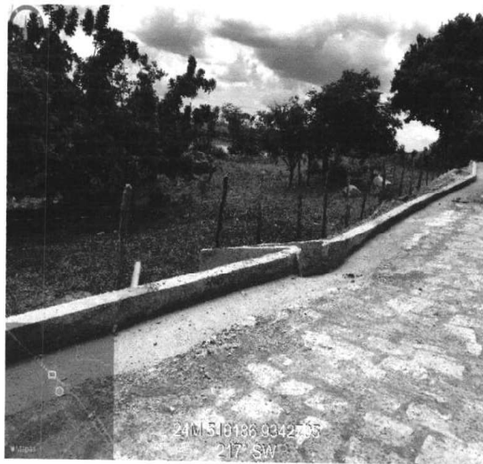
EXECUÇÃO DE SARIETAS (31/10/2022 A 13/01/2023)
