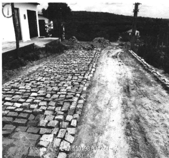
ASSENTAMENTO DE MEIO FIO (14/10/2022 A 13/01/2023)
