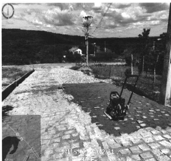
ASSENTAMENTO DE MEIO FIO (14/10/2022 A 13/01/2023)
