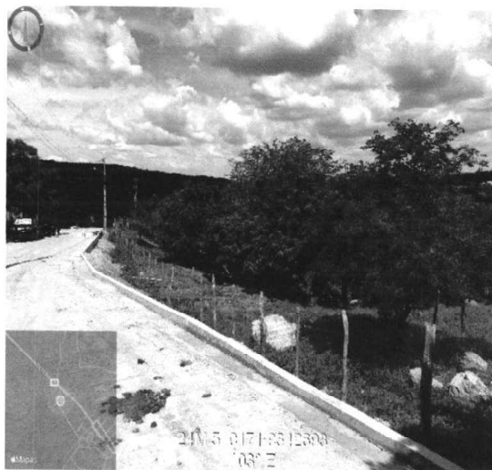
EXECUÇÃO DE SARJETAS (31/10/2022 A 13/01/2023)
