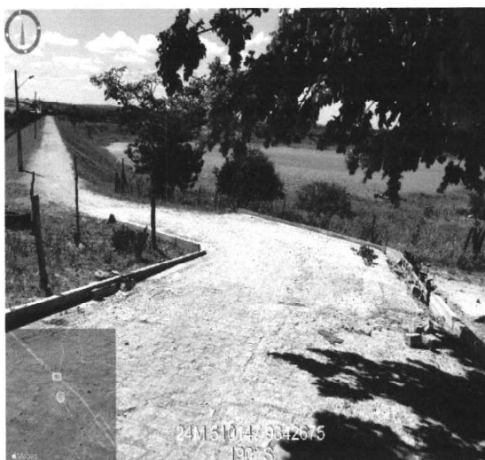
EXECUÇÃO DE MEIO FIO (14/10/2022 A 13/01/2023)
