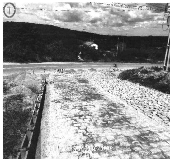
ASSENTAMENTO DE MEIO FIO (14/10/2022 A 13/01/2023)
