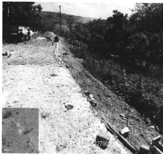
ASSENTAMENTO DE MEIO FIO (14/10/2022 A 13/01/2023)
