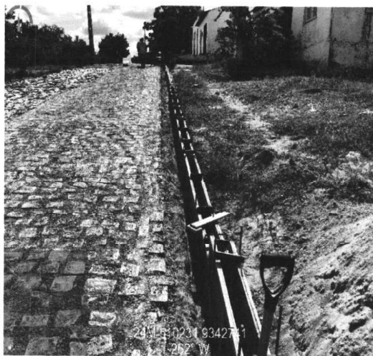
EXECUÇÃO DE MEIO FIO (14/10/2022 A 13/01/2023)
