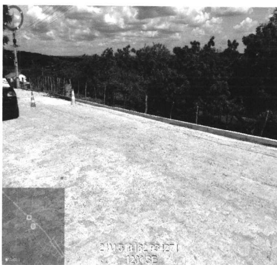
EXECUÇÃO DE MEIO FIO (14/10/2022 A 13/01/2023)
