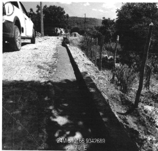
EXECUÇÃO DE SARJETAS (31/10/2022 A 13/01/2023)
