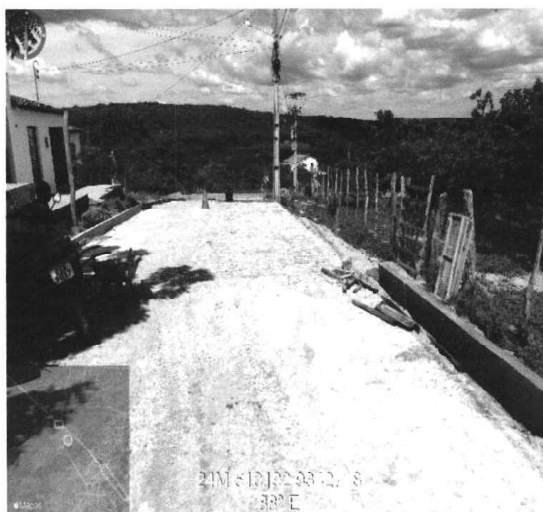
ASSENTAMENTO DE MEIO FIO (14/10/2022 A 13/01/2023)
