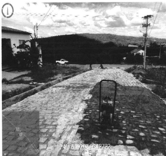
ASSENTAMENTO DE MEIO FIO (14/10/2022 A 13/01/2023)
