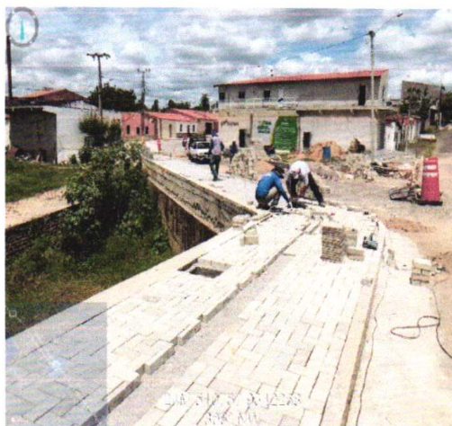
ASSENTAMENTO DE PISO INTERTRAVADO (01/02/2023 A 23/02/2023)
