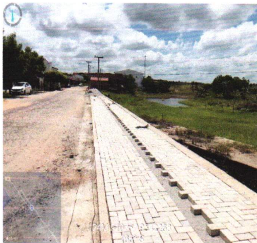
ASSENTAMENTO DE PISO INTERTRAVADO (01/02/2023 A 23/02/2023)
