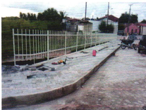
ASSENTAMENTO DE GUARDA CORPO (24/02/2023 A 28/02/2023)
