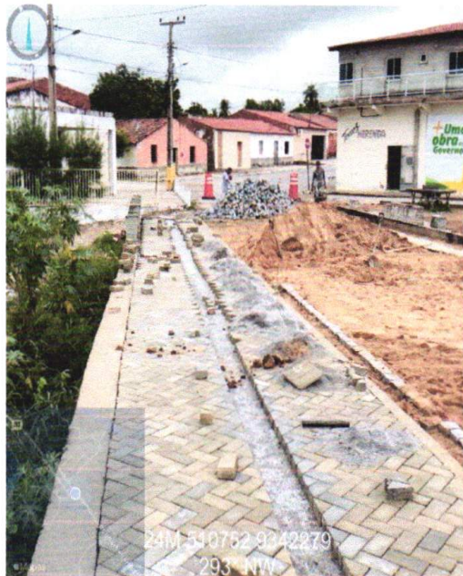
EXECUÇÃO EM PAVIMENTAÇÃO EM PARALELEPÍPEDO (15/02/2023 A 20/02/2023)
