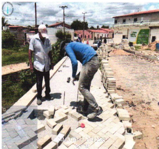
ASSENTAMENTO DE PISO INTERTRAVADO (01/02/2023 A 23/02/2023)
