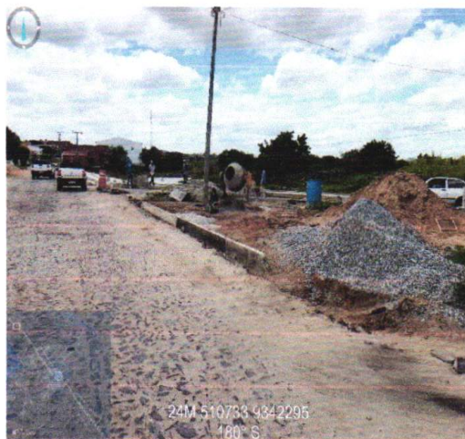
EXECUÇÃO DE BANQUETA DE MEIO FIO MOLDADA IN LOCO (09/02/2023 A 17/02/2023)
