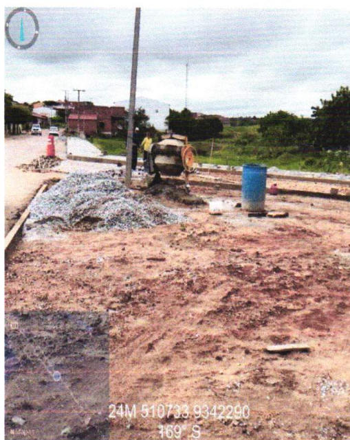
EXECUÇÃO DE BANQUETA DE MEIO FIO MOLDADA IN LOCO (09/02/2023 A 17/02/2023)
