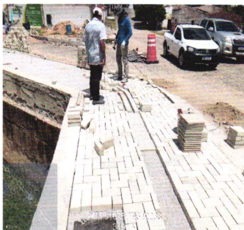
ASSENTAMENTO DE PISO INTERTRAVADO (01/02/2023 A 23/02/2023)
