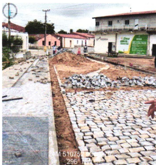
EXECUÇÃO EM PAVIMENTAÇÃO EM PARALELEPÍPEDO (15/02/2023 A 20/02/2023)
