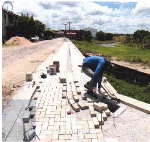
ASSENTAMENTO DE PISO INTERTRAVADO (01/02/2023 A 23/02/2023)
