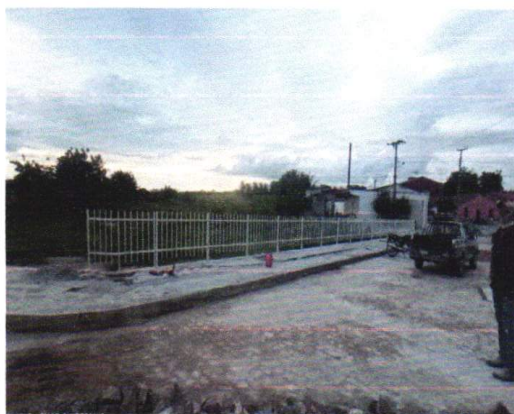
ASSENTAMENTO DE GUARDA CORPO (24/02/2023 A 28/02/2023)
