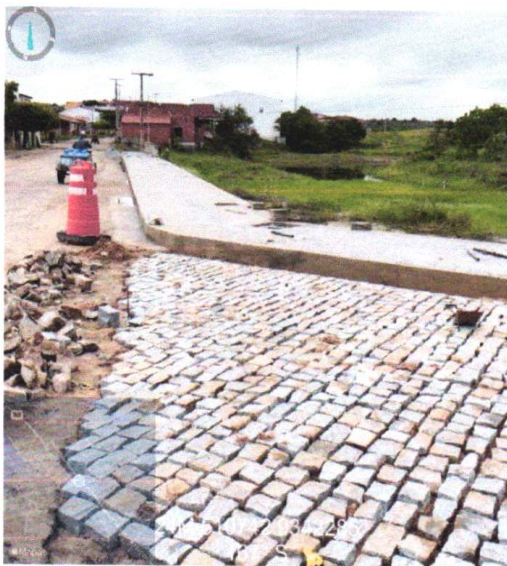
EXECUÇÃO EM PAVIMENTAÇÃO EM PARALELEPÍPEDO (15/02/2023 A 20/02/2023)
