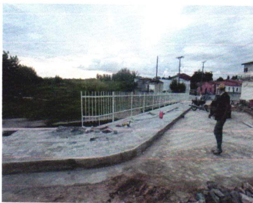
ASSENTAMENTO DE GUARDA CORPO (24/02/2023 A 28/02/2023)
