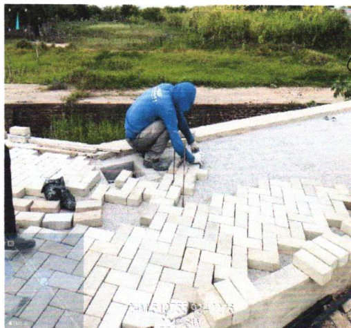
ASSENTAMENTO DE PISO INTERTRAVADO (01/02/2023 A 23/02/2023)
