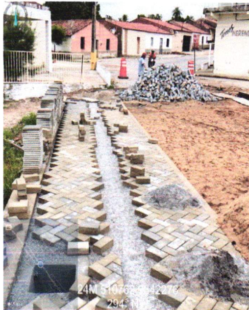
ASSENTAMENTO DE PISO INTERTRAVADO (01/02/2023 A 23/02/2023)
