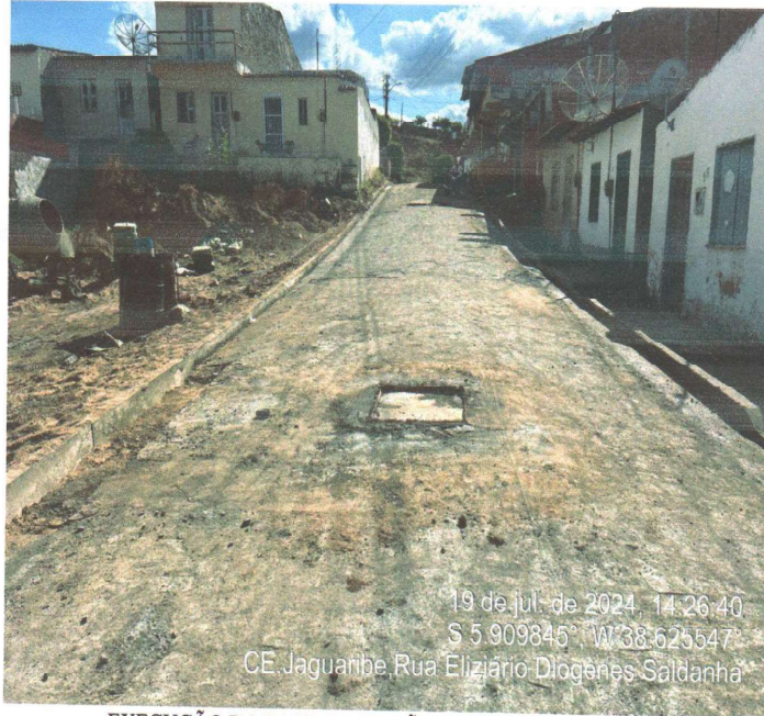
EXECUÇÃO DA PAVIMENTAÇÃO EM PARALELEPÍPEDO
