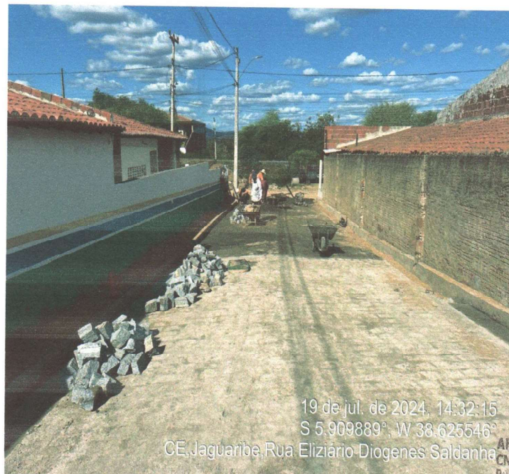
EXECUÇÃO DA PAVIMENTAÇÃO EM PARALELEPÍEDO
