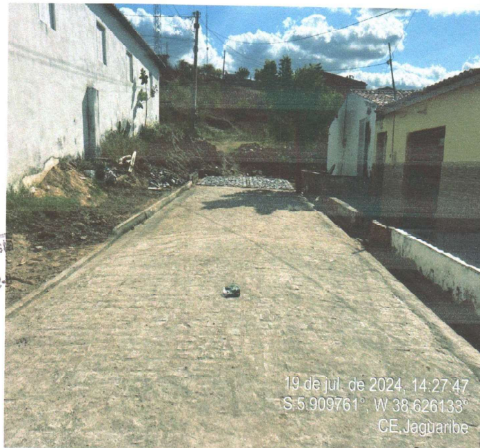
EXECUÇÃO DA PAVIMENTAÇÃO EM PARALELEPÍPEDO
