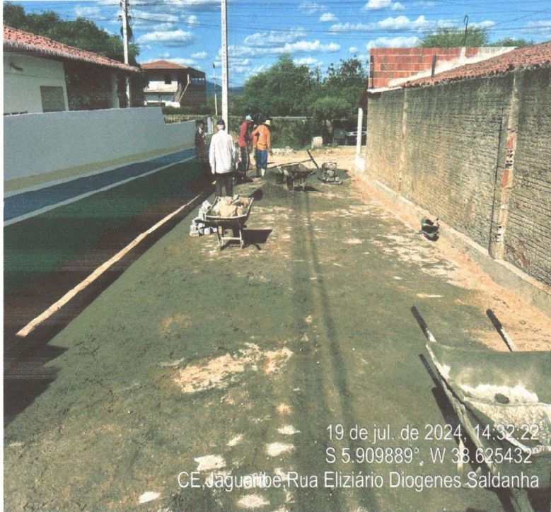
EXECUÇÃO DA PAVIMENTAÇÃO EM PARALELEPÍPEDO
