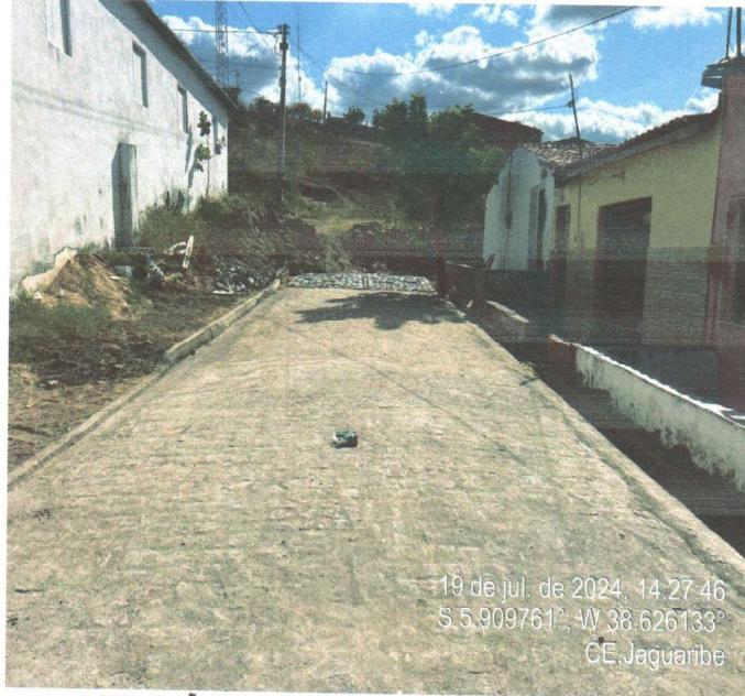
EXECUÇÃO DA PAVIMENTAÇÃO EM PARALELEPÍPEDO
