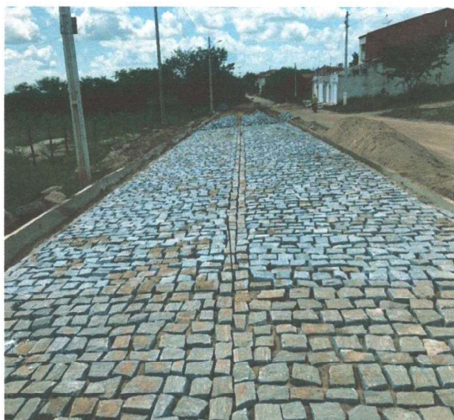
EXECUÇÃO DA PAVIMENTAÇÃO
