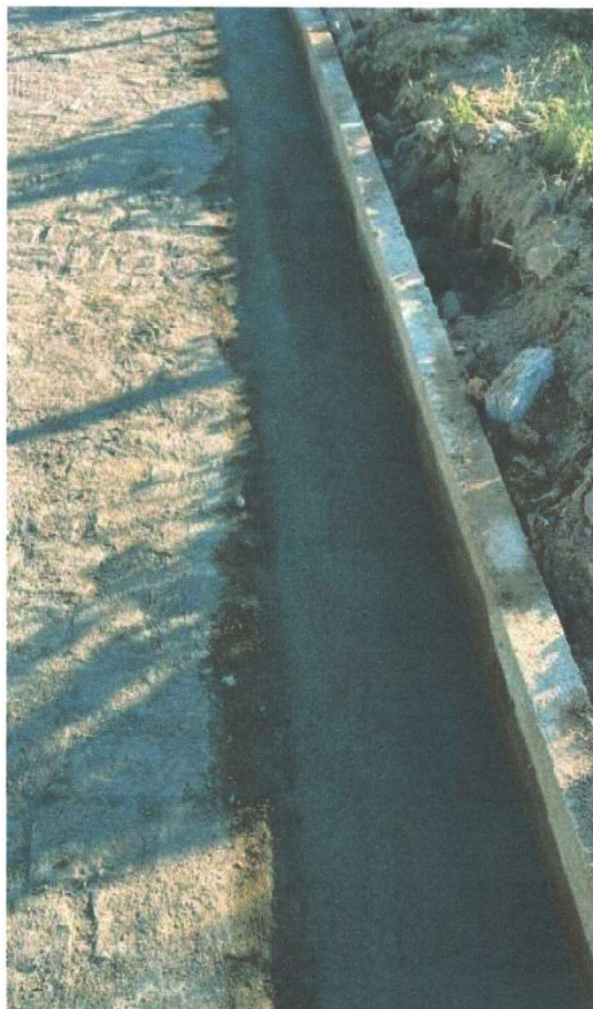
EXECUÇÃO DA SARJETA
