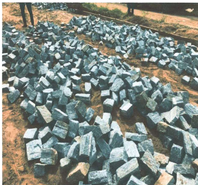
INICIO DA EXECUÇÃO DA PAVIMENTAÇÃO
