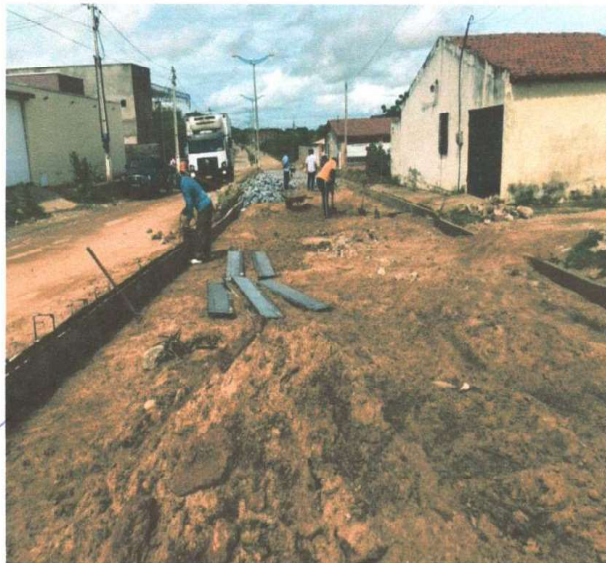
EXECUÇÃO DO MEIO FIO MOLDADO NO LOCAL
