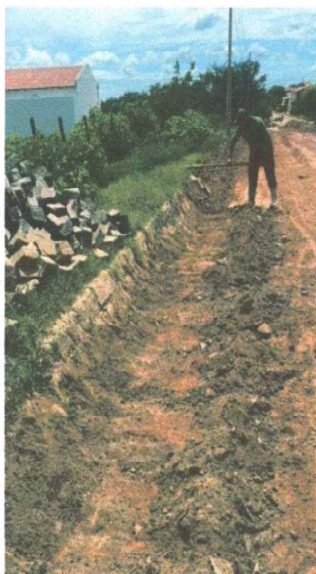
RETIRADA DE GUIAS E PEDRA TOSCA
