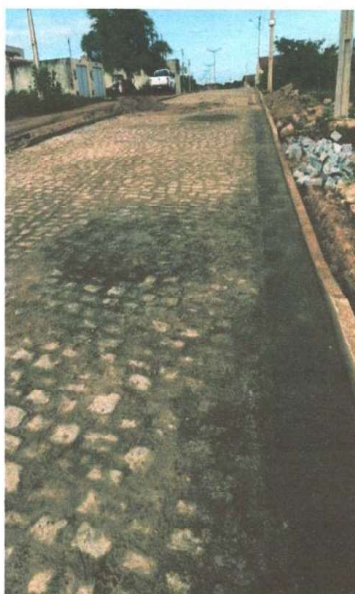
EXECUÇÃO DA SARJETA
