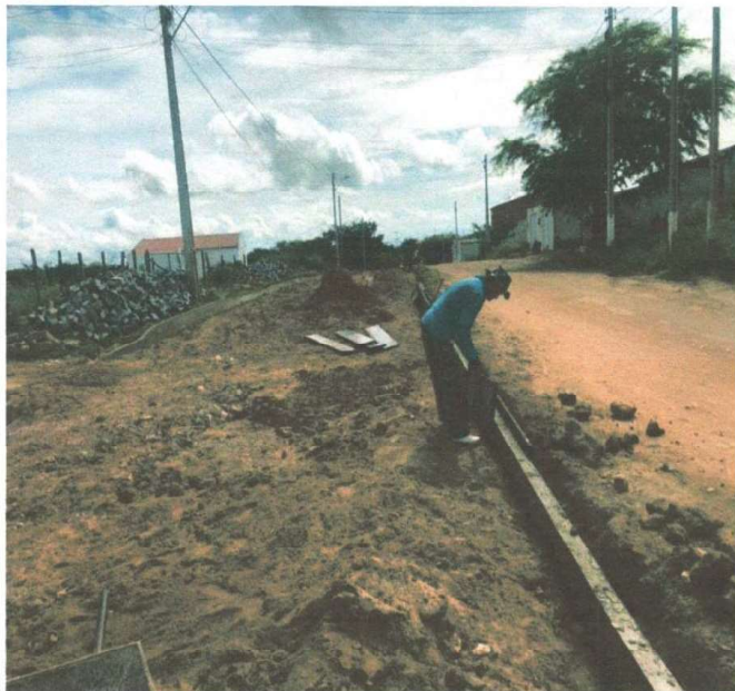
EXECUÇÃO DO MEIO FIO MOLDADO NO LOCAL
