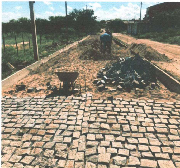
EXECUÇÃO DA PAVIMENTAÇÃO
