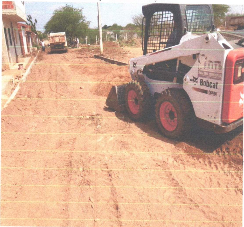
EXECUÇÃO DA PAVIMENTAÇÃO
