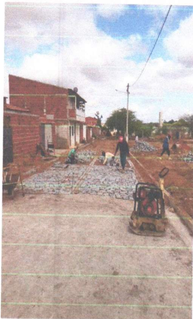
EXECUÇÃO DA PAVIMENTAÇÃO
