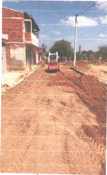
EXECUÇÃO DA PAVIMENTAÇÃO
