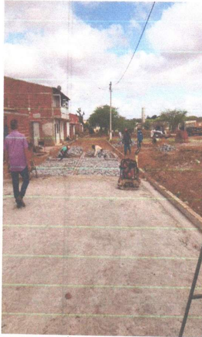
EXECUÇÃO DA PAVIMENTAÇÃO
