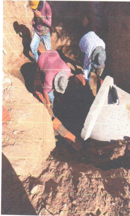
EXECUÇÃO DA DRENAGEM
