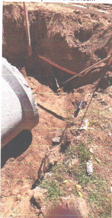
EXECUÇÃO DA DRENAGEM
