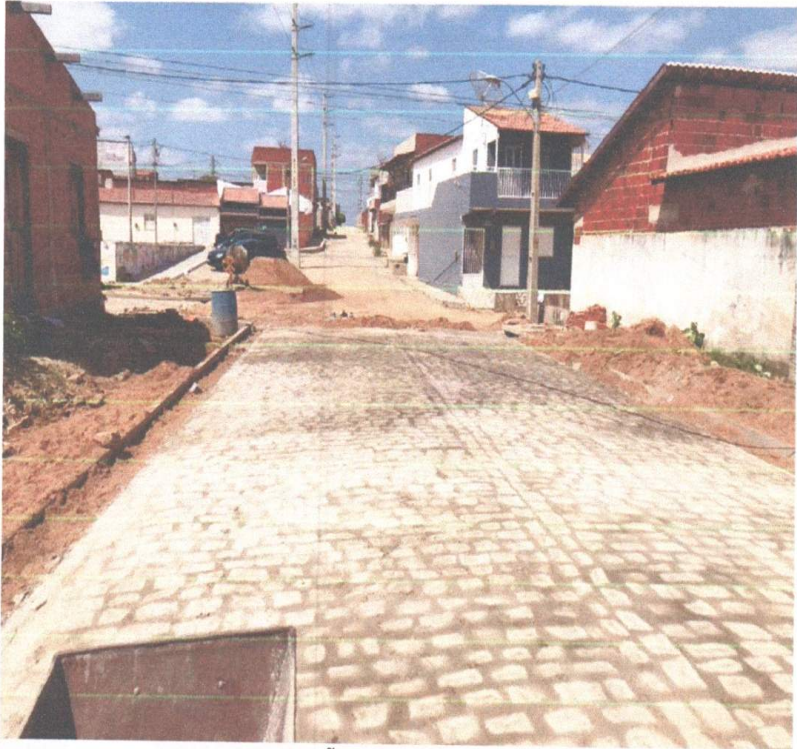
EXECUÇÃO DA PAVIMENTAÇÃO
