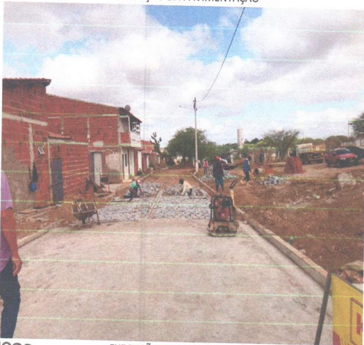
EXECUÇÃO DA PAVIMENTAÇÃO
