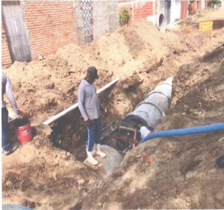
EXECUÇÃO DA DRENAGEM
