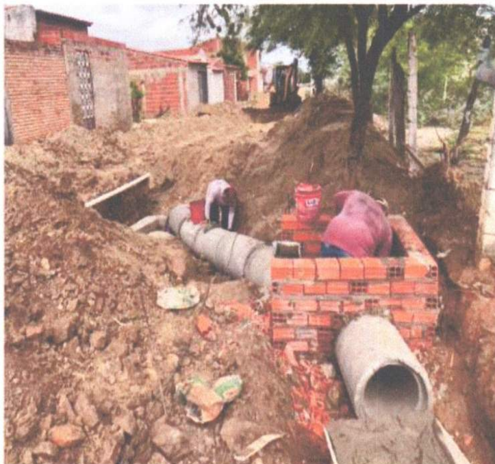
EXECUÇÃO DA DRENAGEM
