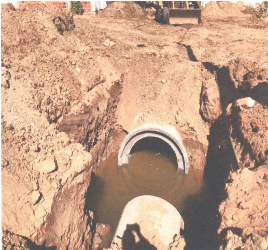
EXECUÇÃO DA DRENAGEM
