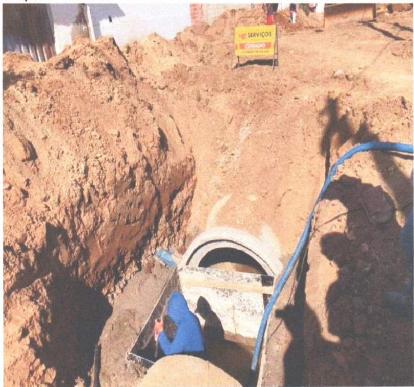
EXECUÇÃO DA DRENAGEM
