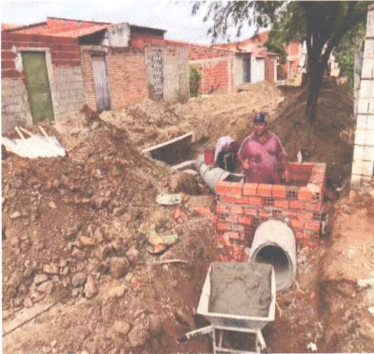
EXECUÇÃO DA DRENAGEM
