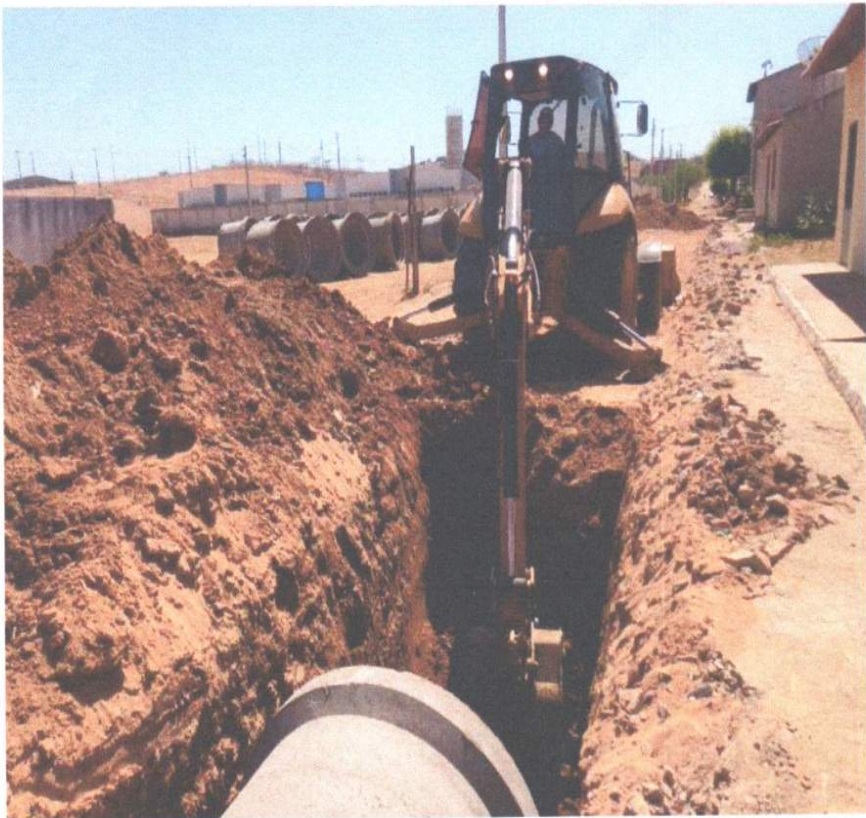
EXECUÇÃO DA DRENAGEM
