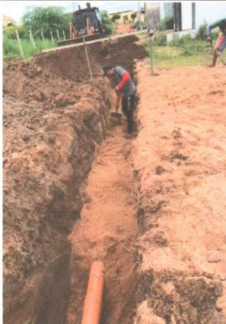
ESCAVAÇÃO E ASSENTAMENTO DE TUBULAÇÃO DE ESGOTO
