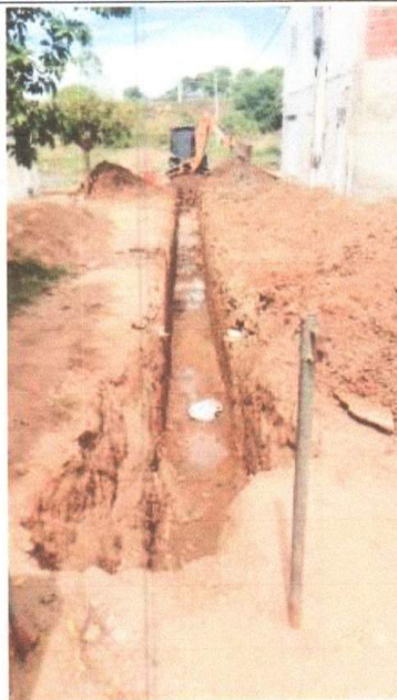
ESCAVAÇÃO MECANIZADA DE VALA
