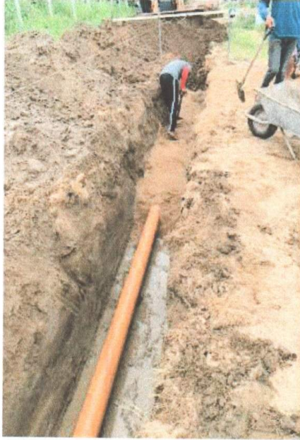
ASSENTAMENTO DE TUBULAÇÃO DE ESGOTO
