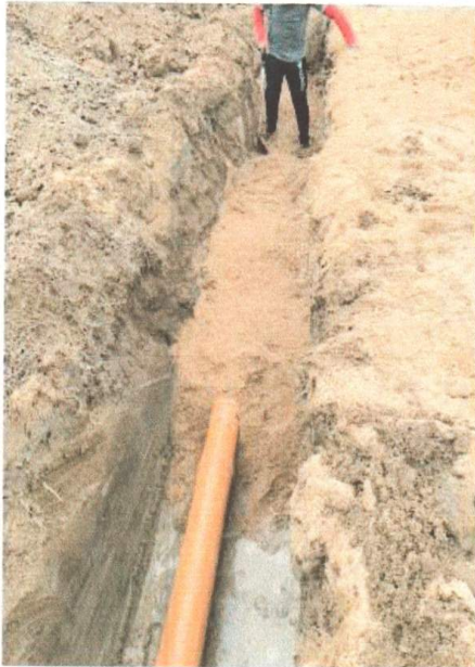
ASSENTAMENTO DE TUBULAÇÃO DE ESGOTO
