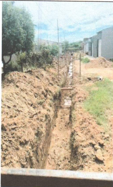
ESCAVAÇÃO MECANIZADA DE VALA
