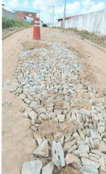
RECOMPOSIÇÃO DE PAVIMENTAÇÃO
