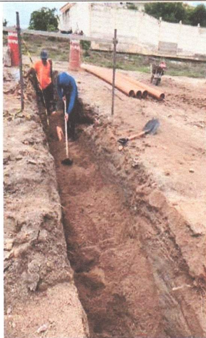
ASSENTAMENTO DE TUBOS
