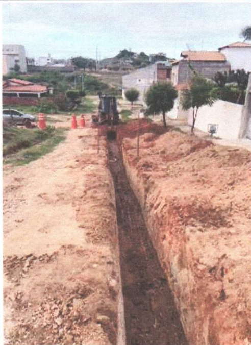
ESCAVAÇÃO MECANIZADA
