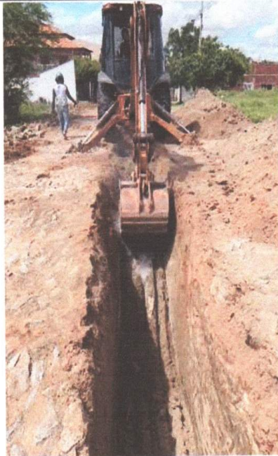
ESCAVAÇÃO MECANIZADA
