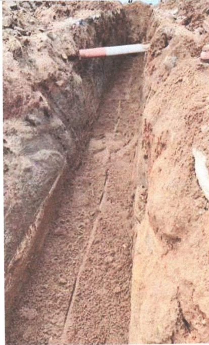
ASSENTAMENTO DE TUBULAÇÃO
