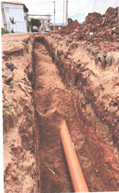
ASSENTAMENTO DE TUBULAÇÃO
