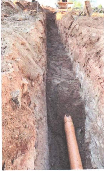
ASSENTAMENTO DE TUBULAÇÃO
