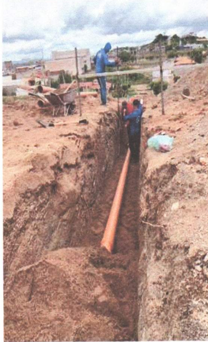
ASSENTAMENTO DE TUBOS
