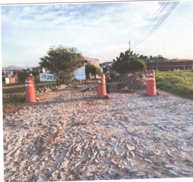
SINALIZAÇÃO DE TRÂNSITO COM BARREIRAS
