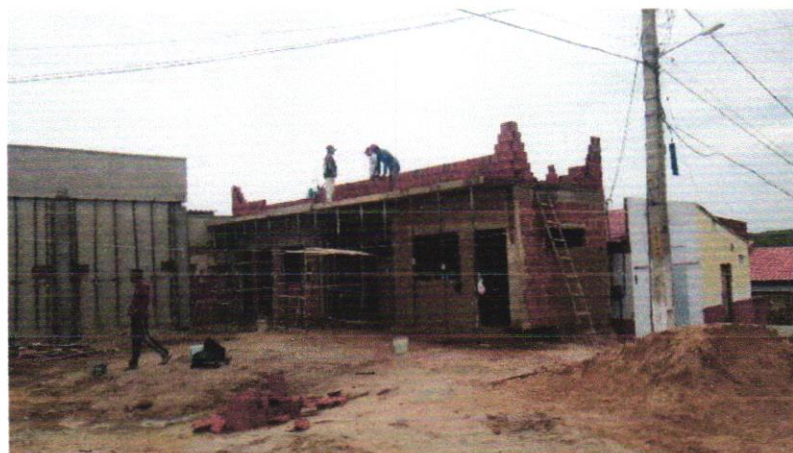
EXECUÇÃO DA PLATIBANA – 09/02/2023 A 10/02/2023
