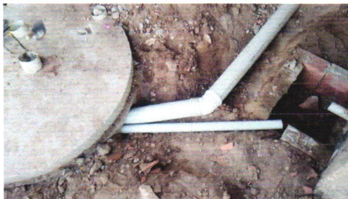
INSTALAÇÃO SANITÁRIAS – 07/02/2023 A 08/02/2023
