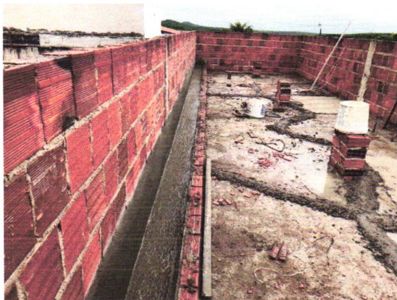
EXECUÇÃO DA CALHA DE COBERTA - 16/02/2023 A 17/02/2023
