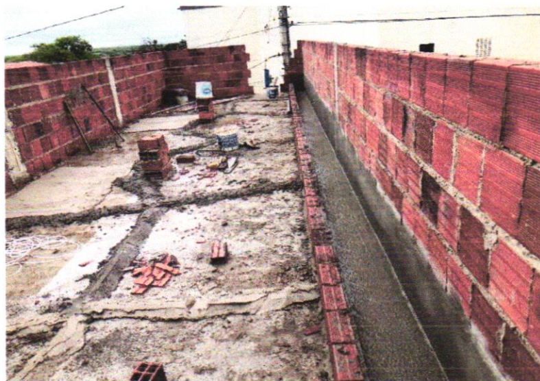
EXECUÇÃO DA CALHA DE COBERTA - 16/02/2023 A 17/02/2023
