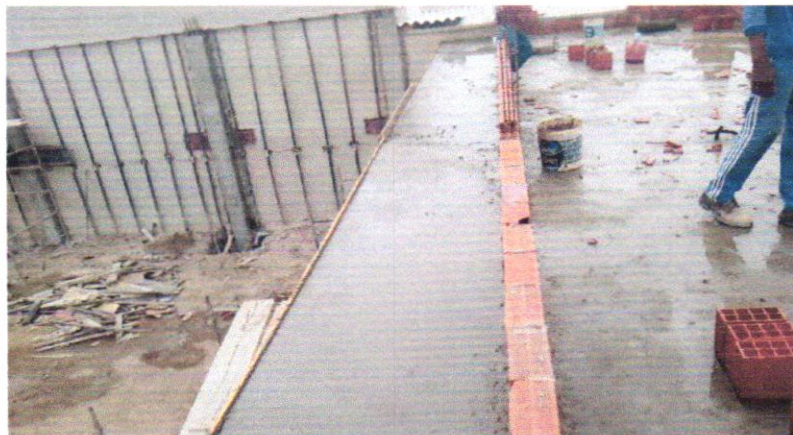
EXECUÇÃO DA PLATIBANA – 09/02/2023 A 10/02/2023
