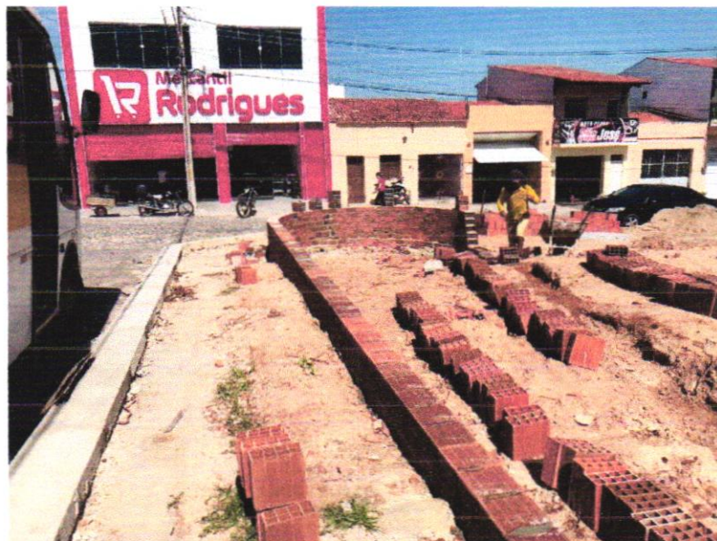
EXECUÇÃO DE ALVENARIA DAS JARDINEIRAS – 16/02/2023 A 17/02/2023
