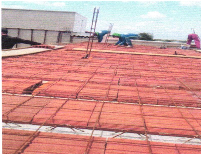
EXECUÇÃO DE LAJE (MONTAGEM DOS TRILHOS; POSICIONAMENTO DAS LAJOTAS; CONCRETAGEM – 01/02/2023 A 06/02/2023
