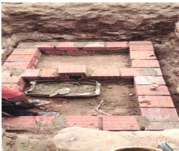
INSTALAÇÃO SANITÁRIAS – 07/02/2023 A 08/02/2023
