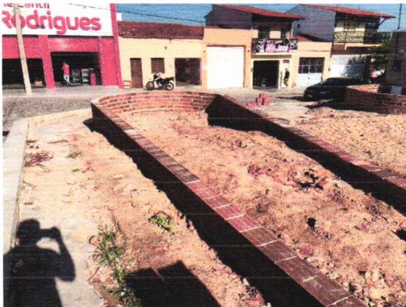
EXECUÇÃO DE ALVENARIA DAS JARDINEIRAS – 16/02/2023 A 17/02/2023
