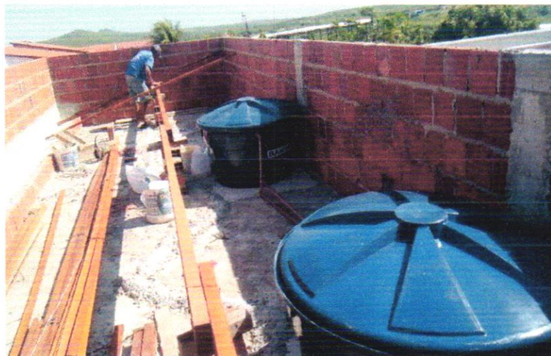
EXECUÇÃO DE MADEIRAMENTO E COBERTA – 16/02/2023 A 22/02/2023
