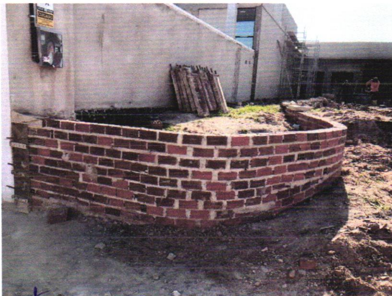
EXECUÇÃO DE ALVENARIA DAS JARDINEIRAS – 16/02/2023 A 17/02/2023
