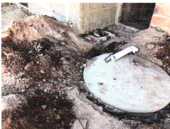
INSTALAÇÃO SANITÁRIAS – 07/02/2023 A 08/02/2023
