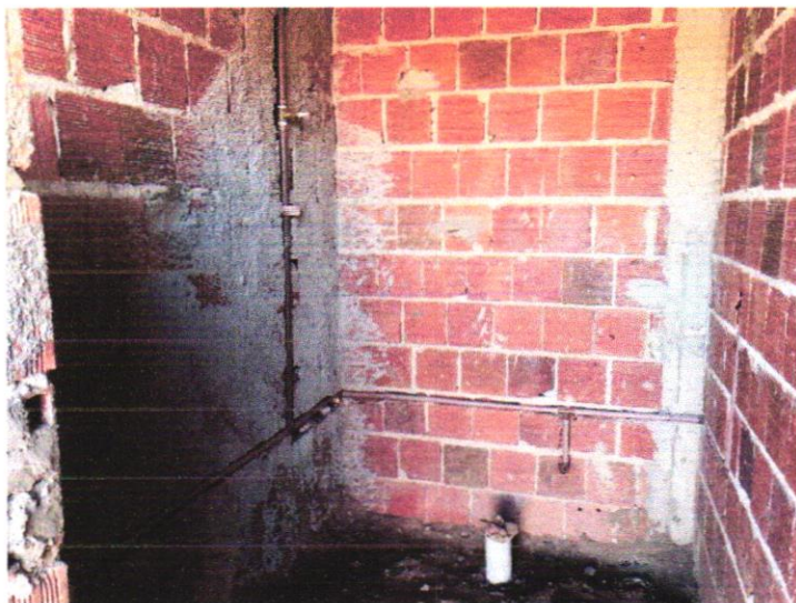
INSTALAÇÃO HIDRÁULICAS – 30/01/2023 A 07/02/2023
