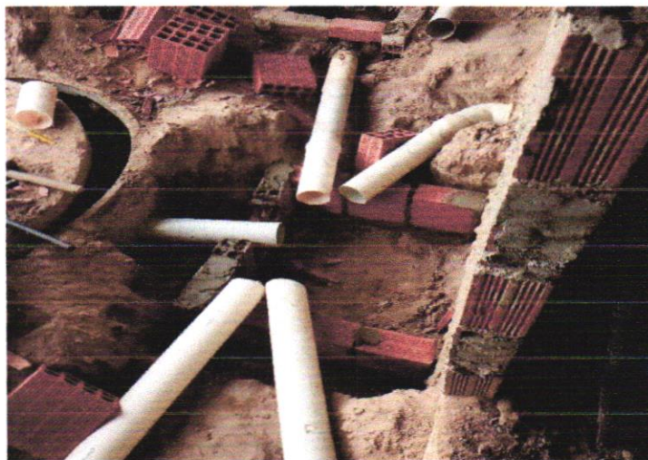
INSTALAÇÃO SANITÁRIAS – 07/02/2023 A 08/02/2023
