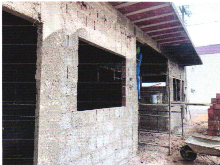
CHAPISCO NAS PAREDES – 23/02/2023 A 24/02/2023
