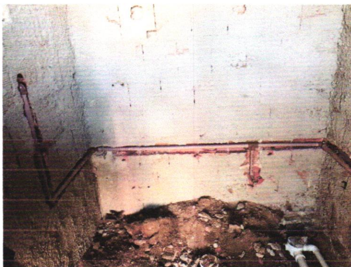
INSTALAÇÃO HIDRÁULICAS – 30/01/2023 A 07/02/2023
