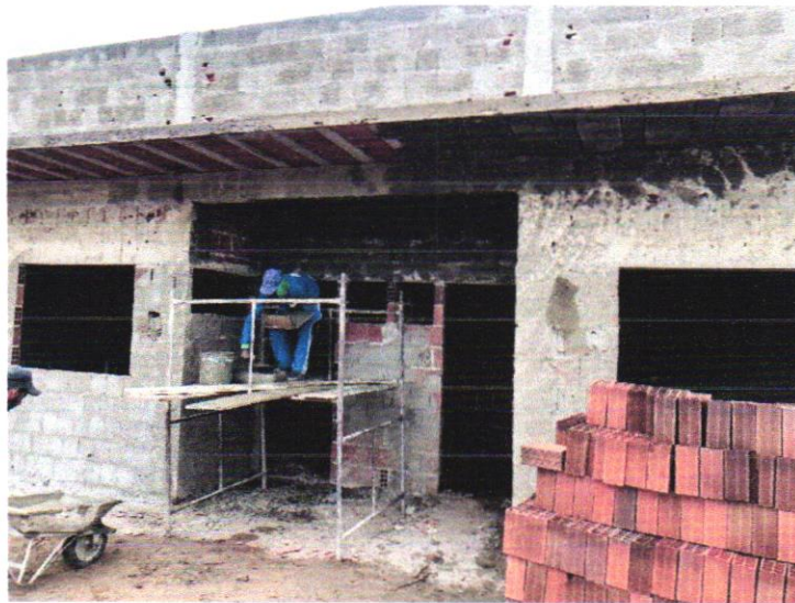
CHAPISCO NAS PAREDES – 23/02/2023 A 24/02/2023
