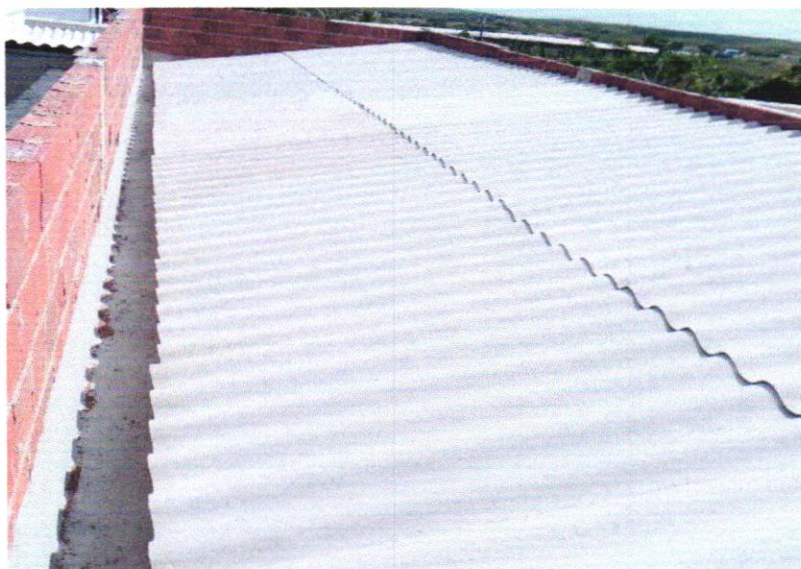
EXECUÇÃO DE MADEIRAMENTO E COBERTA – 16/02/2023 A 22/02/2023
