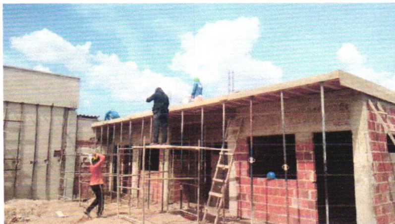
EXECUÇÃO DE LAJE (MONTAGEM DOS TRILHOS; POSICIONAMENTO DAS LAJOTAS; CONCRETAGEM – 01/02/2023 A 06/02/2023
