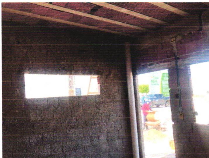
INSTALAÇÃO ELÉTRICA – 26/01/2023 A 01/02/2023
