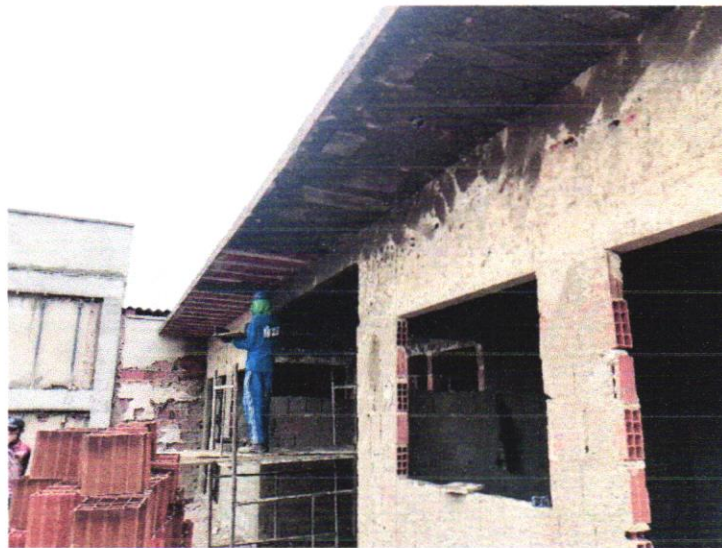
CHAPISCO NO TETO – 27/02/2023 A 28/02/2023
