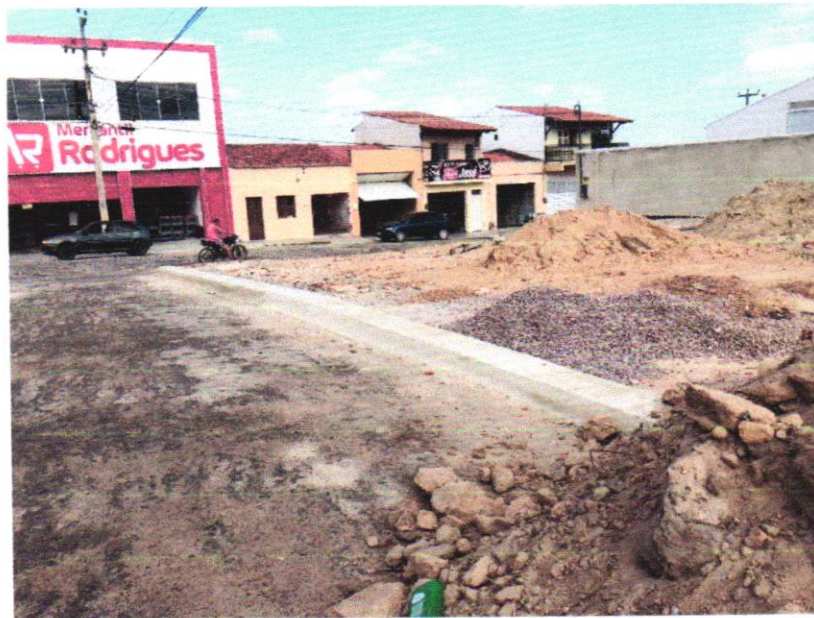
FOTO – 09 – ESCAVAÇÃO DE VALA E ASSENTAMENTO DE BANQUETA DE MEIO FIO
