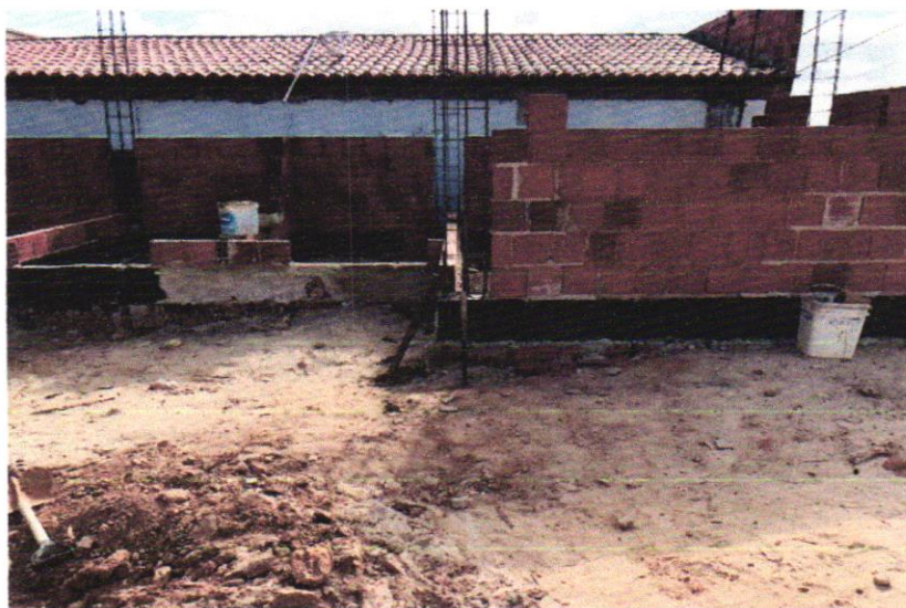
FOTO – 13 – EXECUÇÃO DE ESTRUTURAS, ALVENARIA DE EMBASAMENTO, ALVENARIAS DE FECHAMENTO E IMPERMEABILIZAÇÃO DE VIGA BALDRAME
