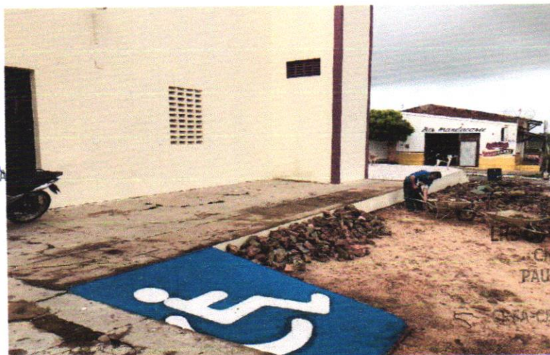
FOTO – 06 - DEMOLIÇÃO DE FORMA MECANIZADA, DO PISO CIMENTADO SOBRE LASTRO DE CONCRETO, COM RETIRADA DE ENTULHO.
