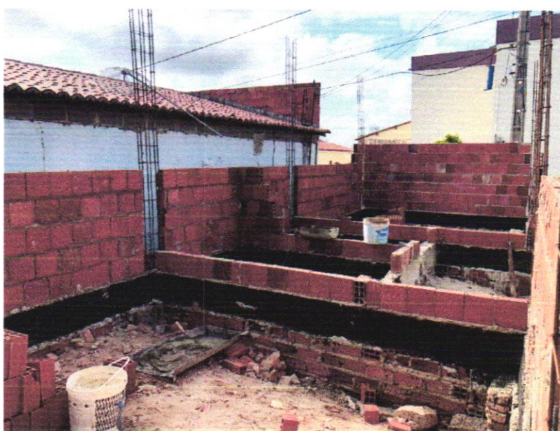
FOTO – 15 – EXECUÇÃO DE ESTRUTURAS, ALVENARIA DE EMBASAMENTO, ALVENARIAS DE FECHAMENTO E IMPERMEABILIZAÇÃO DE VIGA BALDRAME
