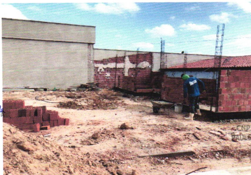
FOTO – 12 – EXECUÇÃO DE ESTRUTURAS, ALVENARIA DE EMBASAMENTO, ALVENARIAS DE FECHAMENTO E IMPERMEABILIZAÇÃO DE VIGA BALDRAME
