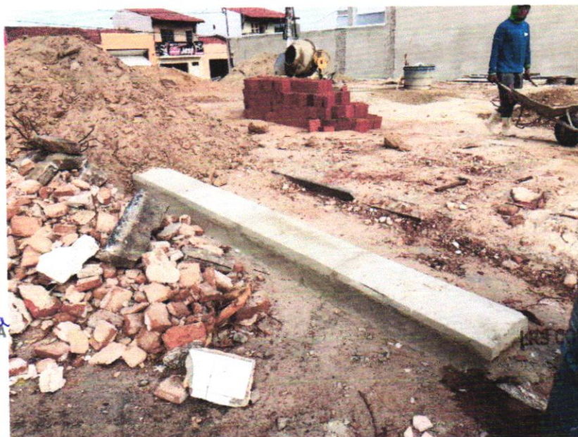
FOTO – 07 – ESCAVAÇÃO DE VALA E ASSENTAMENTO DE BANQUETA DE MEIO FIO
