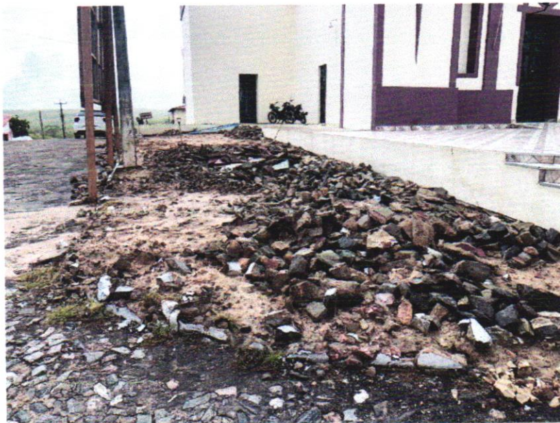
FOTO – 05 - DEMOLIÇÃO DE FORMA MECANIZADA, DO PISO CIMENTADO SOBRE LASTRO DE CONCRETO, COM RETIRADA DE ENTULHO.
