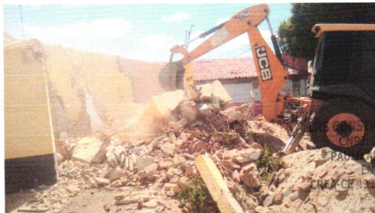
FOTO – 02 - DEMOLIÇÃO DE ALVENARIA PARA QUALQUER TIPO DE BLOCO, DE FORMA MECANIZADA, SEM REAPROVEITAMENTO. DE COBERTURA C/TELHAS CERÂMICAS DE PISO CIMENTADO SOBRE LASTRO DE CONCRETO
