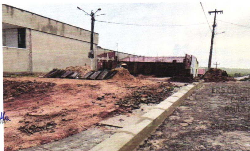
FOTO – 08 – ESCAVAÇÃO DE VALA E ASSENTAMENTO DE BANQUETA DE MEIO FIO
