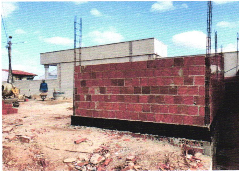
FOTO – 11 – EXECUÇÃO DE ESTRUTURAS, ALVENARIA DE EMBASAMENTO, ALVENARIAS DE FECHAMENTO E IMPERMEABILIZAÇÃO DE VIGA BALDRAME
