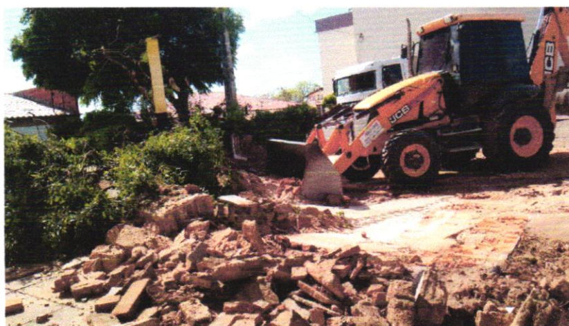
FOTO – 03 - DEMOLIÇÃO DE ALVENARIA, DE FORMA MECANIZADA, SEM REAPROVEITAMENTO DO PISO CIMENTADO SOBRE LASTRO DE CONCRETO
