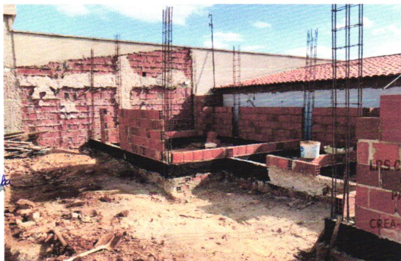
FOTO – 14 – EXECUÇÃO DE ESTRUTURAS, ALVENARIA DE EMBASAMENTO, ALVENARIAS DE FECHAMENTO E IMPERMEABILIZAÇÃO DE VIGA BALDRAME
