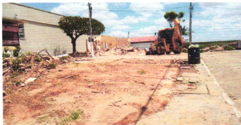
FOTO – 04 - DEMOLIÇÃO DE FORMA MECANIZADA, DO PISO CIMENTADO SOBRE LASTRO DE CONCRETO, COM RETIRADA DE ENTULHO.
