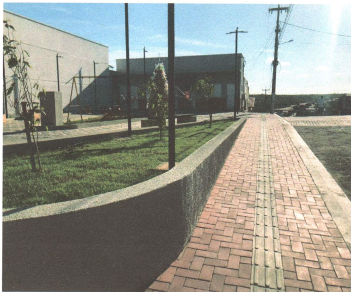
EXECUÇÃO DE PINTURA
