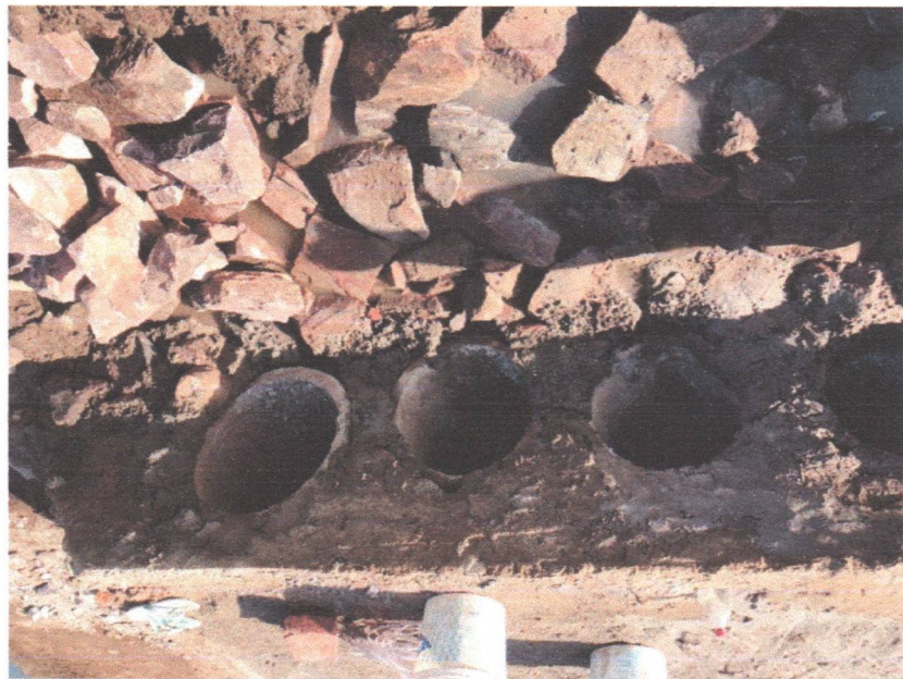
FOTO 13 - CONCRETO CICLÓPICO DE REGULARIZAÇÃO P/ ASSENTAMENTO DE MANILHAS (19/12/2022)
