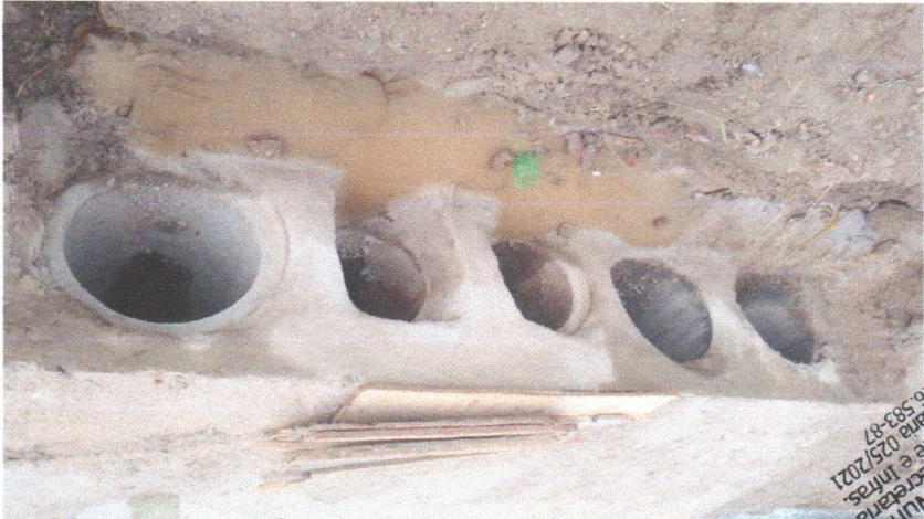
FOTO 14 - CONCRETO CICLÓPICO DE COBRIMENTO DAS MANILHAS (23/12/2022)
