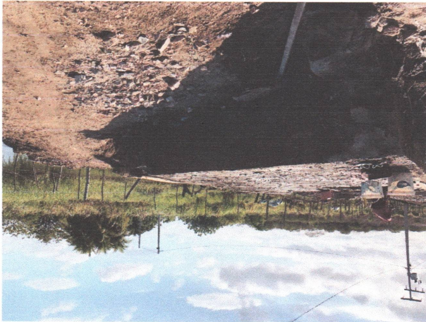
FOTO 14 - CONCRETO CICLÓPICO DE COBRIMENTO DAS MANILHAS (23/12/2022)
