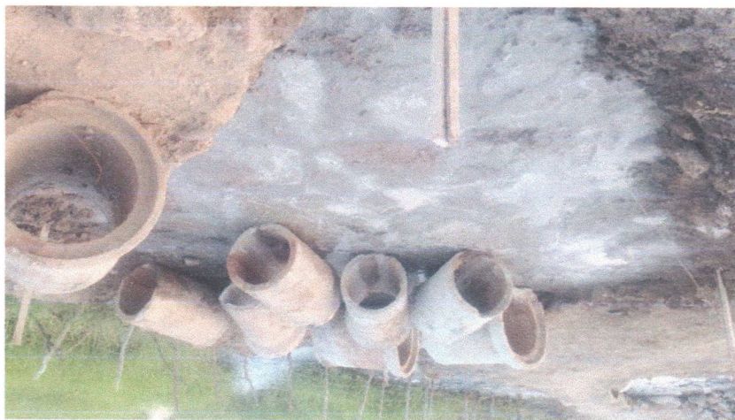
FOTO 13 - CONCRETO CICLÓPICO DE REGULARIZAÇÃO P/ ASSENTAMENTO DE MANILHAS (19/12/2022)
