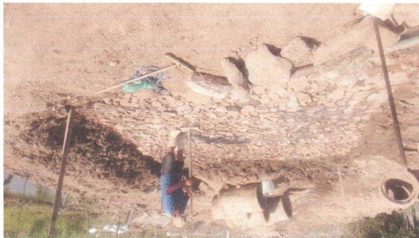
FOTO 11 - EXECUÇÃO DE ALVENARIA DE PEDRA (13/12/2022 A 04/01/2023)
