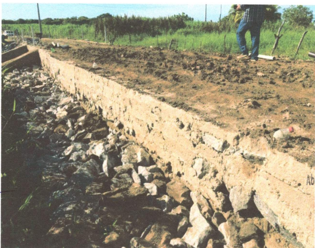
FOTO 08 – EXECUÇÃO DE ENROCAMENTO (24/04/2023 A 28/04/2023)
