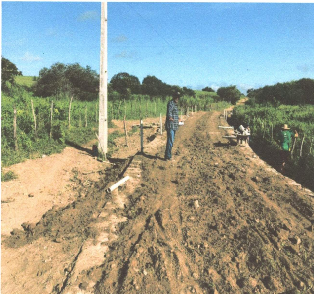
FOTO 06 – ESCAVAÇÃO E ATERRO (10/04/2023 A 20/04/2023)
