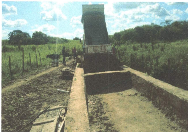
FOTO 04 – ESCAVAÇÃO E ATERRO (10/04/2023 A 20/04/2023)
