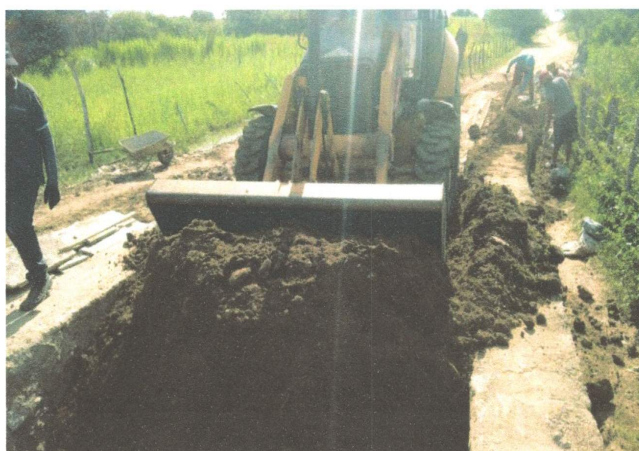
FOTO 02 – ESCAVAÇÃO E ATERRO (10/04/2023 A 20/04/2023)
