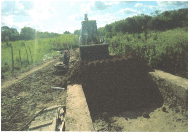
FOTO 05 – ESCAVAÇÃO E ATERRO (10/04/2023 A 20/04/2023)
