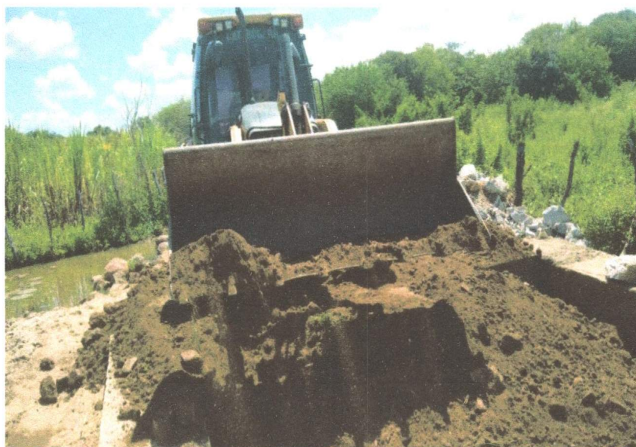
FOTO 01 – ESCAVAÇÃO E ATERRO (10/04/2023 A 20/04/2023)
