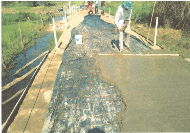
FOTO 13 – CONCRETAGEM (09/05/2023 A 19/05/2023)
