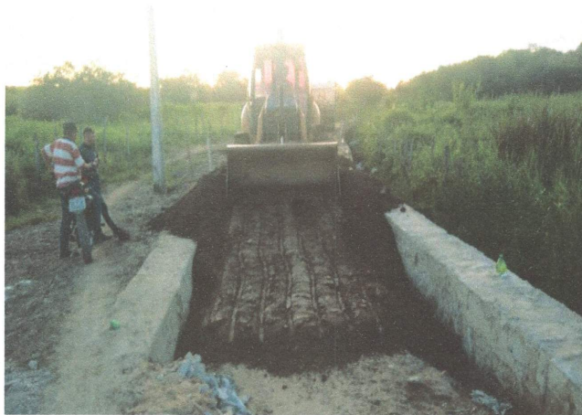
FOTO 03 – ESCAVAÇÃO E ATERRO (10/04/2023 A 20/04/2023)
