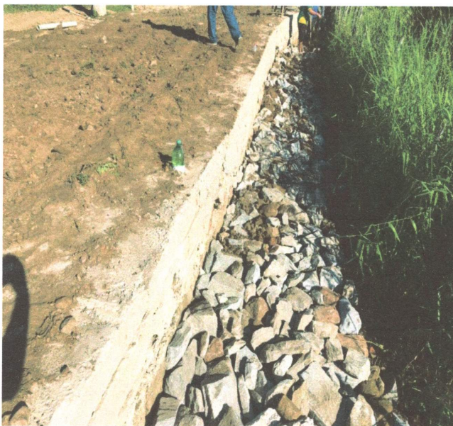
FOTO 07 – EXECUÇÃO DE ENROCAMENTO (24/04/2023 A 28/04/2023)
