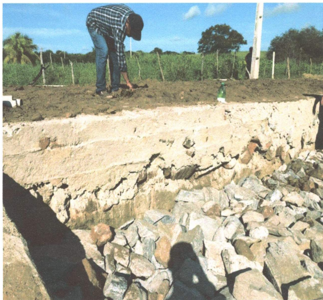
FOTO 10 – EXECUÇÃO DE ENROCAMENTO (24/04/2023 A 28/04/2023)
