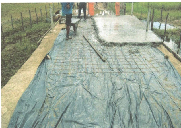
FOTO 12 – INSTALAÇÃO DE LONA E TELA DE AÇO (04/05/2023 A 08/05/2023)
