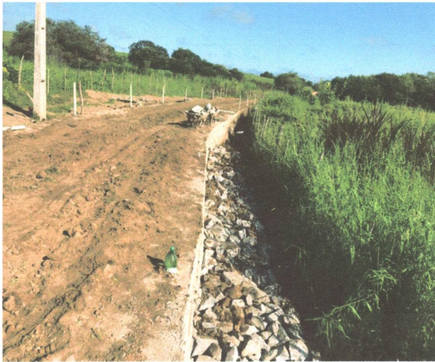
FOTO 09 – EXECUÇÃO DE ENROCAMENTO (24/04/2023 A 28/04/2023)
