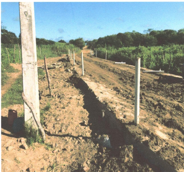
FOTO 11 – INSTALAÇÃO DE BALIZADOR (02/05/2023 A 03/05/2023)
