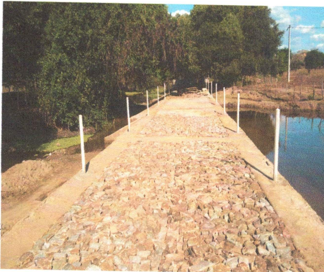
FOTO – 10 - PAVIMENTAÇÃO EM PEDRA TOSCA S/ REJUNTAMENTO (AGREGADO ADQUIRIDO), E BALIZADOR EM PVC RÍGIDO D=3" C/ENCHIMENTO DE CONCRETO– (DATA 09/11/2022 A 17/11/2022)
