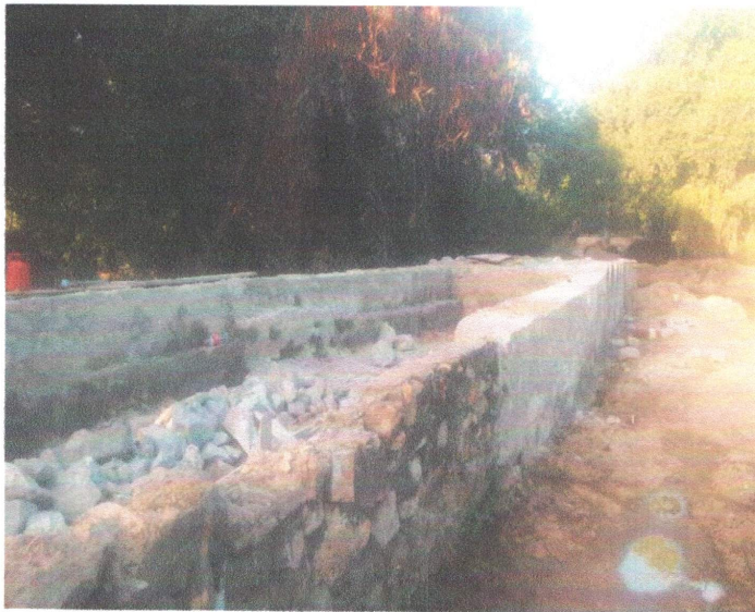
FOTO – 05 – ALVENARIA DE PEDRA – (DATA 09/11/2022 A 17/11/2022 E 05/12/2022 A 23/12/2022)
