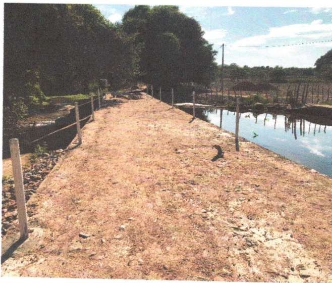
FOTO – 11 - PAVIMENTAÇÃO EM PEDRA TOSCA S/ REJUNTAMENTO (AGREGADO ADQUIRIDO), E BALIZADOR EM PVC RÍGIDO D=3" C/ENCHIMENTO DE CONCRETO– (DATA 09/11/2022 A 17/11/2022)
