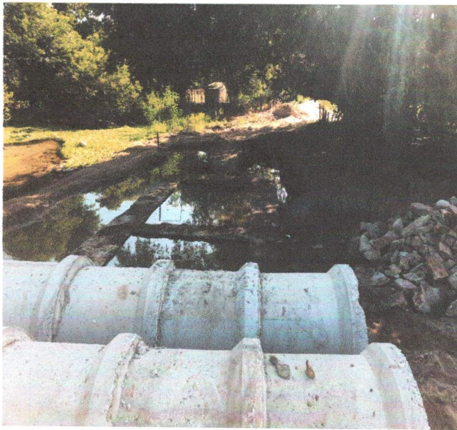
FOTO – 01 – EXECUÇÃO DE FUNDAÇÃO (DATA: 21/07/2022 A 29/07/2022)
