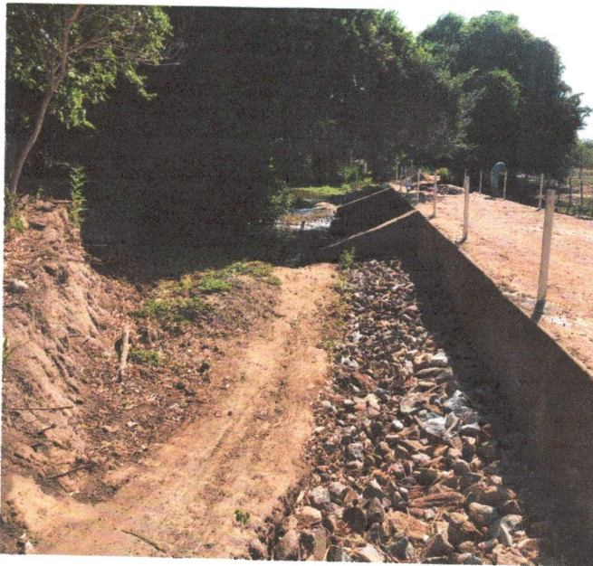
FOTO – 13 – ENROCAMENTO DE PEDRA – (DATA 20/10/2022 A 24/10/2022)
