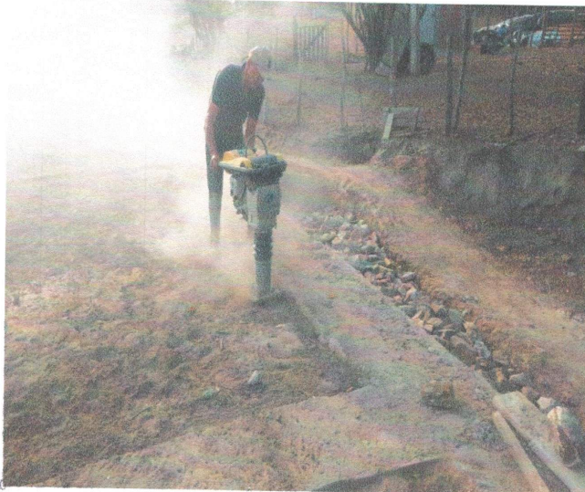
FOTO – 08 – ATERRO COMPACTADO – (DATA 21/10/2022 A 31/10/2022)
