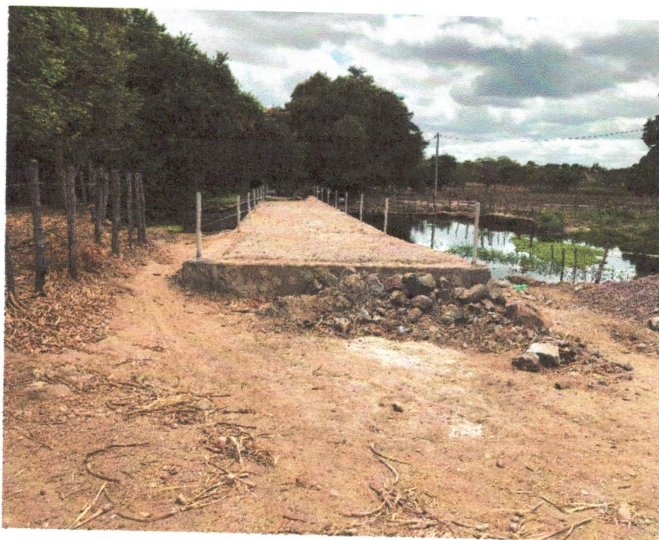
FOTO – 14 – BALIZADOR EM PVC RÍGIDO D=3" C/ENCHIMENTO DE CONCRETO– (DATA 03/01/2023 A 06/01/2023)
