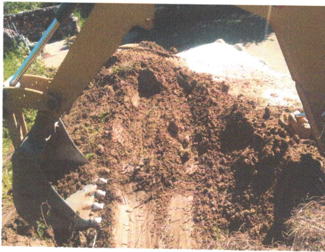
FOTO – 07 - ESCAVAÇÃO MECÂNICA SOLO DE 1ª CAT. PROF. ATÉ 2.00m – (DATA – 14/09/2022 A 21/09/2022)
