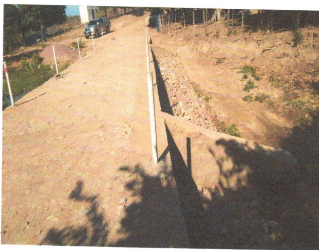
FOTO – 12 – ENROCAMENTO DE PEDRA – (DATA 20/10/2022 A 24/10/2022)
