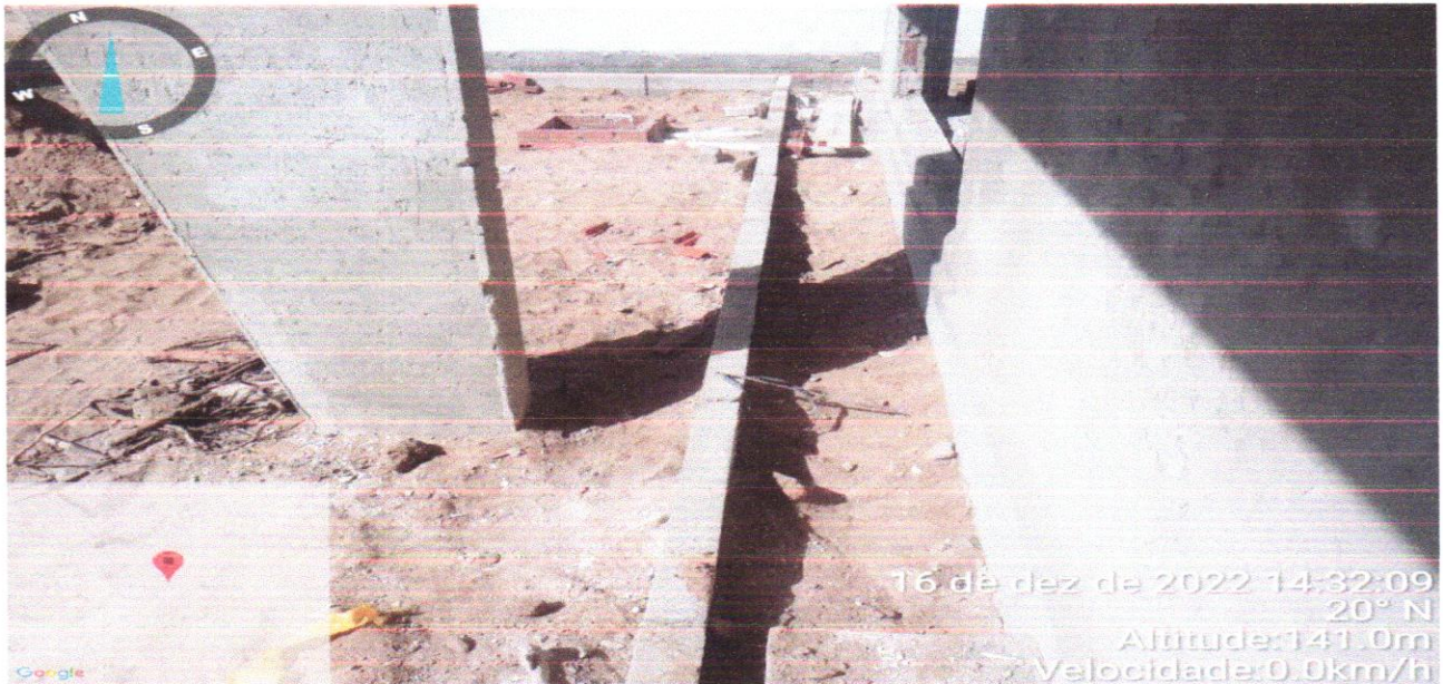
FOTO – 04 – (PISOS EXTERNOS E URBANIZAÇÃO) NA ÁREA DE PASSEIO) - LASTRO DE AREIA, BANQUETA/ MEIO FIO DE CONCRETO, (1,00x0,35x0,15m)
