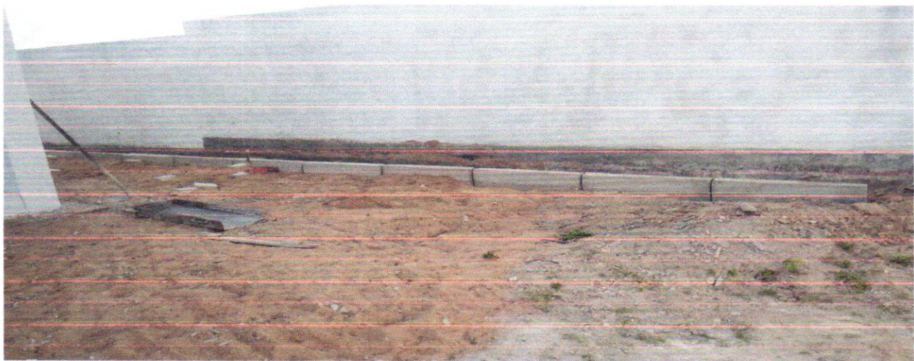
FOTO – 13 –DATA: 19/12/2022 - (PISOS EXTERNOS E URBANIZAÇÃO) NA ÁREA DE SECAGEM DE ROUPA) - LASTRO DE AREIA, BANQUETA/ MEIO FIO DE CONCRETO (1,00x0,35x0,15m)
