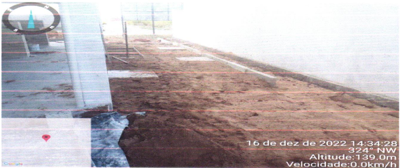
FOTO – 11 – (PISOS EXTERNOS E URBANIZAÇÃO) NA ÁREA DE SECAGEM DE ROUPA) - LASTRO DE AREIA, BANQUETA/ MEIO FIO DE CONCRETO (1,00x0,35x0,15m)
