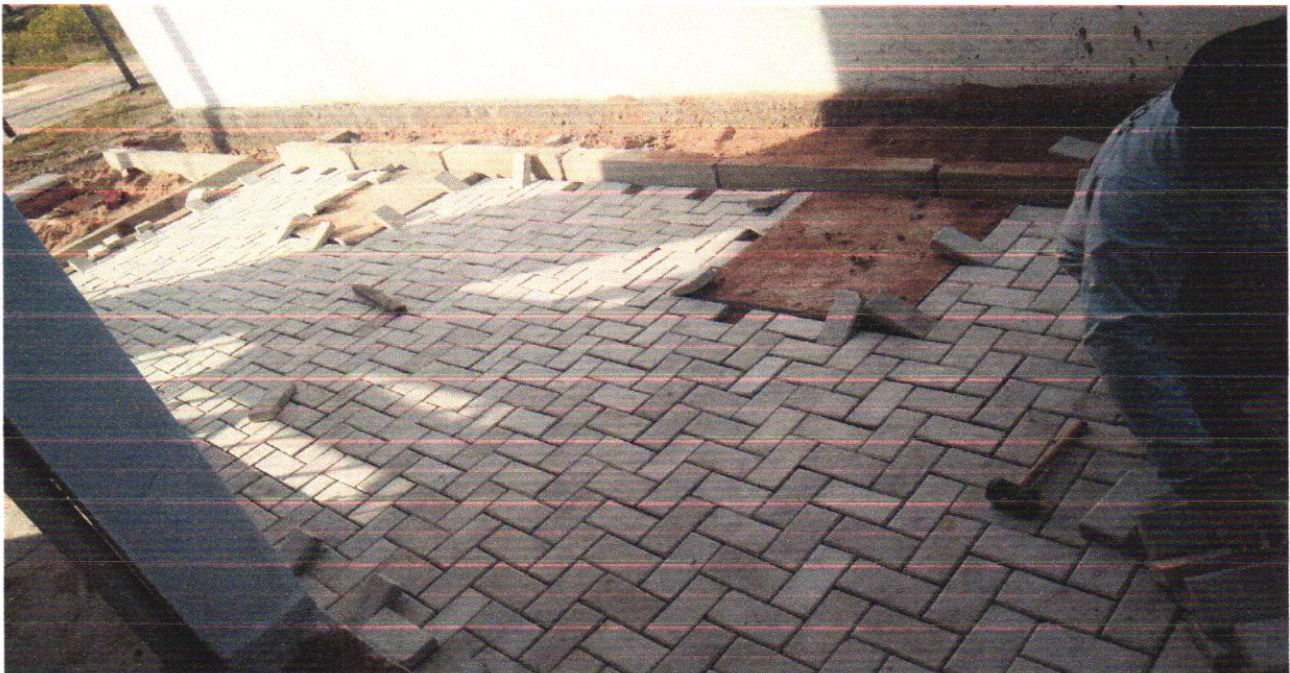
FOTO – 12 –DATA: 19/12/2022 - (PISOS EXTERNOS E URBANIZAÇÃO) NA ÁREA DE SECAGEM DE ROUPA) - PISO INTERTRAVADO TIPO TIJOLINHO (19,9x10x4)cm NA COR CINZA
