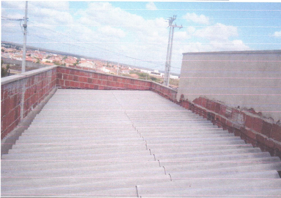
FOTO – 06 – 19/09/2022 - SERVIÇOS DE TELHA DE FIBROCIMENTO ONDULADA E= 8mm, INCLINAÇÃO 27%
