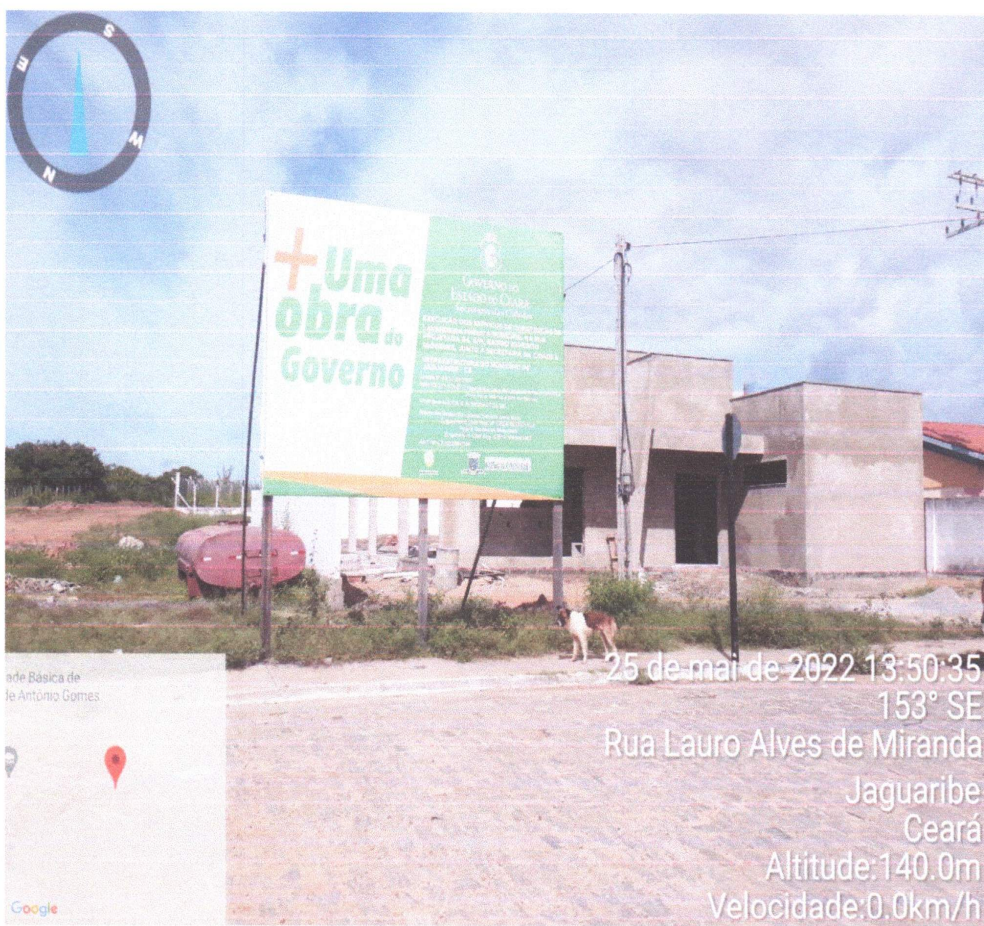
FOTO - 01 PLACA DE OBRA (DIA)
