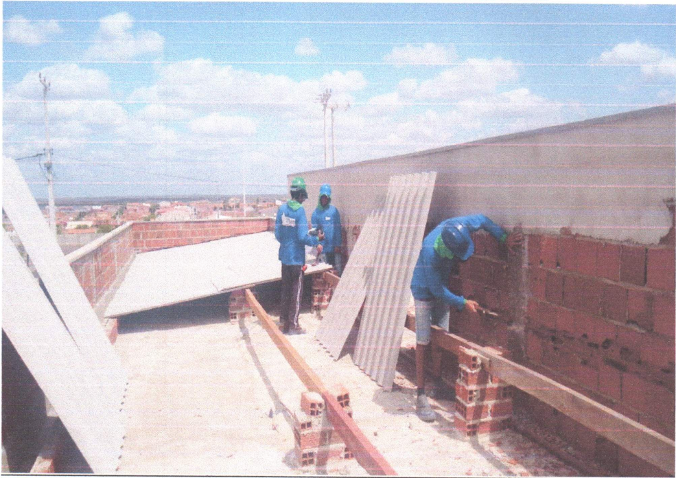
FOTO - 05 - 16/09/2022 - SERVIÇOS DE COBERTURA COM ESTRUTURA DE MADEIRA, APOIADA SOBRE LAJE DE FORRO E COLOCAÇÃO DE TELHA DE FIBROCIMENTO ONDULADA E= 8mm, INCLINAÇÃO 27%
