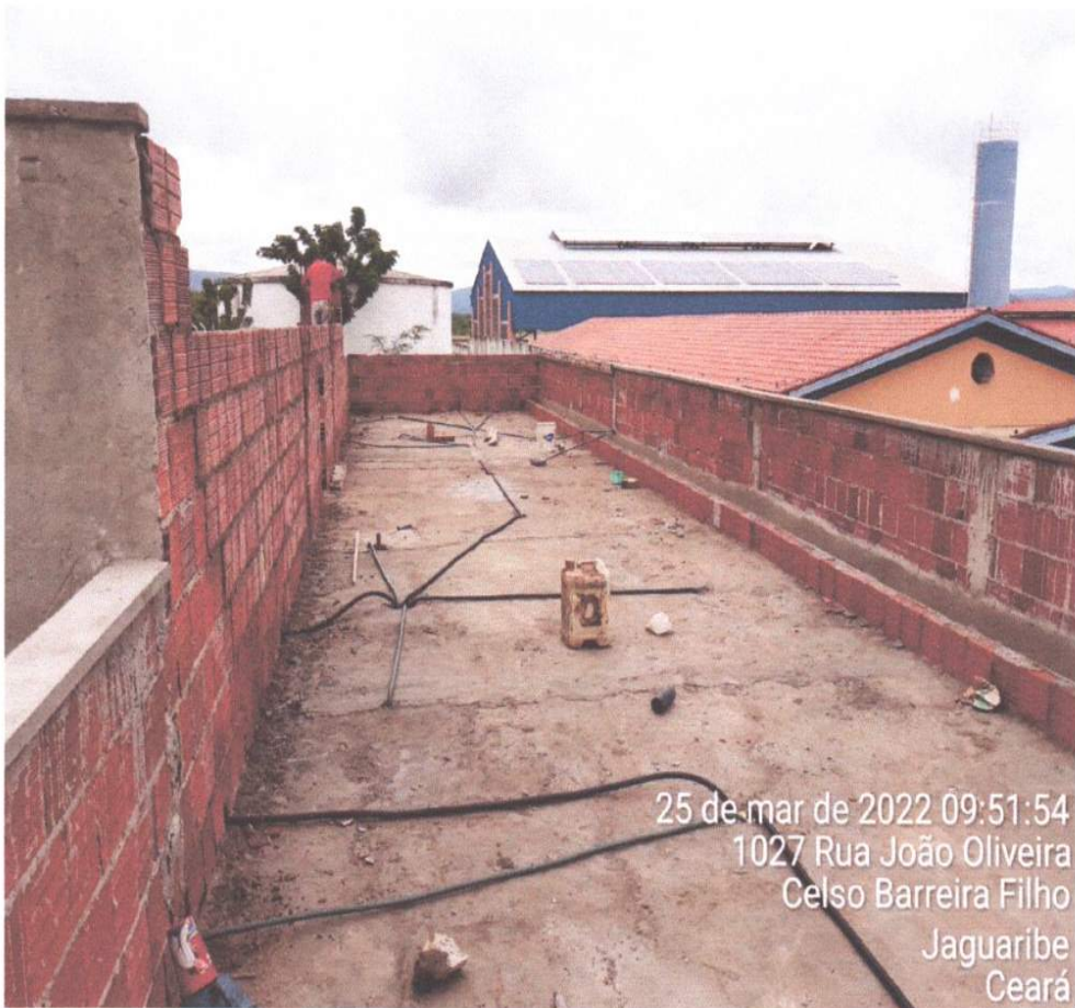
FOTO - 04 - SERVIÇOS DE ALVENARIA PARA A COBERTURA DO PREDIO
