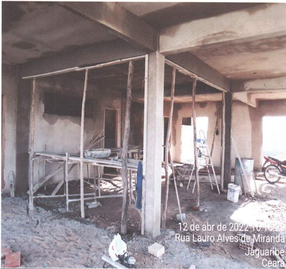
FOTO – 14 SERVIÇOS DE REBOCO NA PLACA E PILARES E VIRGAS
