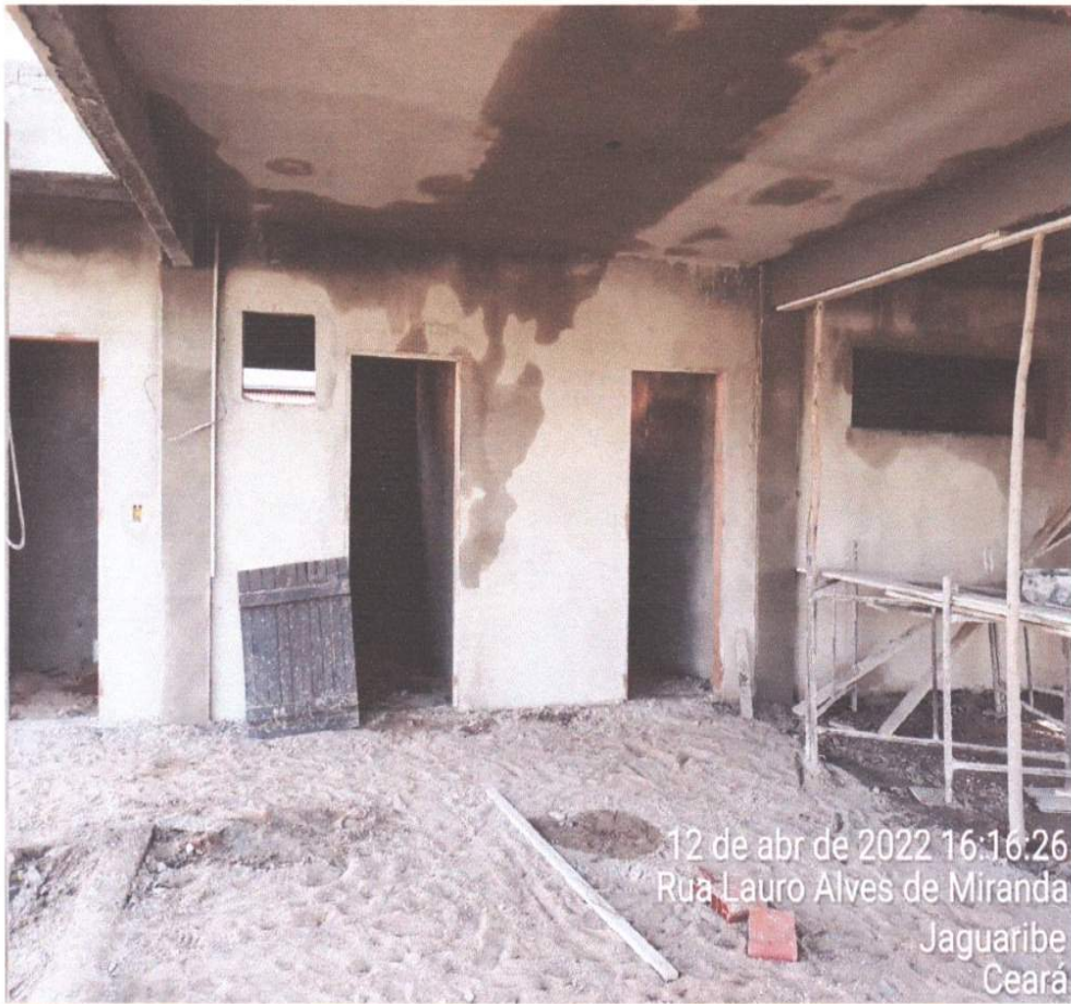
FOTO – 12 ACABAMENTO DE REBOCO NA PLACA PAREDES E PILARES E VIRGAS
