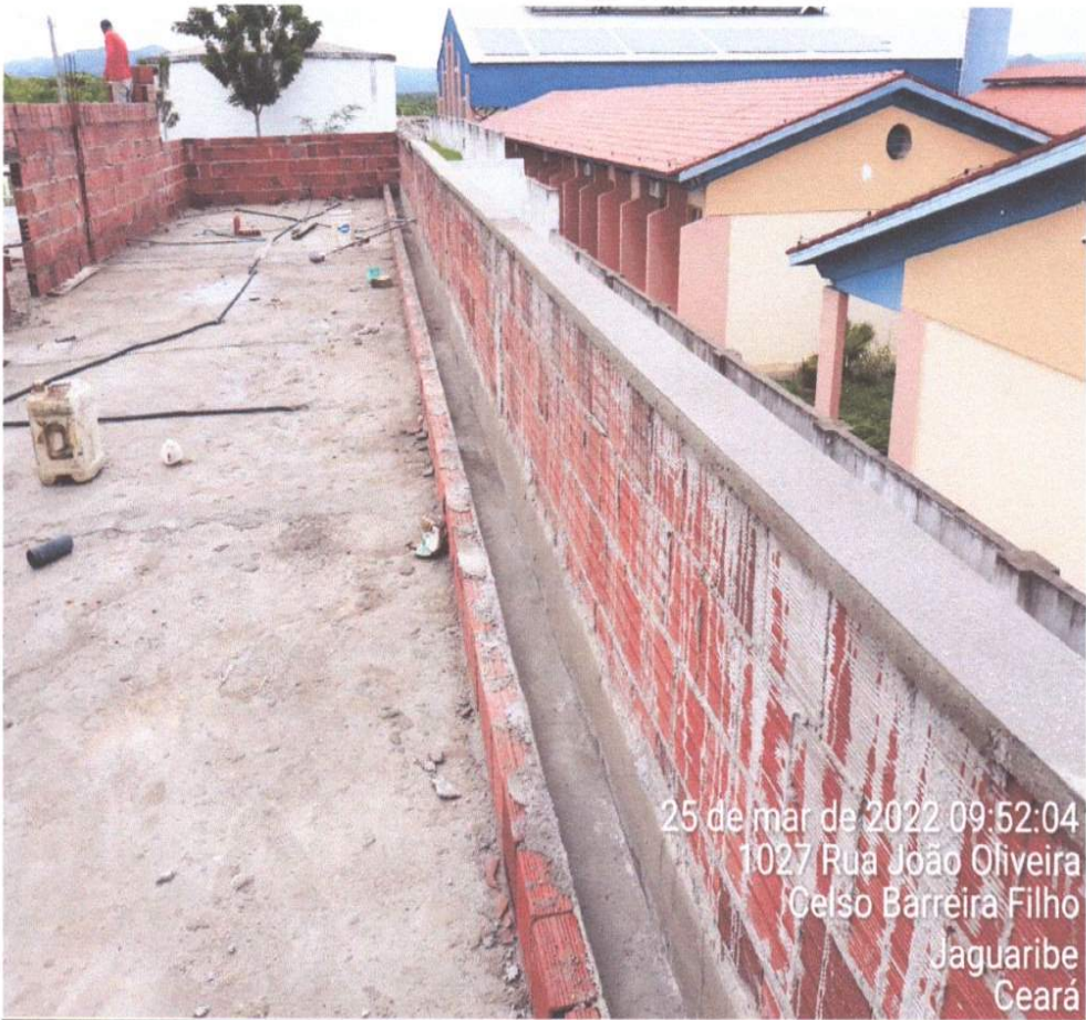
FOTO - 07 - CONSTRUÇÃO DO CHAPIM
