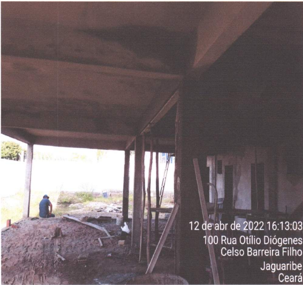
FOTO – 11 SERVIÇOS DE REBOCO NA PLACA E PILARES E VIRGAS
