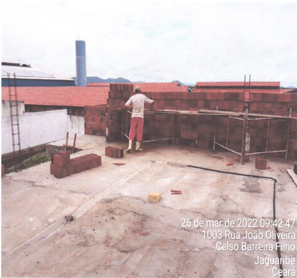
FOTO - 05 - SERVIÇOS DE ALVENARIA PARA A COBERTURA DO PREDIO
