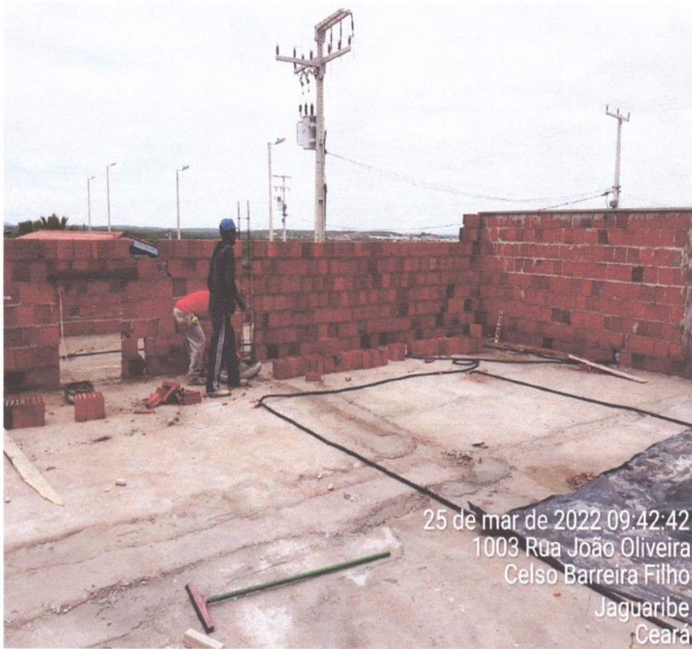
FOTO - 06 - SERVIÇOS DE ALVENARIA PARA A COBERTURA DO PREDIO
