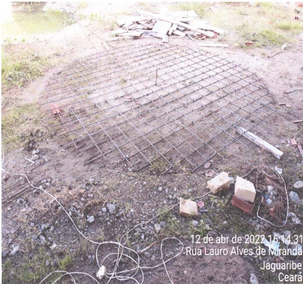
FOTO - 10 - ALMAÇÃO DE FERRO PARA PISO DA CAIXA DAQUA
