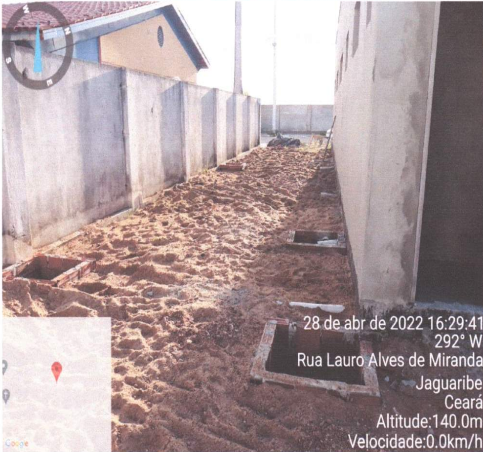
FOTO – 19 SERVIÇO DE LASTRO DE AREIA E CAIXA EM ALVENARIA (60X60X60cm) DE 1 TIJOLO COMUM, LASTRO DE CONCRETO
