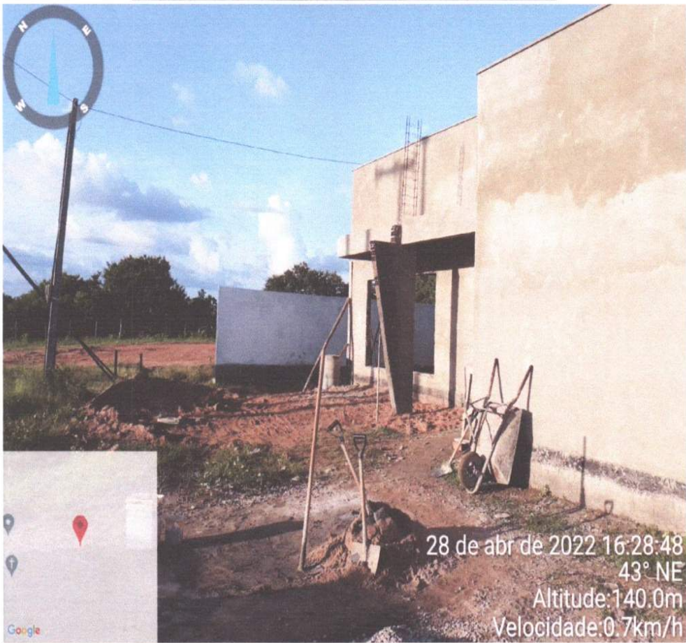
FOTO - 16 FRENTE DO PREDIO COM O REVESTIMENTO DE EMBOCO FEITO
