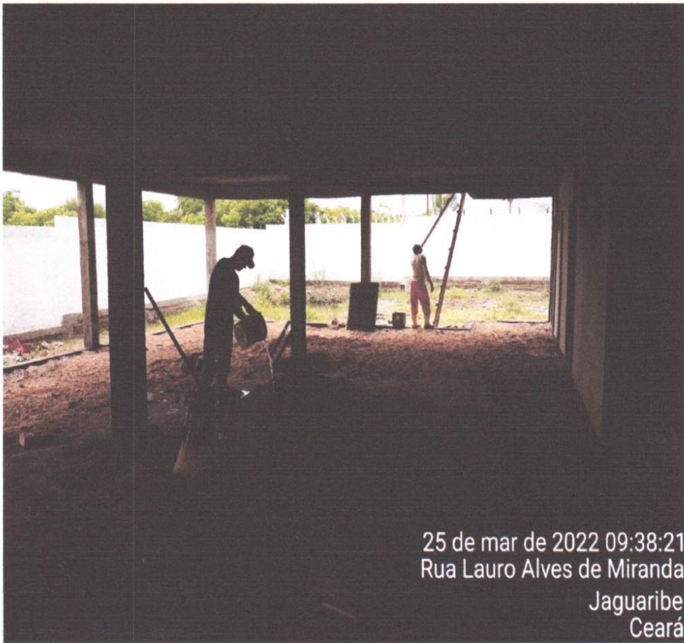
FOTO - 09 PREPARAÇÃO DE MASSA PARA AS ALVENARIAS DA COBERTURA
