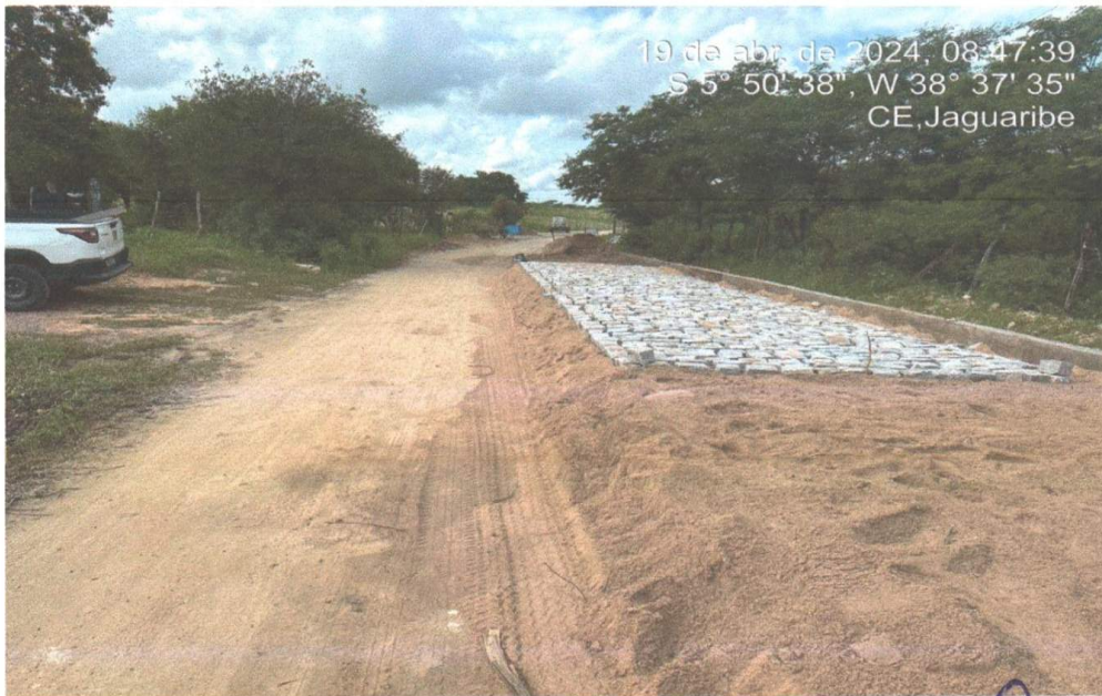
PAVIMENTO EM PARALELEPIPEDO SOBRE COLCHAO DE AREIA
