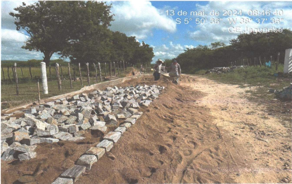
PAVIMENTO EM PARALELEPIPEDO SOBRE COLCHAO DE AREIA
