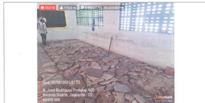
EXECUÇÃO DE DEMOLIÇÃO DE PISO CIMENTADO
