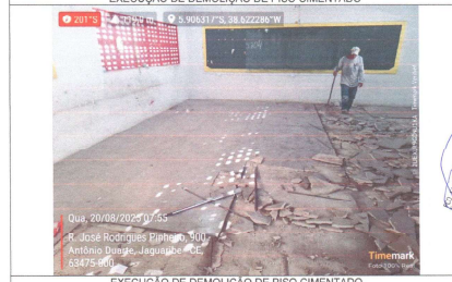
EXECUÇÃO DE DEMOLIÇÃO DE PISO CIMENTADO
