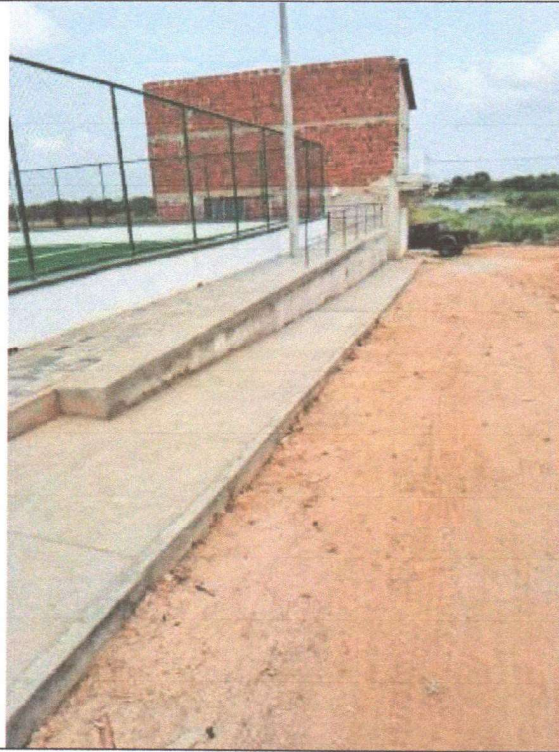
EXECUÇÃO DE PASSEIO
