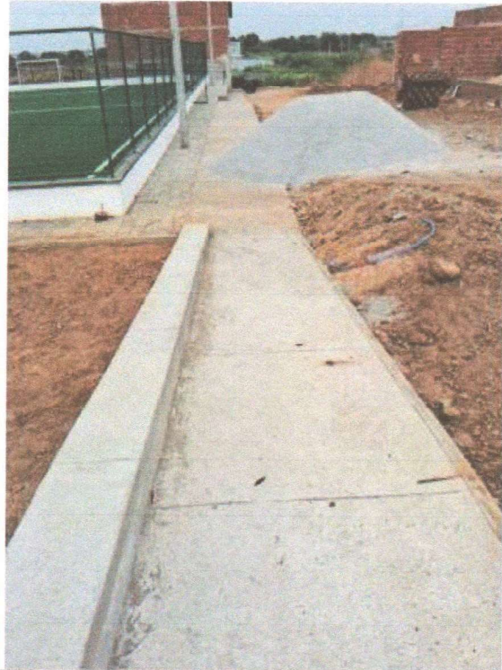
EXECUÇÃO DE PASSEIO
