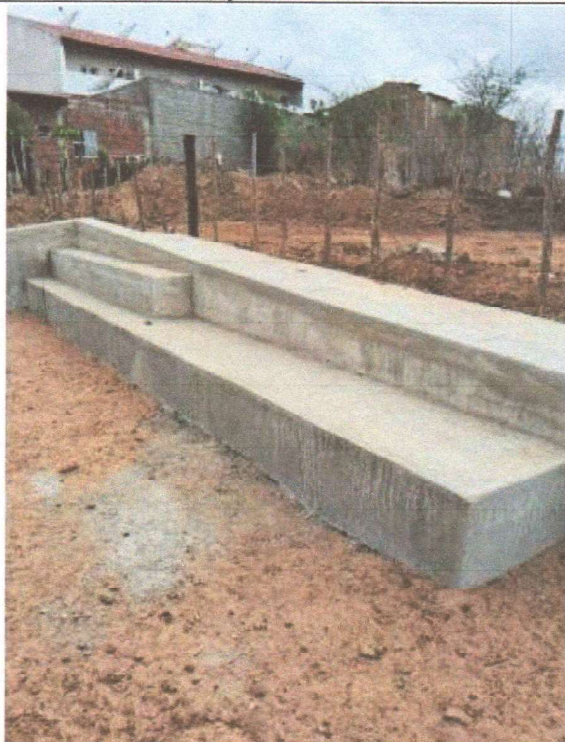
EXECUÇÃO DE PASSEIO
