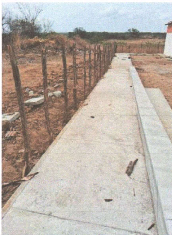
EXECUÇÃO DE PASSEIO
