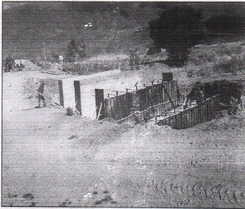
Imagem 04 - Fonte: Própria – construção dos muros de pedras – referente ao item 3.3
