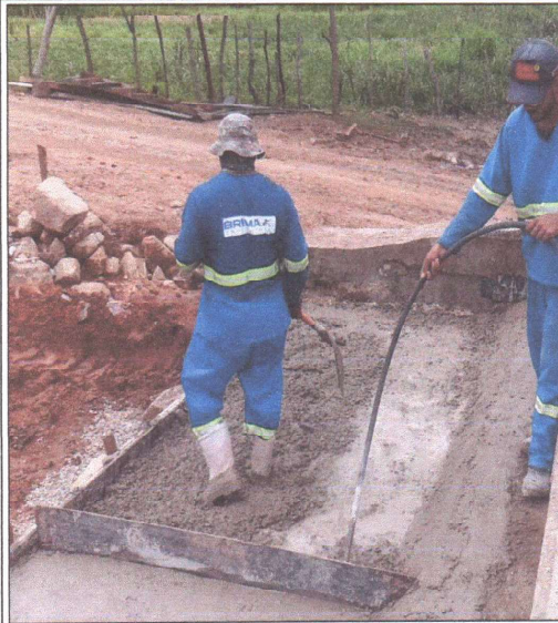
APLICAÇÃO DE AÇO CA-50 E CONCRETAGEM
