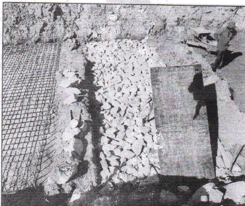
Imagem 02 - Fonte: Própria – Embasamento para estabiilização do solo – referente ao item 3.5
