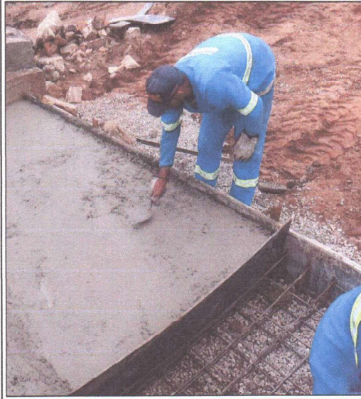
APLICAÇÃO DE AÇO CA-50 E CONCRETAGEM
