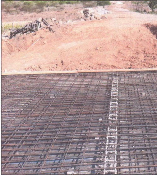
ARMAÇÃO DE AÇO DA LAJE
