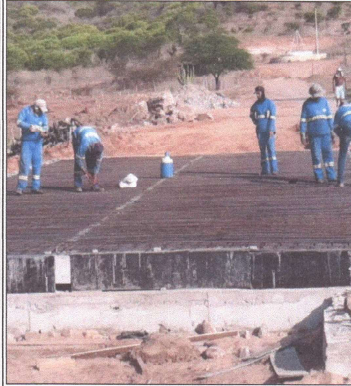
ARMAÇÃO DE AÇO DA LAJE
