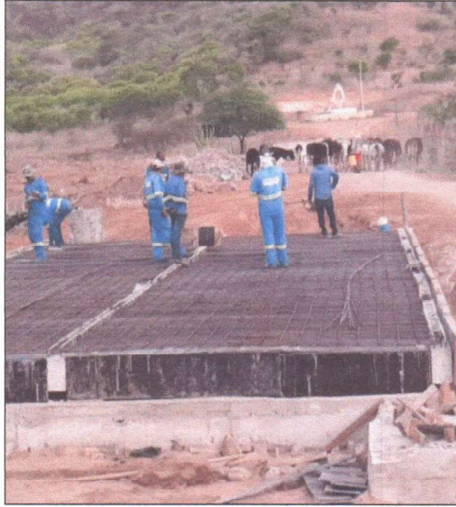
ARMAÇÃO DE AÇO DA LAJE
