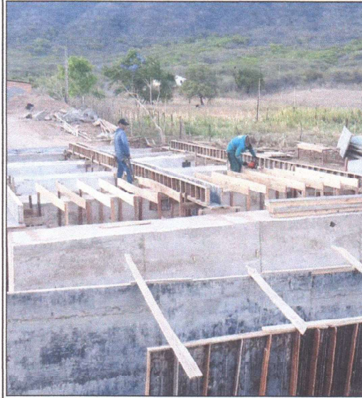
FABRICAÇÃO DE FÔRMA PARA VIGAS
