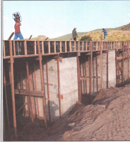
CIMBRAMENTO DE ASSOALHO PARA LAJE
