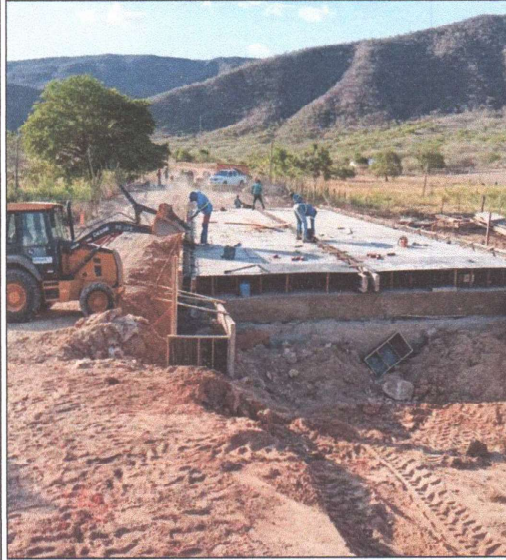
CONCRETAGEM DE VIGAS
