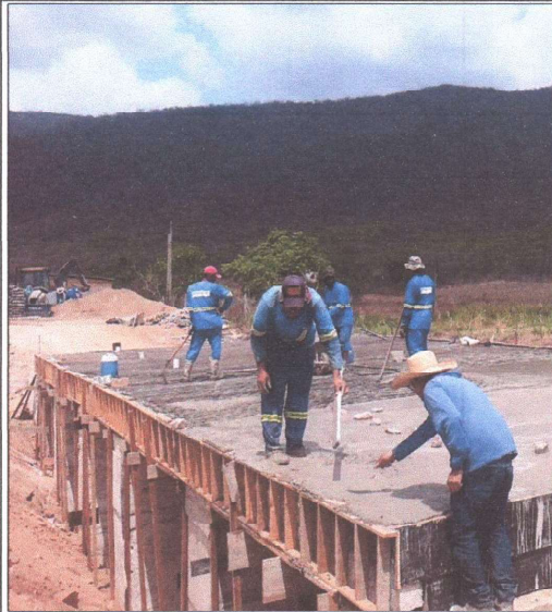
CONCRETAGEM DE LAJE
