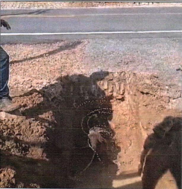
EXECUÇÃO DE PASSAGEM MND
