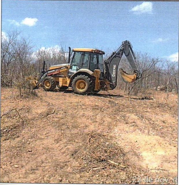
REGULARIZAÇÃO DE TERRENO PARA IMPLANTAÇÃO DE BASE DO RESERV. ELEV.
