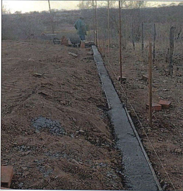
REGULARIZAÇÃO DE TERRENO PARA IMPLANTAÇÃO DE BASE DO RESERV. ELEV.
