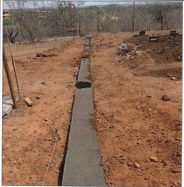
REGULARIZAÇÃO DE TERRENO PARA IMPLANTAÇÃO DE BASE DO RESERV. ELEV.
