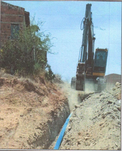
ASSENTAMENTO DE TUBO DE ÁGUA
