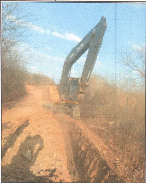
ESCAVAÇÃO MECANIZADA DE VALA
