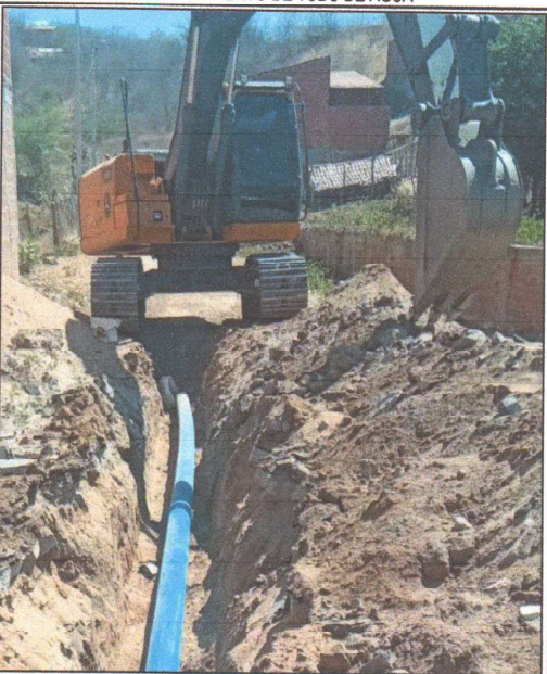
ASSENTAMENTO DE TUBO DE ÁGUA
