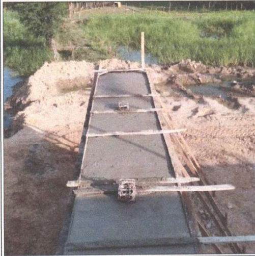
EXECUÇÃO DE ALVENARIA EM PEDRA ARGAMASSADA
