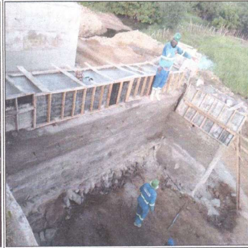
EXECUÇÃO DE ALVENARIA EM PEDRA ARGAMASSADA
