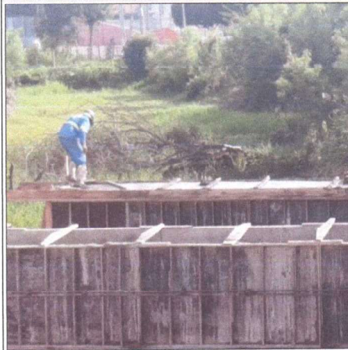
CONFEÇÃO DE FORMAS PARA ALVENARIA DE PEDRA ARGAMASSADA
