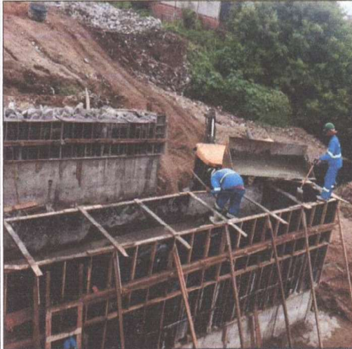
EXECUÇÃO DE ALVENARIA EM PEDRA ARGAMASSADA
