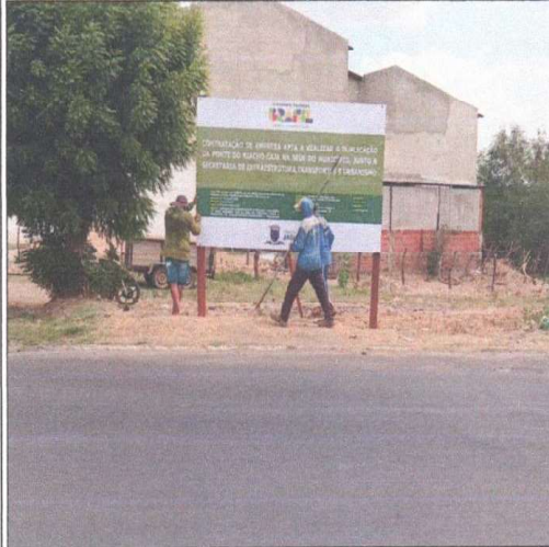
FORNECIMENTO E INSTALAÇÃO DE PLACA DE OBRA
