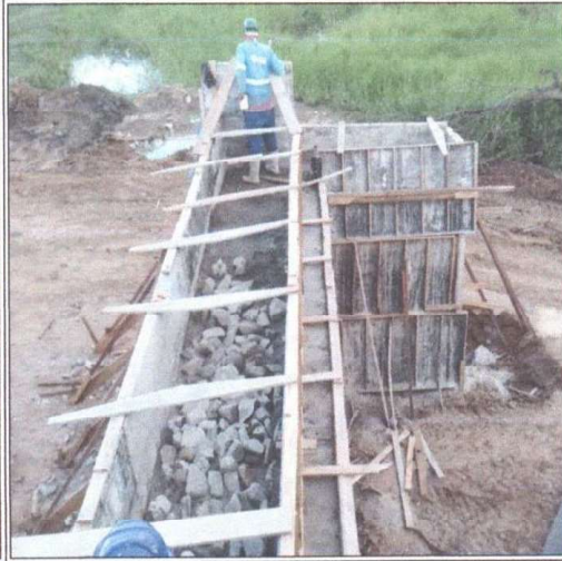
EXECUÇÃO DE ALVENARIA EM PEDRA ARGAMASSADA (ALAS)
