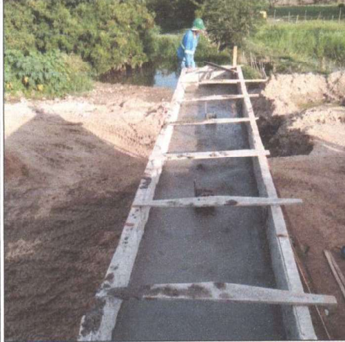
EXECUÇÃO DE ALVENARIA EM PEDRA ARGAMASSADA
