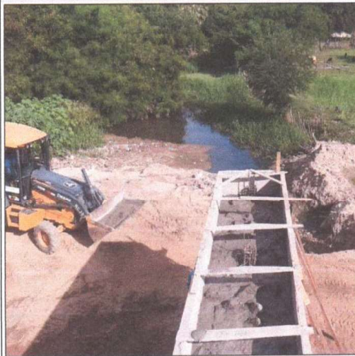
EXECUÇÃO DE ALVENARIA EM PEDRA ARGAMASSADA
