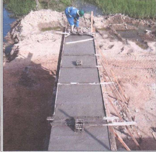
EXECUÇÃO DE ALVENARIA EM PEDRA ARGAMASSADA
