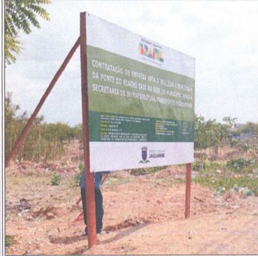
FORNECIMENTO E INSTALAÇÃO DE PLACA DE OBRA
