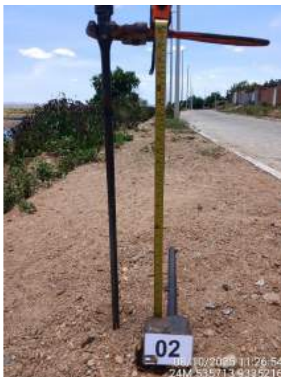
Foto 02 – Material de aterro compactado na base em ST 02. Av. Maria Marta – Revestimento piso intertravado.
