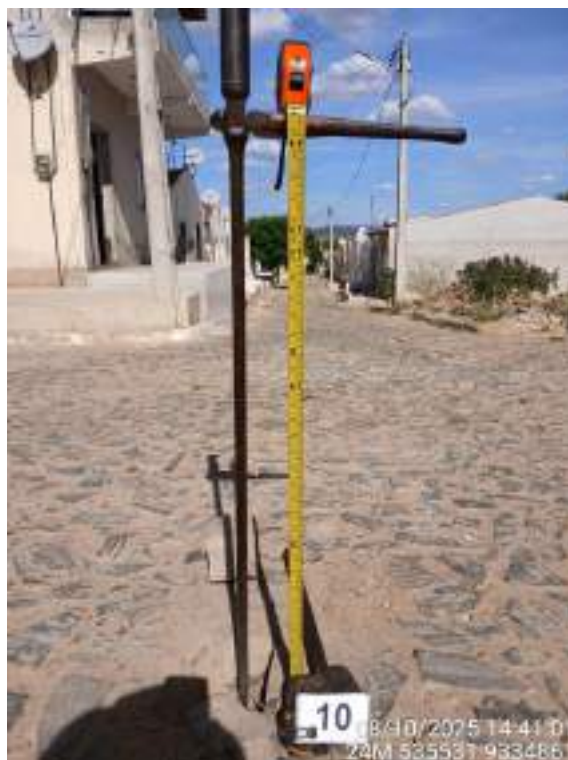
Foto 10 – Aterro compactado na base em ST 10.
