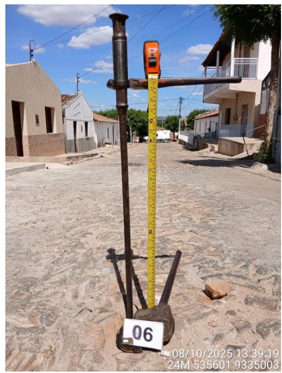
Foto 06 – Solo argiloso sobre rocha em ST 06 Rua São Vicente de Paula - Revestimento em pedra tosca.
