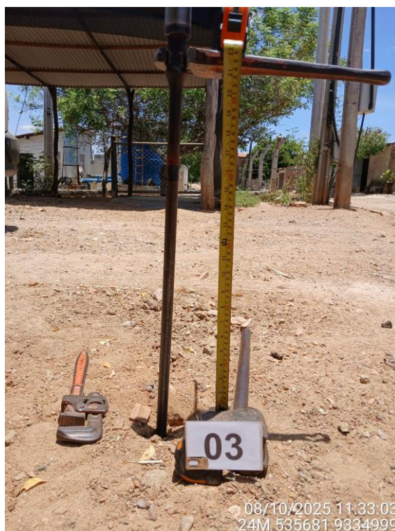
Foto 03 – Material de aterro compactado na base em ST 03. Av. Maria Marta – Revestimento piso intertravado.
