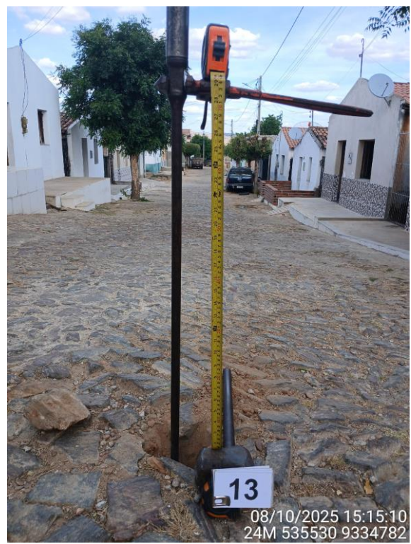
Foto 13 Solo argiloso sobre rocha em ST 13. R. Francisco das Chagas Nunes/R. Manoel costa Moraes, com revestimento asfáltico.
