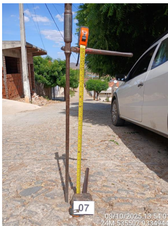
Foto 07 – Solo argiloso sobre rocha em ST 07 Rua Manoel Nunes de Sousa - Revestimento em pedra tosca.
