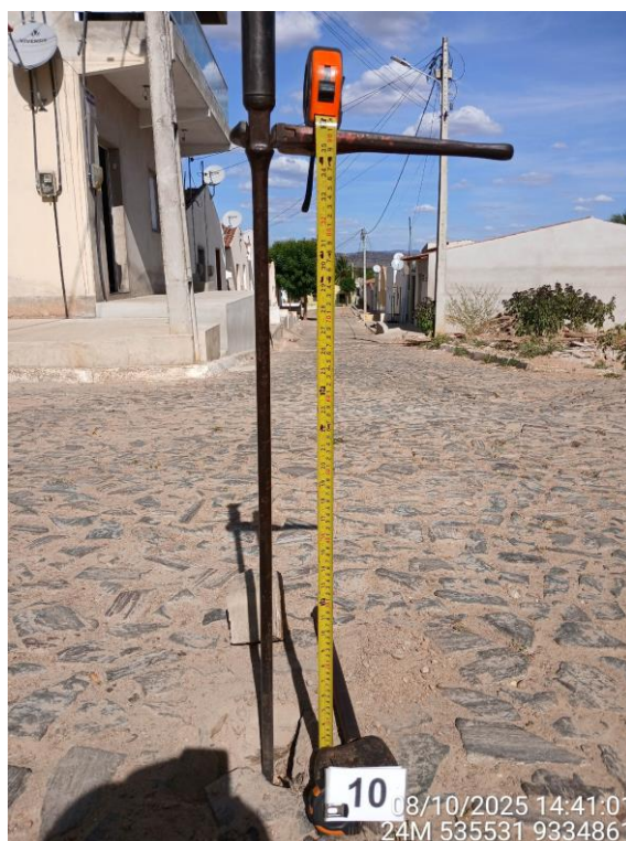
Foto 10 – Aterro compactado na base em ST 10.
