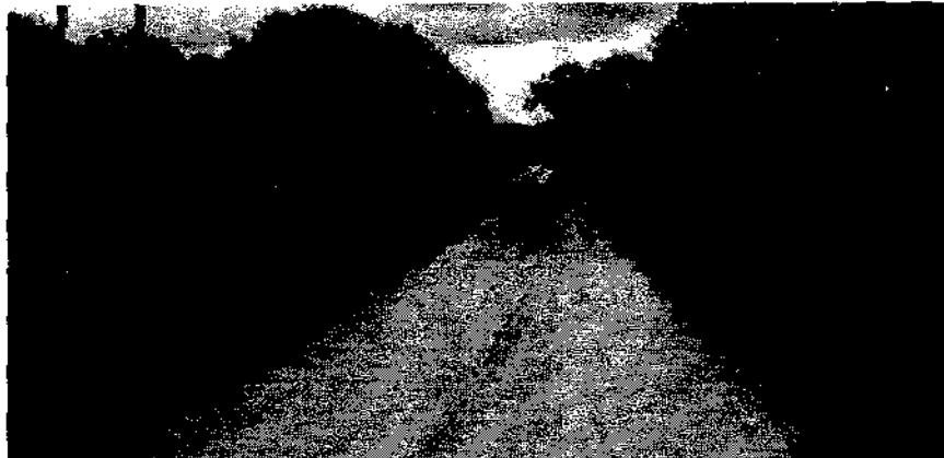
Foto 156 – Trecho intermediário entre S 79 e S 78 de solo areno argiloso sobre faixas de rocha granítica branda e sã por vezes aflorante e topografia aplainada.
