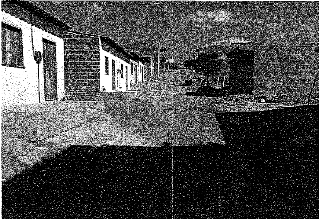
Foto 12 – Travessa SDO 02 ( Curralinho ) – Coordenadas : 540821 / 9347022
