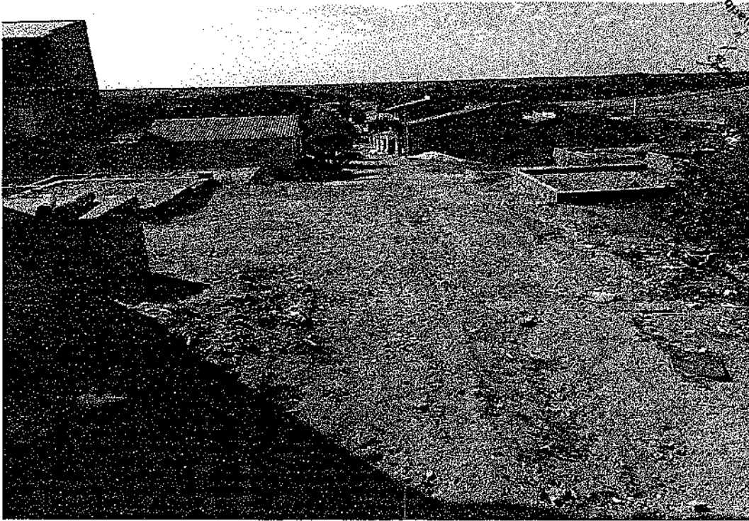
Foto 11 – Travessa SDO 02 ( Curralinho ) – Coordenadas : 540821 / 9347022
