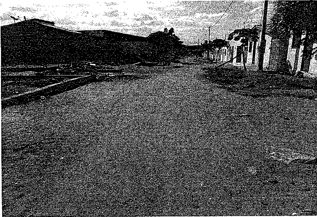
Foto 25 : Rua Jose Matias Neto - Bairro Americo Bezerra . Coordenadas : 541249 / 9348128
