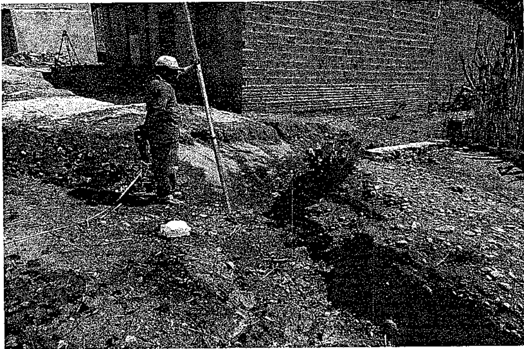
Foto 09 – Travessa SDO 01 ( Curralinho ) - Coordenadas : 540708 / 9347074
