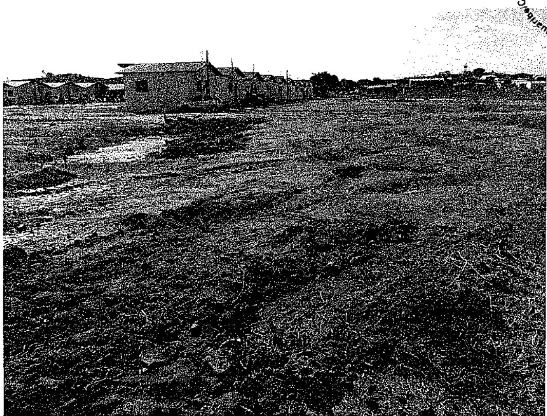
Foto 03: Rua projetada 02 Bairro Jose Pessoa Filho. Coordenadas 541820 / 9346919
