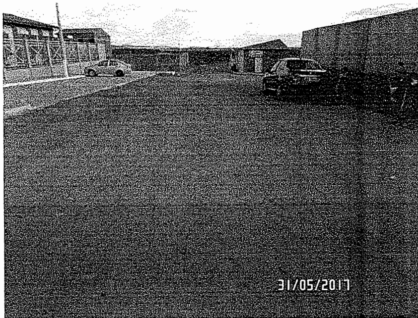
FOTO 07: TRECHO FINAL DA TRAVESSA 04
