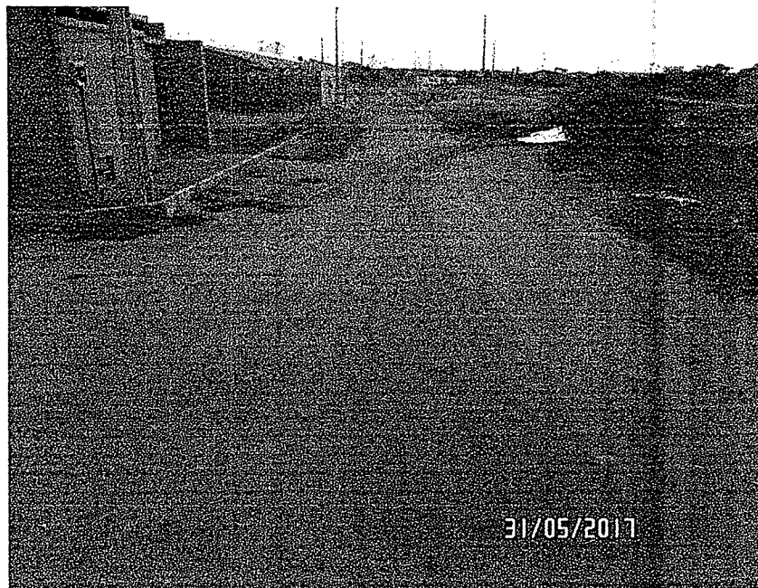
FOTO 02: RUA PROJETA A TRECHO INTERMEDIÁRIO
